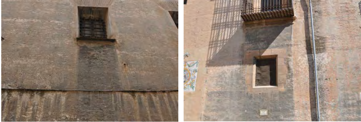
Fig. V.125. Ejemplos de lavado diferencial.
