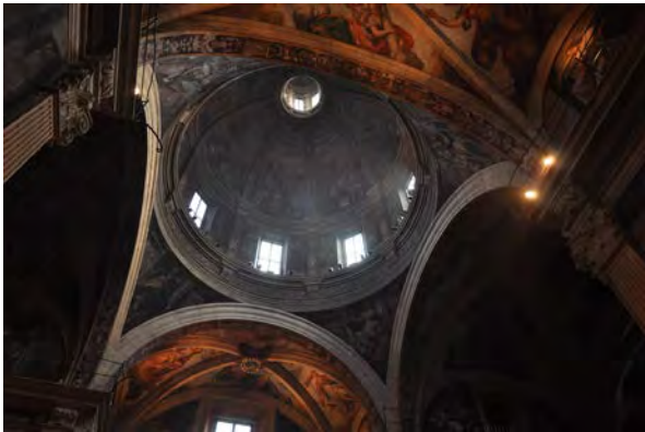
Fig. A.21. Vista general de la cúpula por el interior.
