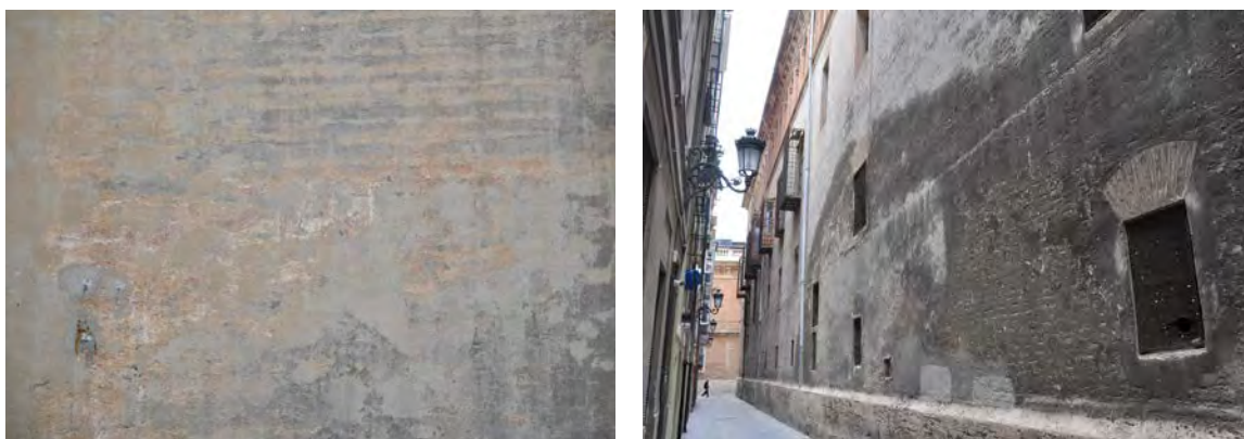
Fig. V.123. Ejemplos de zonas con costra fina (izq) y gruesa (dcha).
