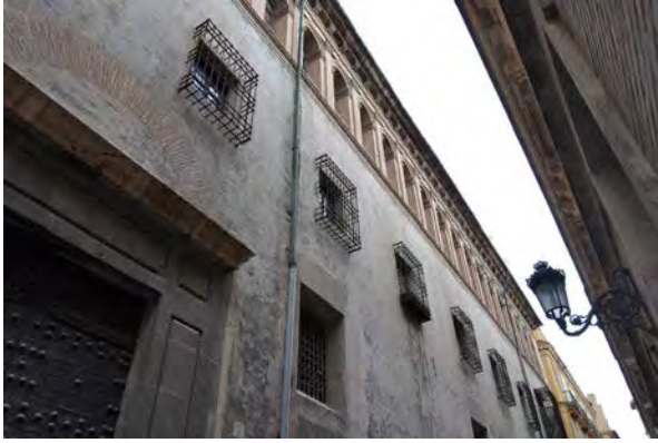
Fig. A.5. Vista parcial derecha de la fachada sur.
