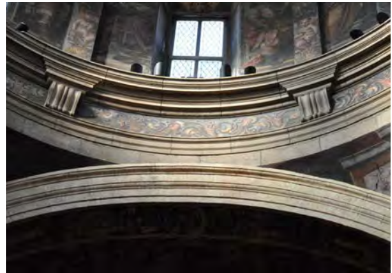
Fig. A.22. Encuentro de la cúpula con los arcos fajones.
