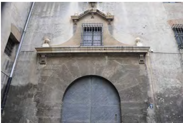
Fig. A.39. Portada de la fachada norte.
