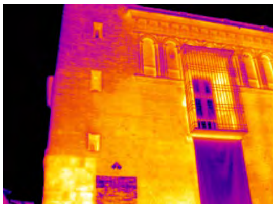
Fig. V.155. Termografía de la fachada sur.
