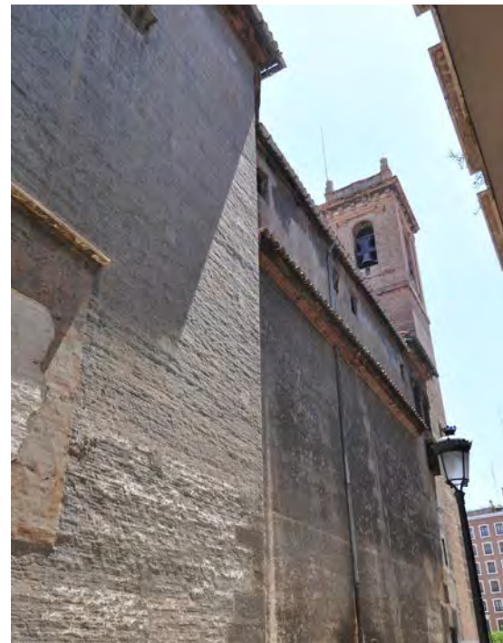
Fig. A.27. Fachada oeste (derecha).
