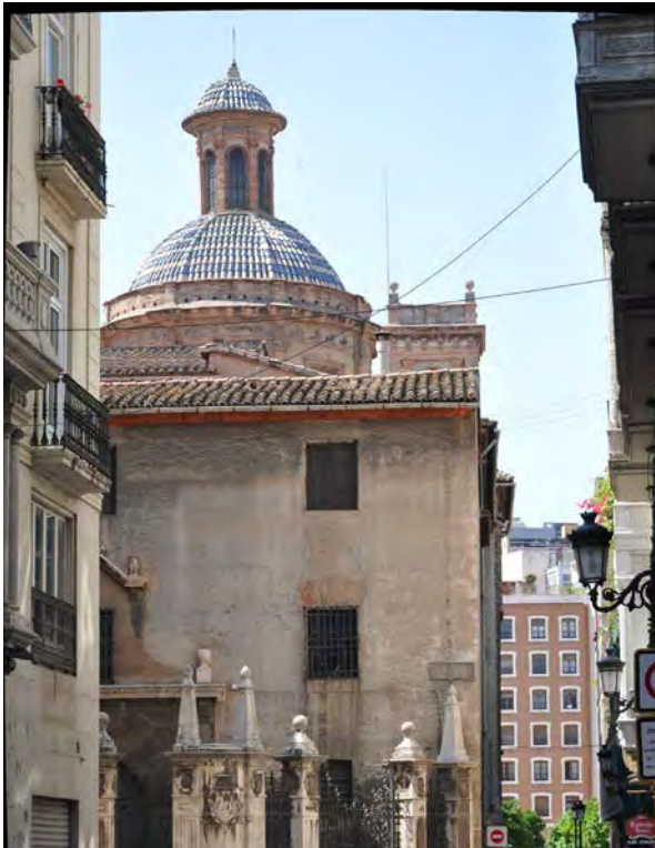
Fig. A.11. Vista parcial de la fachada norte y cúpula.
