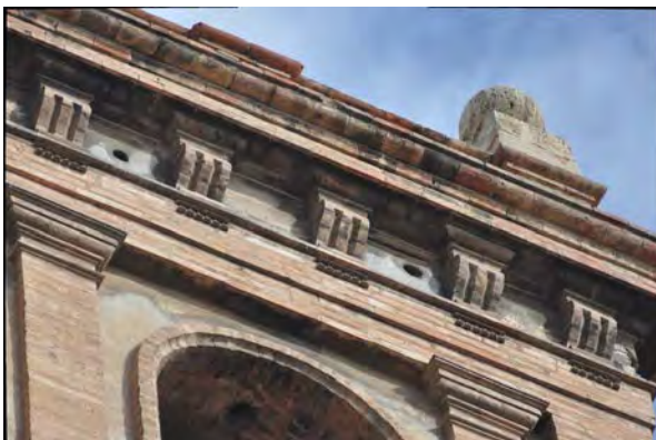
Fig. A.15. Esquina sudeste de la parte superior de la fachada.
