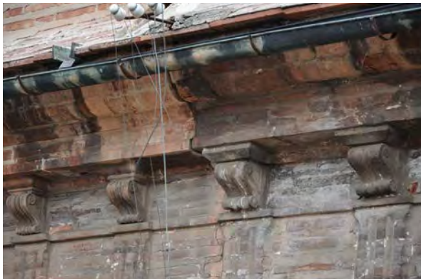
Fig. A.13. Encuentro de dos fábricas distintas (fachada sur).
