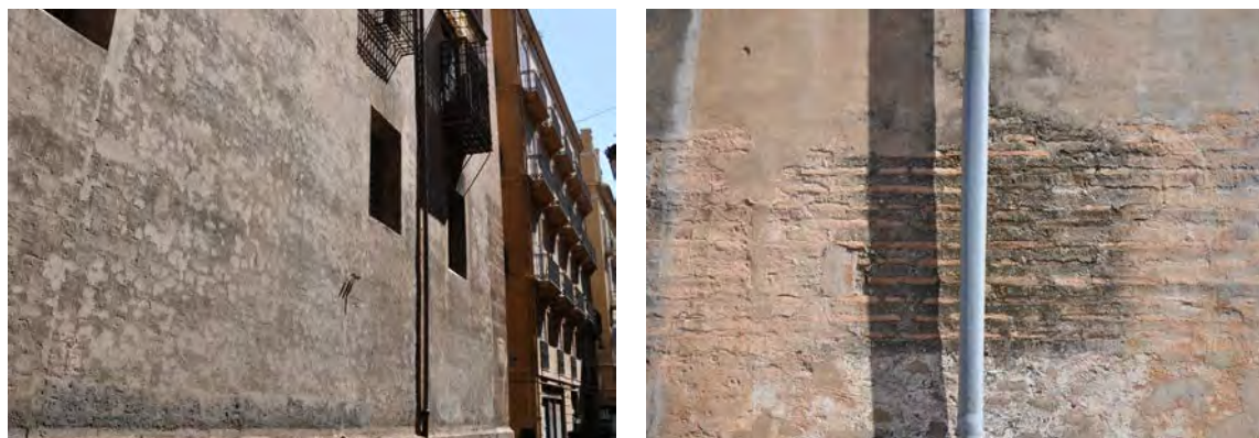
Fig. V.112. Vista general y detalle de la tapia valenciana.
