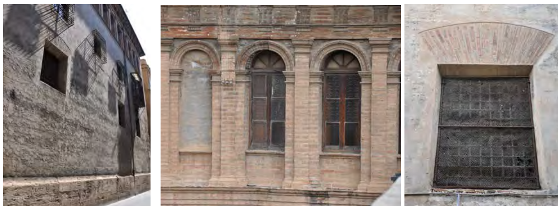
[Fig. III.15] Huecos de iluminación de las celdas y otros aposentos.
