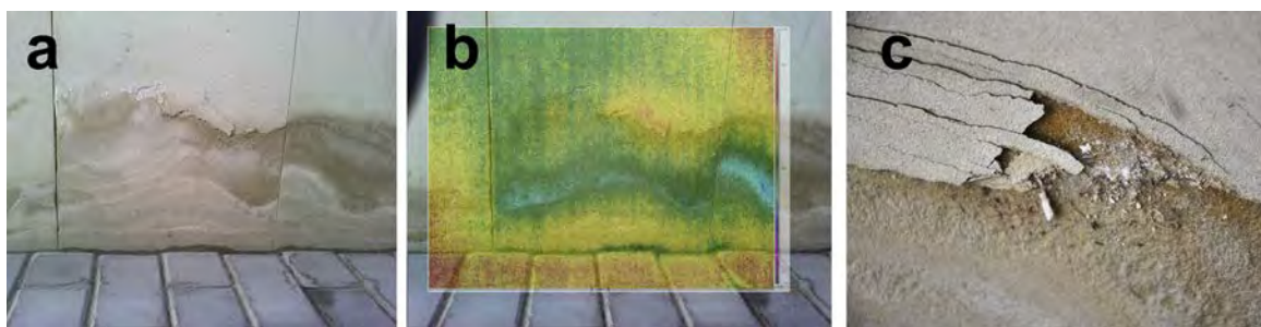
Fig. V.181. Zócalo con escamas, (a) foto, (b) termografía y (c) detalle de eflorescencias.
