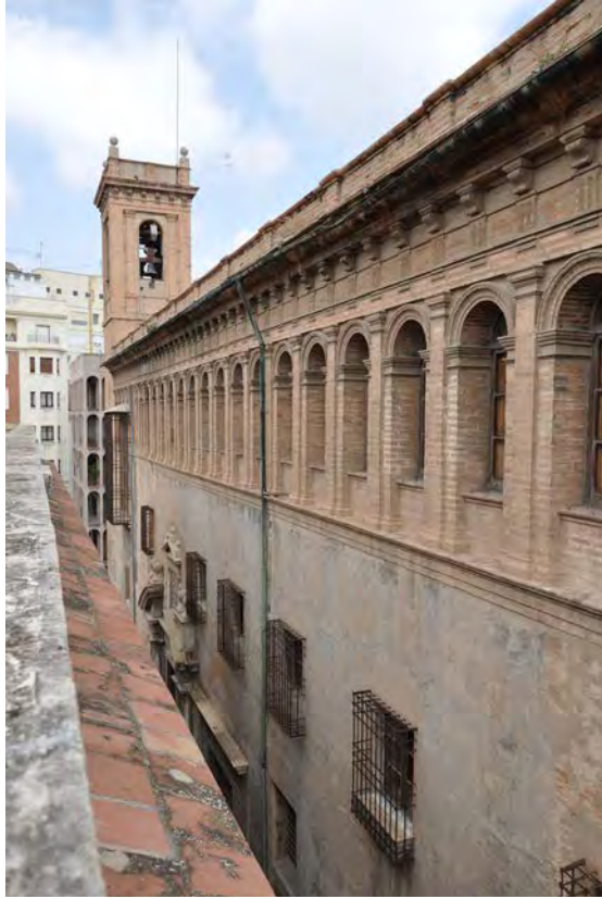
Fig. A.1. Fachada principal (sur).
