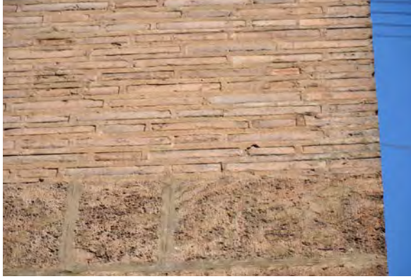
Fig. A.29. Detalle de la fábrica vista.
