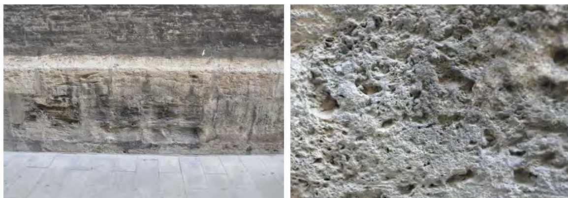
Fig. V.139. Ejemplos de erosión pétreo.
