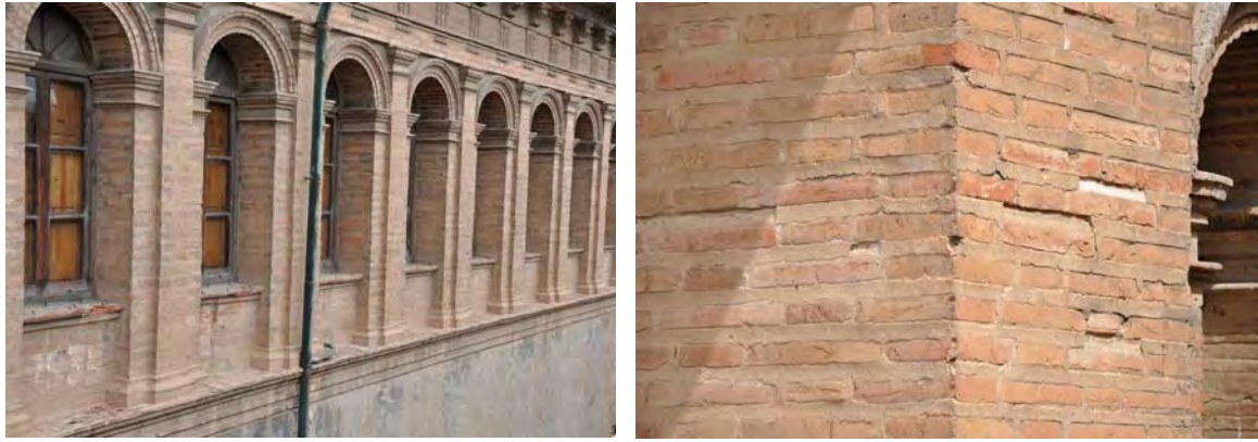
Fig. V.113. Ladrillos de la parte superior de las fachadas sur y este.
