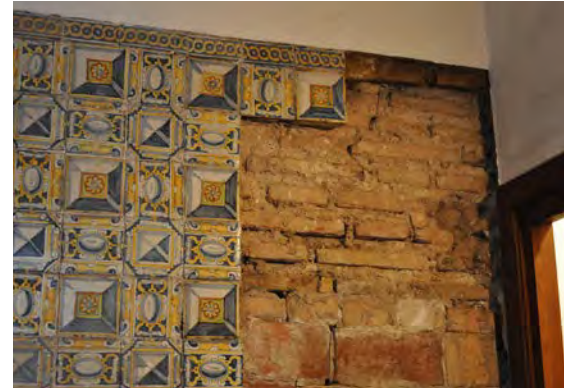
Fig. A.20. Azulejos y el muro de soporte (muro interior).
