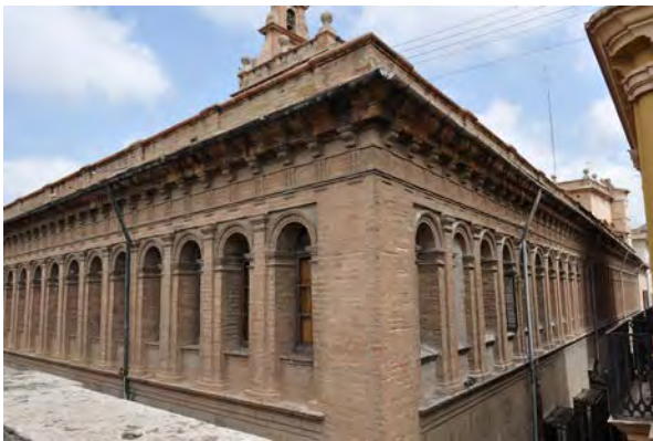
Fig. A.7. Esquina sudeste de la parte superior de la fachada.
