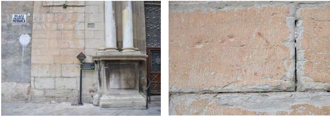
Fig. V.135. Ejemplos de las pátinas rojizas.
