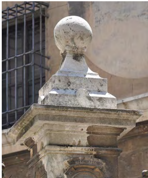
Fig. A.28. Remate del cerramiento del acceso norte.
