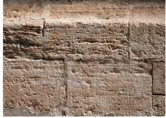
Fig. A.30. Piedra del zócalo perimetral.
