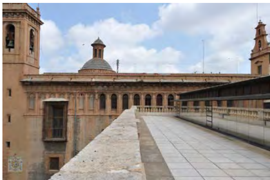
Fig. A.3. Vista parcial de la fachada principal (sur).
