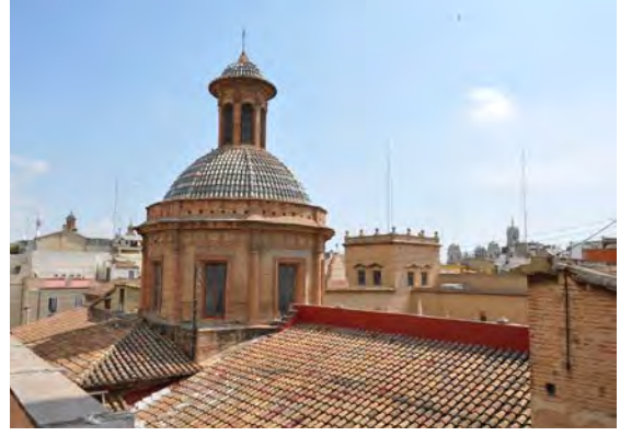
Fig. A.6. Cubierta y cúpula desde la C/ Creu Nova.
