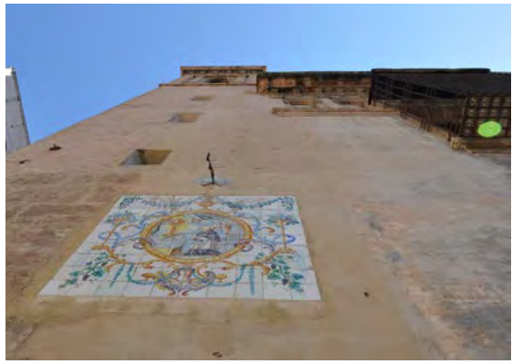
Fig. A.26. Vista rasante de la torre campanario.
