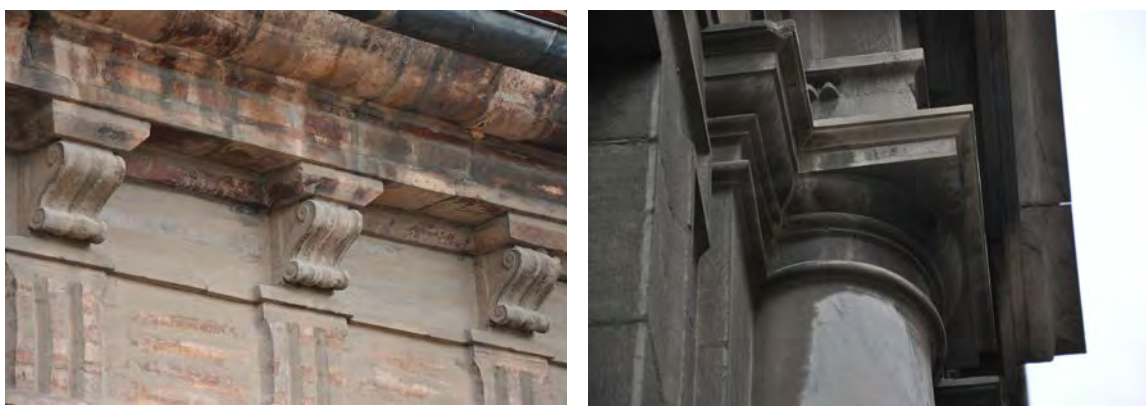
Fig. V.122. Ejemplos de zonas con acumulación de polvo y suciedad.
