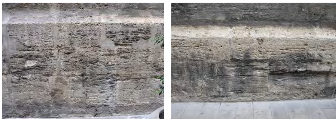
Fig. V.138. Ejemplos de erosión pétreo.
