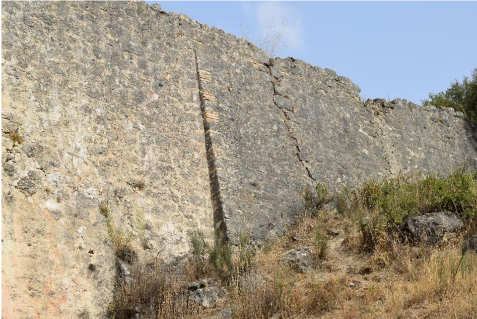
FIGURA 12. Fotografía de los refuerzos ataludados presentes en el paramento del Caz. Fotografía de Autor.
