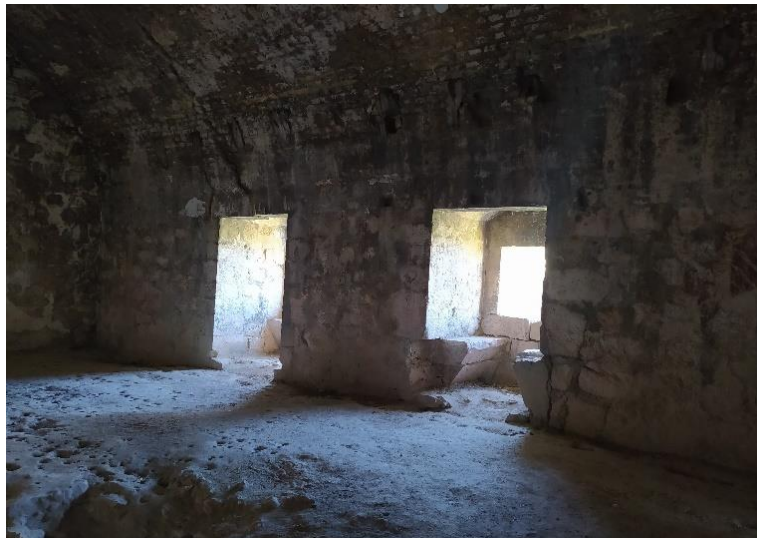
FIGURA 27. Vista del paramento interior Oeste, donde se ve la situación interna de las ventanas. Fotografías de Autor.
