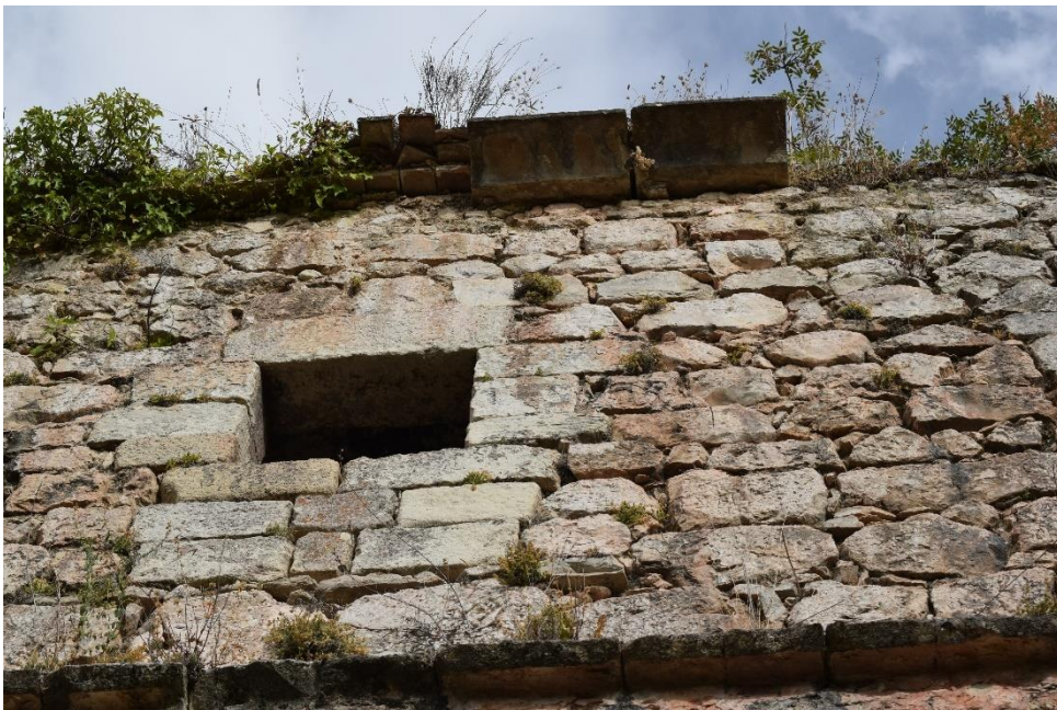
FIGURA 14. Fotografía del vuelo de piedra de la fachada principal para alejar el agua de lluvia de la misma. Fotografía de Autor.
