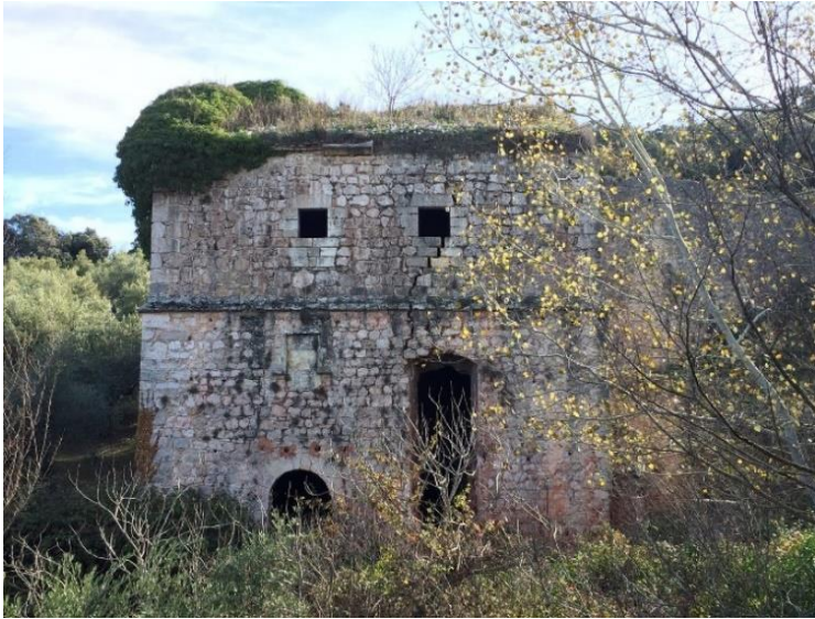
FIGURA 18. Vista del alzado oeste del edificio. Fotografía obtenida de: https://listarojapatrimonio.org/ficha/molino-del-cubo/#gallery-2
