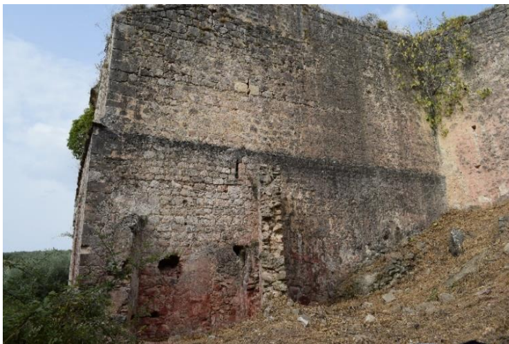
FIGURA 21. Vista del alzado Sur. Fotografía de Autor.
