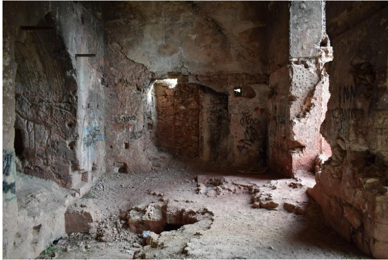
FIGURA 22. Vista del paramento interior Sur, donde se alojarían los artilugios de molienda. Fotografía de autor.
