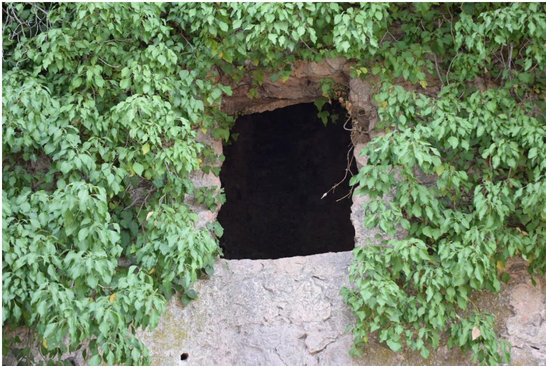
FIGURA 20. Fotografía del orificio realizado a la altura de las escaleras en la cara norte. Fotografía de Autor.
