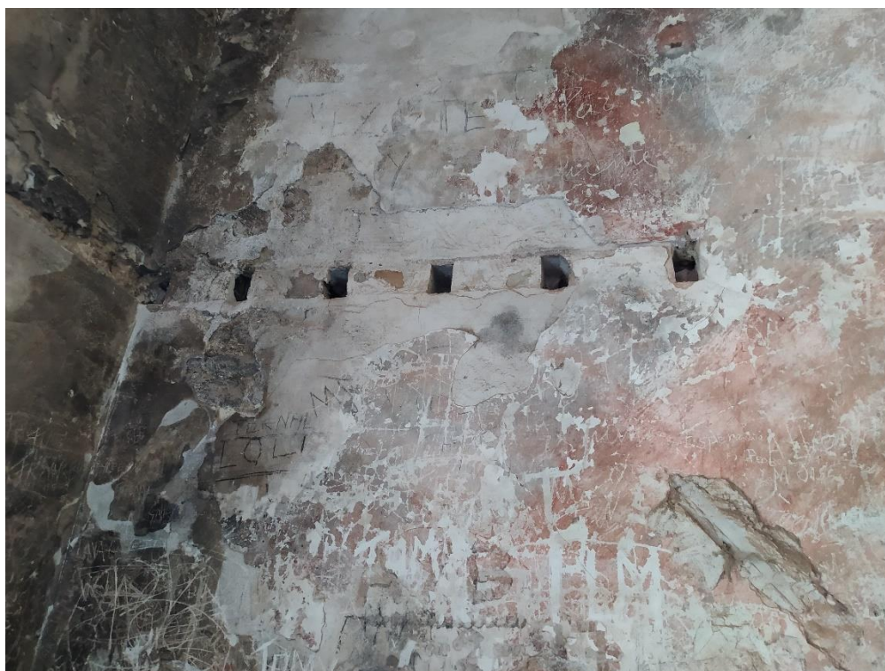
FIGURA 24. Fotografía de los espacios donde encajaban las vigas de madera que componían la segunda altura de la planta baja. Fotografía de Autor.
