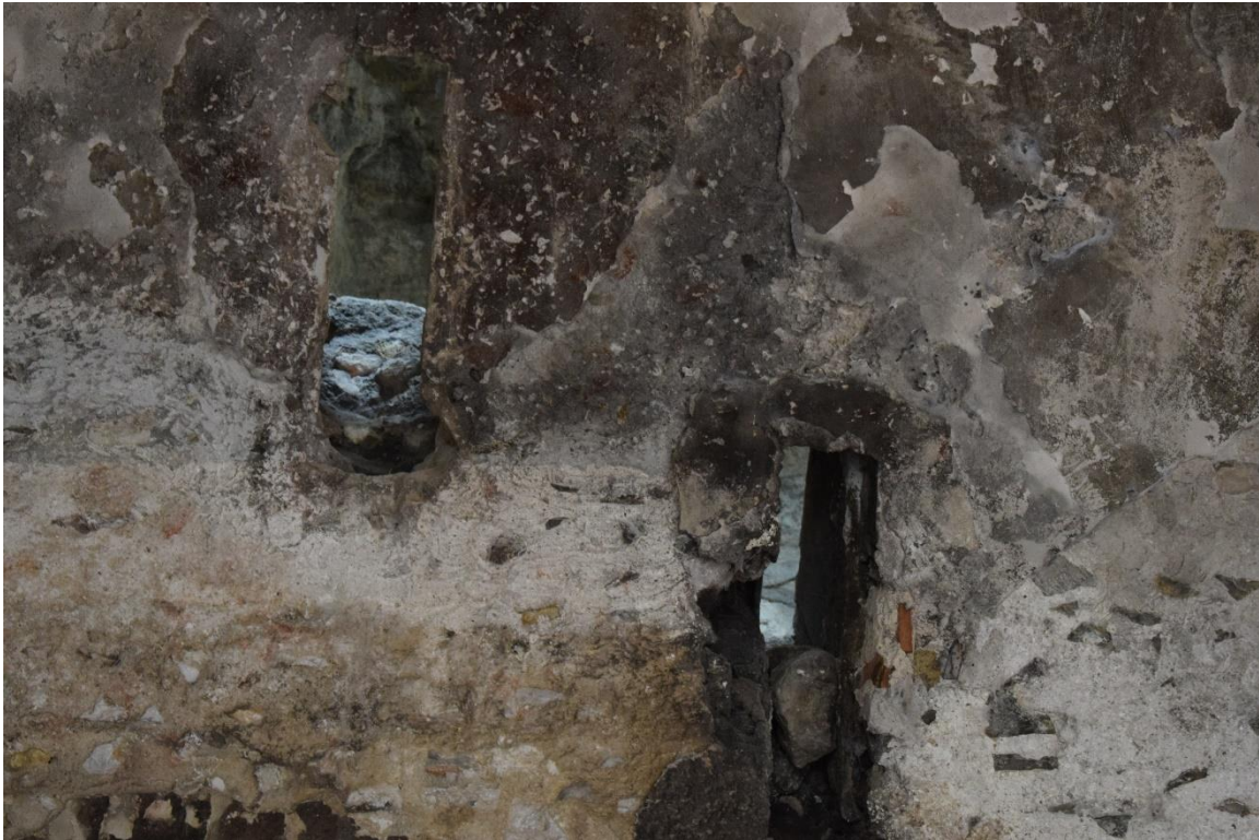
FIGURA 28. Fotografía de los orificios que conectan el piso alto con la planta baja. Fotografía de Autor.
