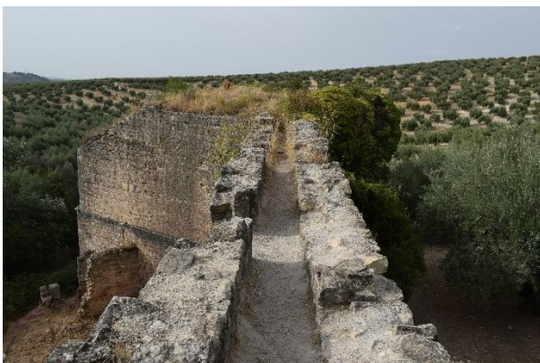
FIGURA 13. Vista del Caz hacia el cubo del molino. Fotografía de Autor.
