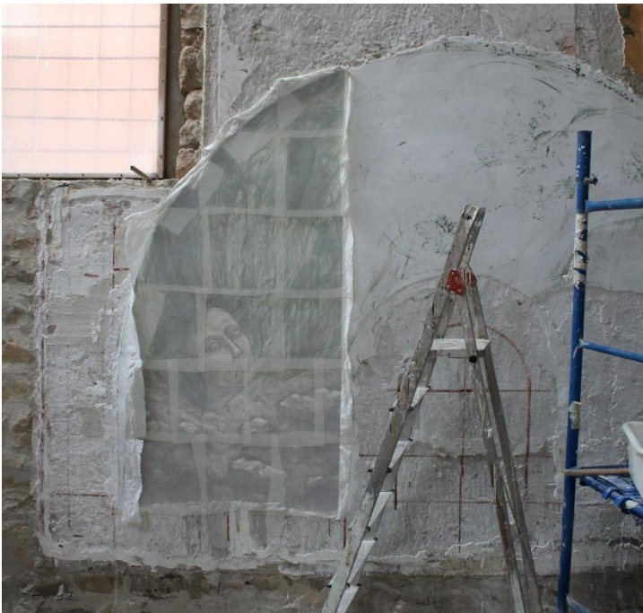
Figura 8. Finalización del proceso de encolado. Fuente: Minguell i Cardenyes, 2021.
