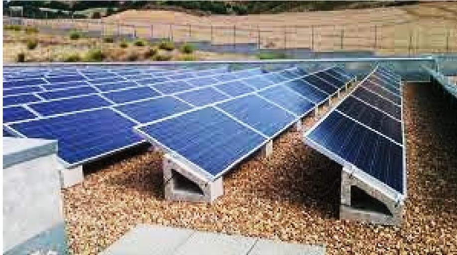
**Figura 23.** Soportes de hormigón para placas fotovoltaicas. Fuente: SolarBloc.
