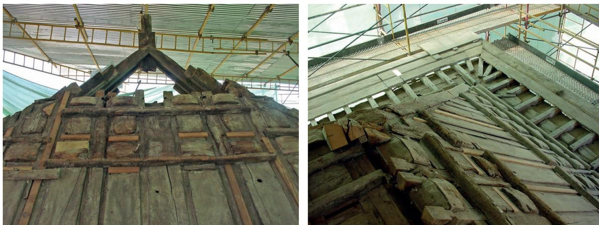
Figura 2. Trasdós del techo del Cuarto Real de Santo Domingo, fotos hechas durante la restauración realizada por Antonio Almagro y Antonio Orihuela en el año 2002, en las que vemos que la armadura de lazo no es simplemente decorativa, sino que esta componiendo la estructura resistente de la cubierta sobre la que se coloca la teja. (E. Nuere).
