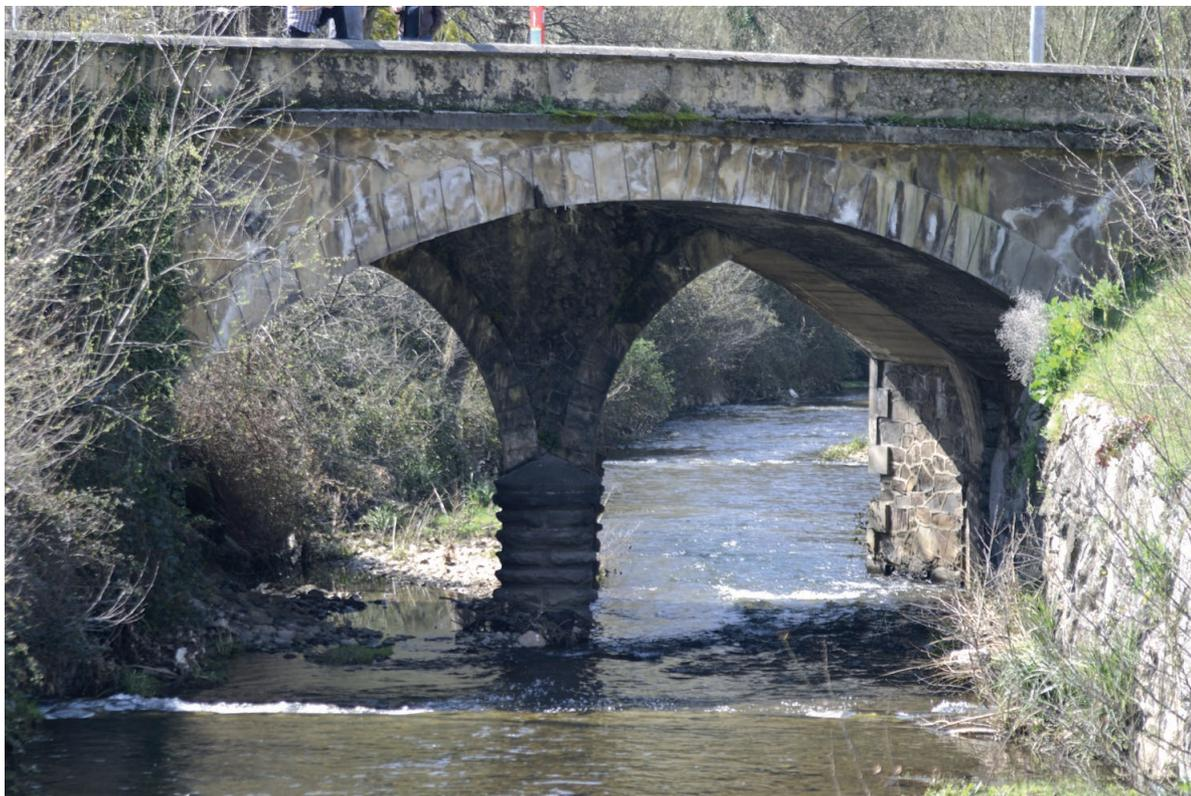
Figura 6. Estructura primitiva del puente de Cabojal debajo de la actual, aguas abajo. Fotografía de la autora.
