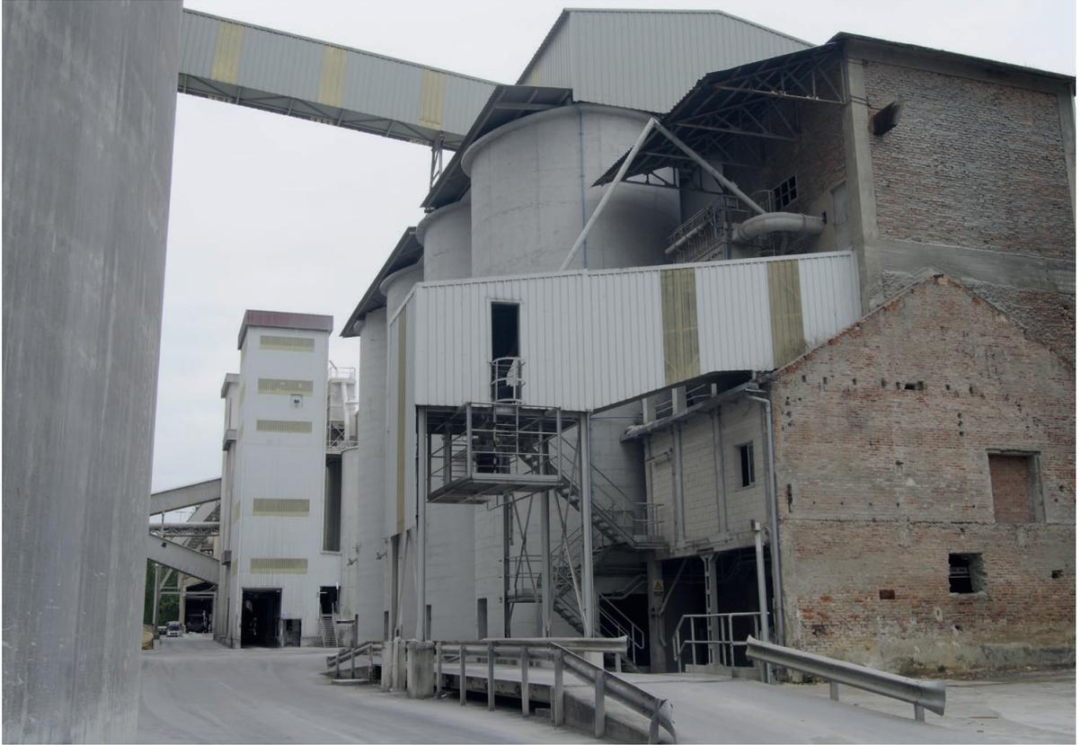
Figura 11. Fábrica de Cementos Tudela Veguín. A la derecha de la imagen los restos de los primitivos silos de almacenamiento y a continuación los actuales de planta circular. Fotografía de la autora.
