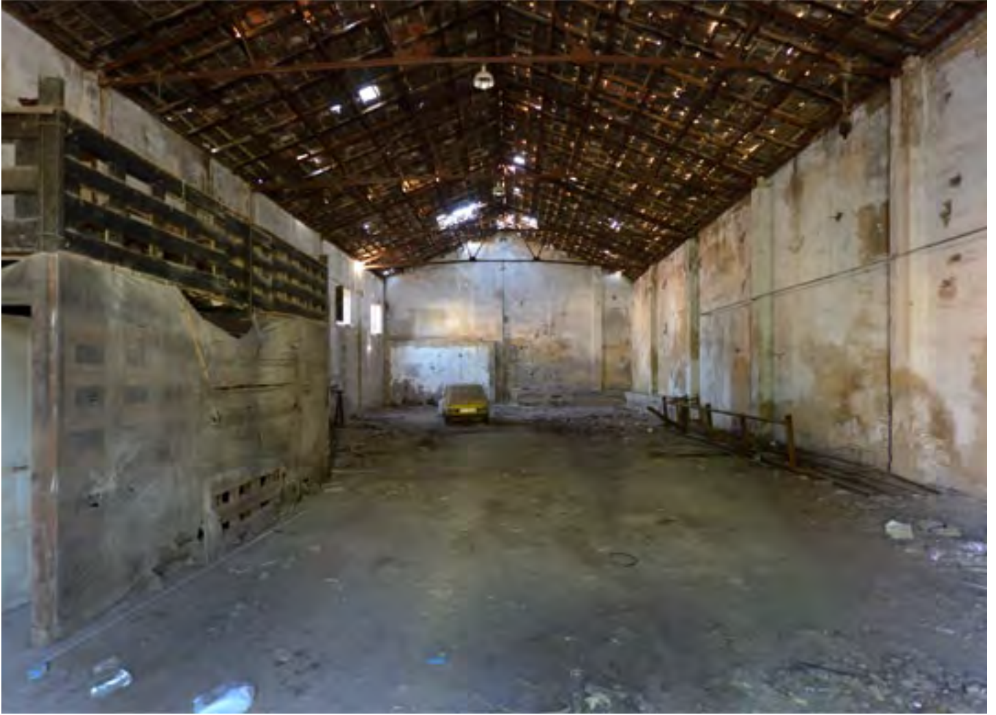
Nave de la Fábrica del Hielo, 2012
