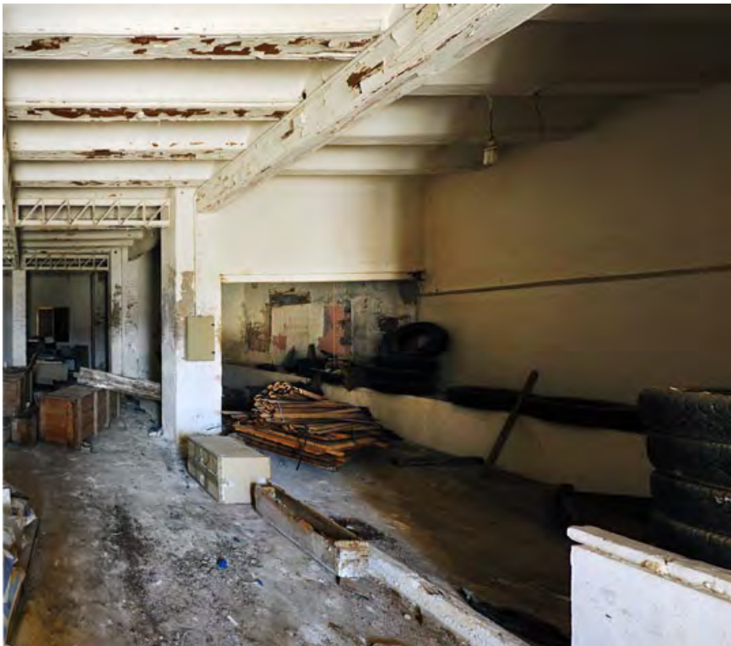
Fig. 6. Fotografía actual del interior de la Casa dels Bous . Fotografía de Joaquín Berchez.
