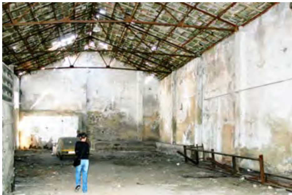
Fig. 8. Interior de la nave Oeste de la Fábrica de Hielo
