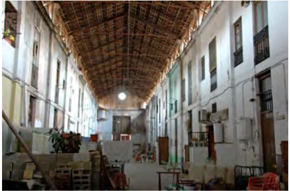
Fig. 9. Imagen del interior de la Lonja, quizás lo más notable del edificio, con su gran espacio central de doble altura, con los vanos y balcones laterales, que configuran la doble fachada interior del edificio, de principios de siglo, que constituye una joya para la ciudad de Valencia, junto al mar...desaparecería.
