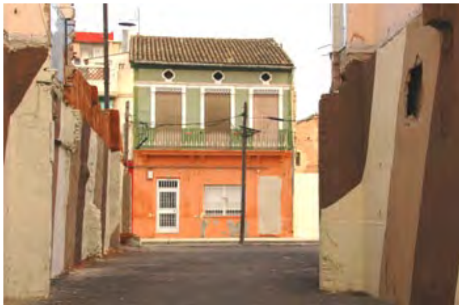
Fig. 4. Imagen de una de las zonas afectadas por los derribos, con la edificación tradicional al fondo, que sería derribada, y la parcela en primer término resultante de los derribos, con la señalización de las medianerías resultantes.
