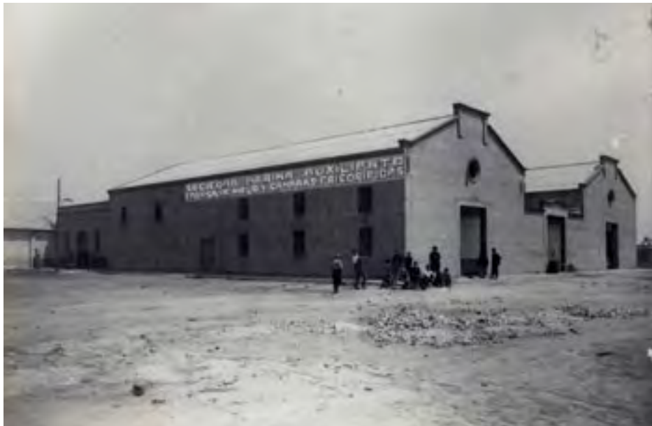
Fig. 13. Fábrica del Hielo y cámaras frigoríficas de La Marina Auxiliante. Cortesía de Ricardo Ferrer.
