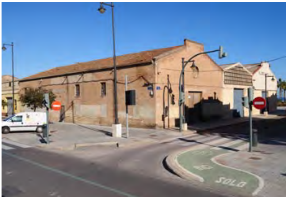
Fig. 5. Vista exterior de la Fábrica de Hielo. Fotografía de Álvaro Toepke.
