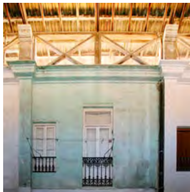
Fig. 4. Alero de cubierta y cruces de San Andrés sobre el piso alto de la fachada interior de nave de viviendas en la Lonja del Pescado
