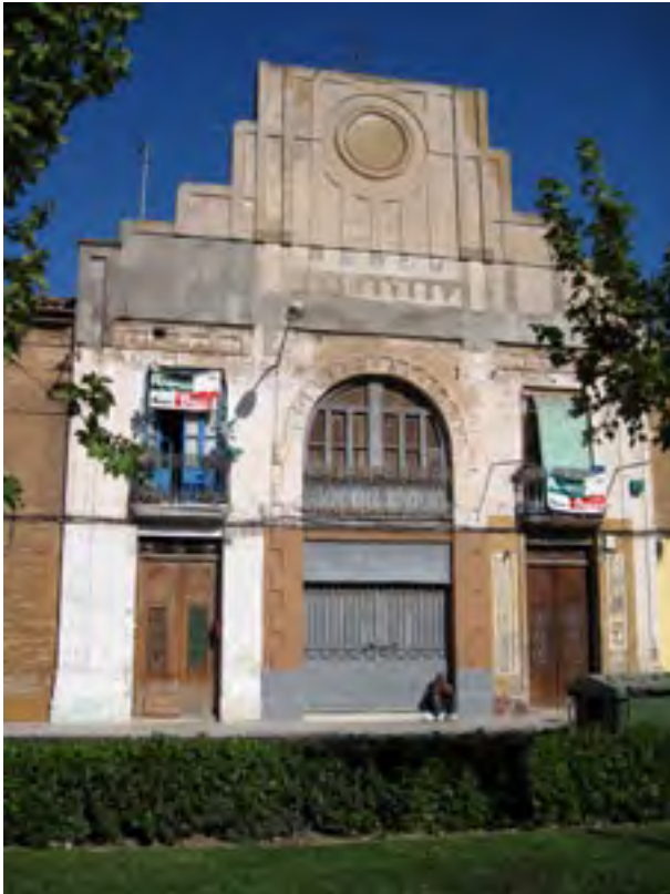
Fig. 10. Puerta occidental de acceso a la Lonja del Pescado
