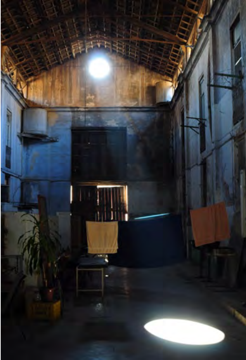
Fig. 9. Imagen actual del espacio central de la Lonja del Pescado. Fotografía de Álvaro Toepke.
