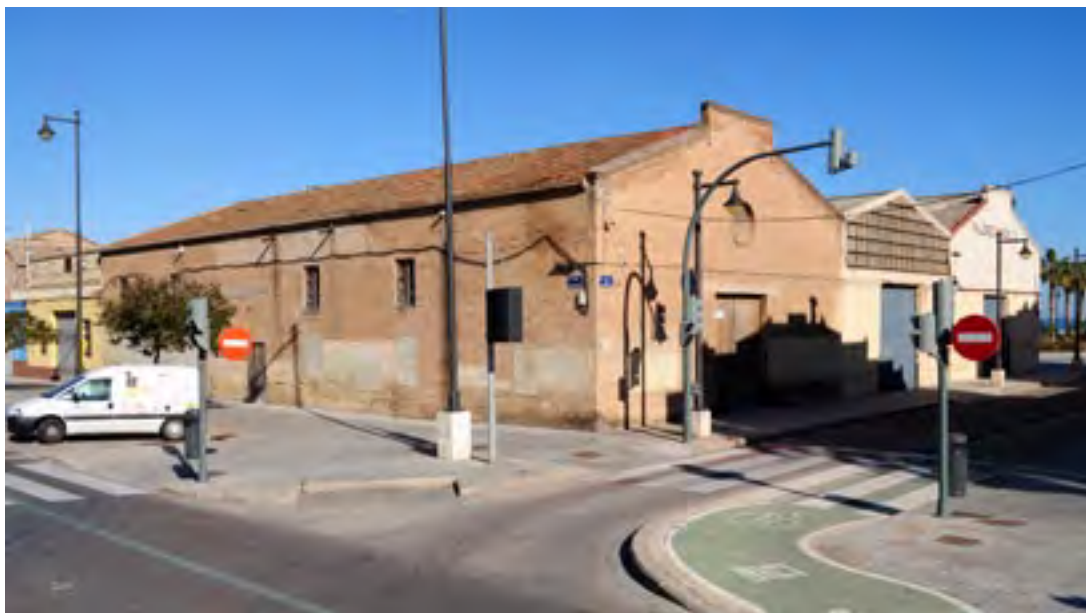
Fig. 14. Fotografía actual de la Fábrica del Hielo. Fotografía de Álvaro Toepke.
