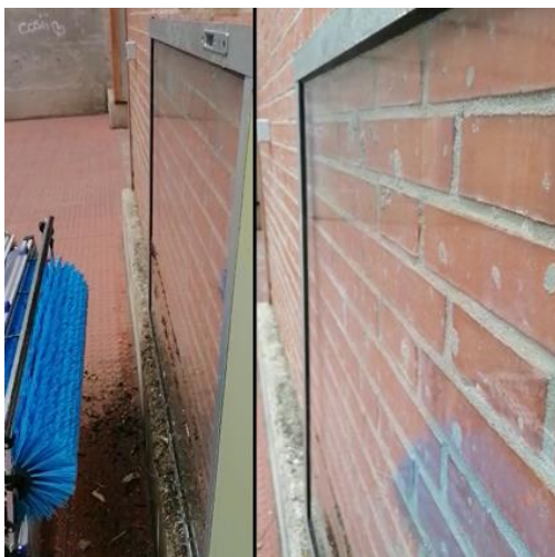
Figura 19: Operación de limpieza.
