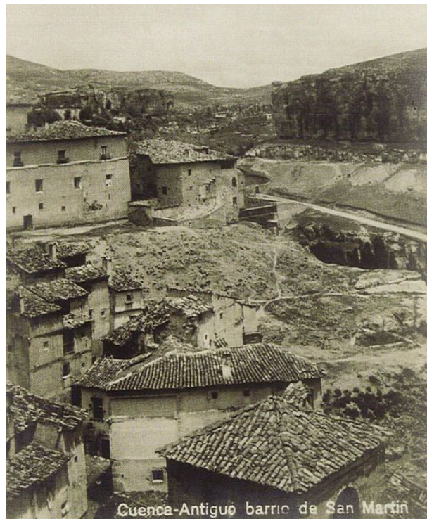
Ilustración 33: Demolición barrio San Martín. Fuente: Las Casas Colgadas y el Museo de Arte Abstracto Español, p. 188.
