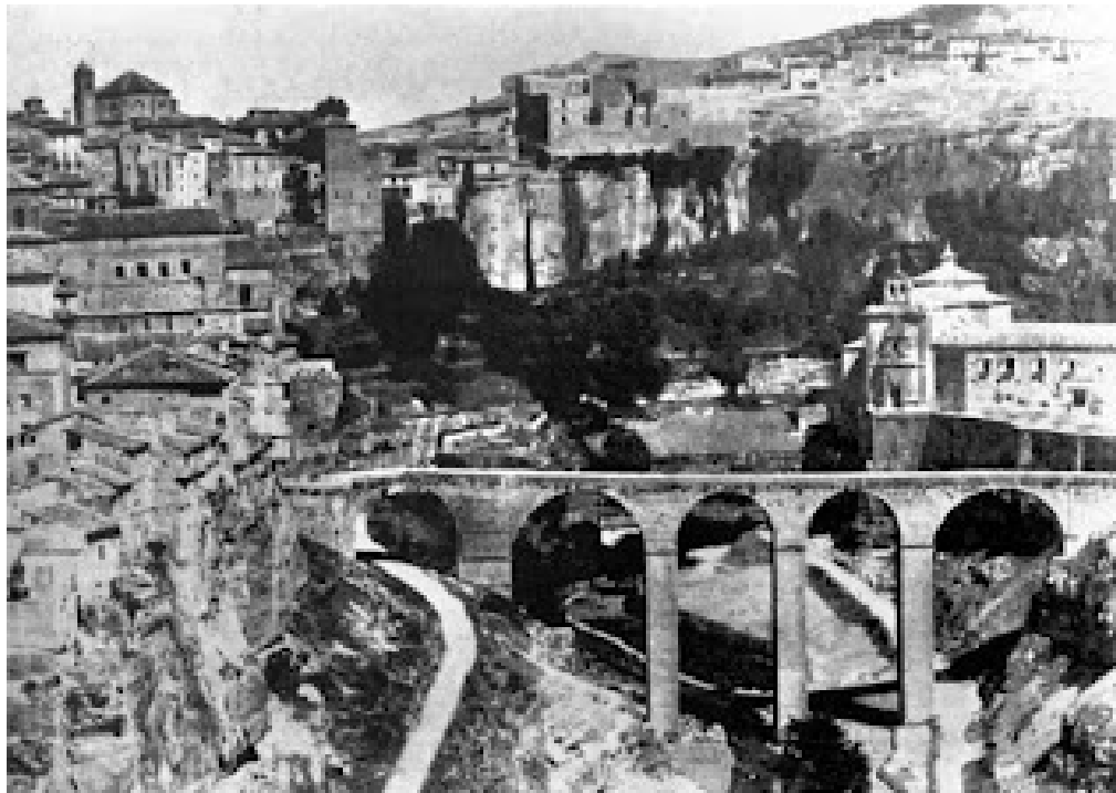
Ilustración 31: Antiguo puente San Pablo con las Casas Colgadas hacia 1890. Fuente: Del diario Las Noticias de Cuenca.
