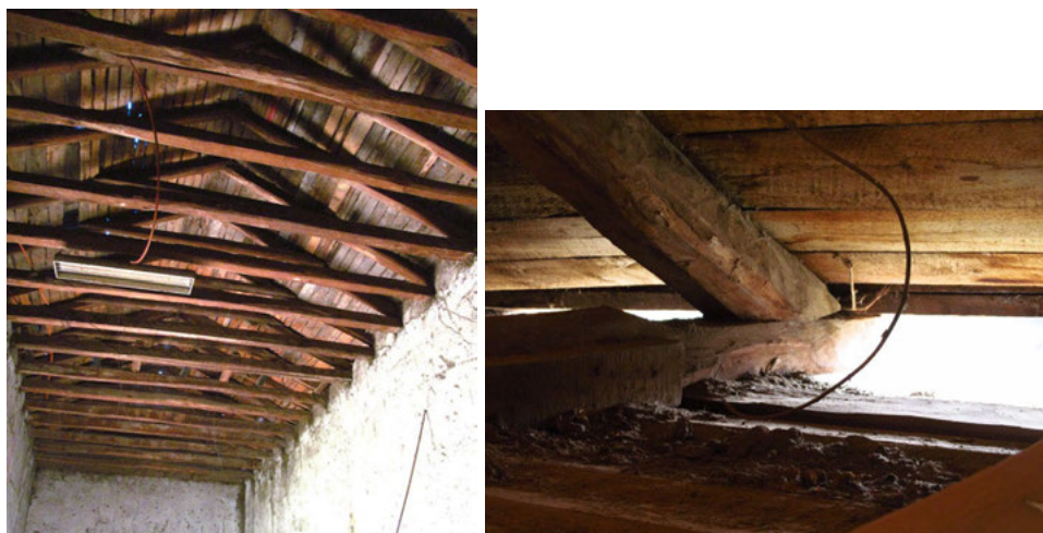
Fig. 4 Tijerales de cubierta sobre muros de adobe y detalle de apoyo sobre cadena superior en coronación de muro, Casona Quilapilún. Contreras y Jofré, 2016
