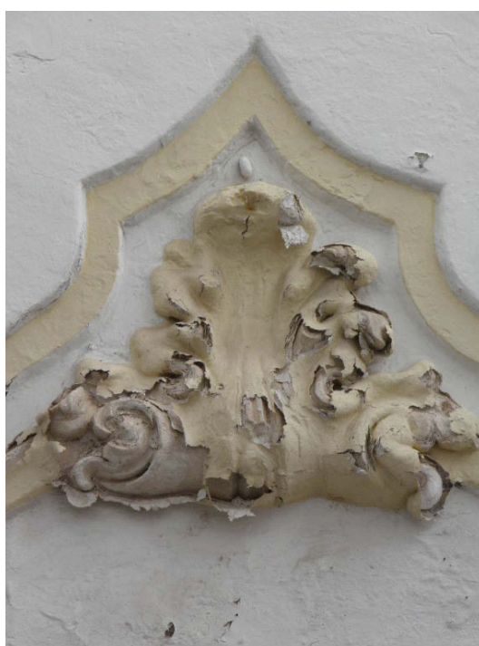
Fig. 3 Detalle de estuco en edificio de la ciudad de Elvas. 2019
