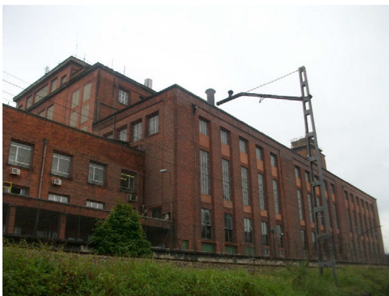
Fig. 4 Sala de turbinas y oficinas de la Central Térmica de Langreo. 2013
