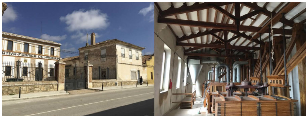
Fig. 1 Estado previo del conjunto industrial objeto de rehabilitación. Imagen exterior e interior de la maquinaria de la fábrica de harinas
