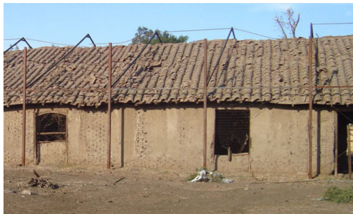
Fig. 2 Muros de adobe, Casona Quilapilún. Contreras y Jofré, 2016
