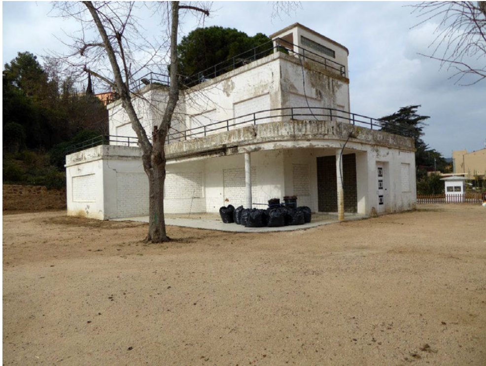
Fig. 3 Imagen de la fachada sur, con el porche en planta baja y terrazas en planta primera
