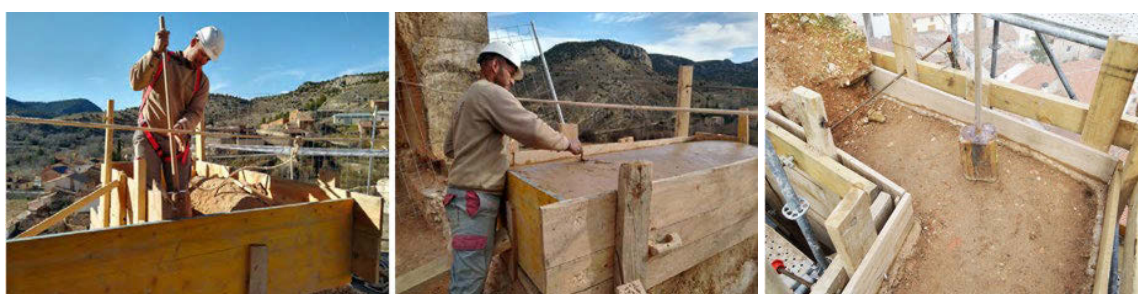
Fig. 4 Proceso de ejecución de tongadas de tapia y huella de construcción marcada en la costra para dejar evidencia de la ejecución nueva de esas tongadas. Mainel intervención arquitectura SL (2021)
