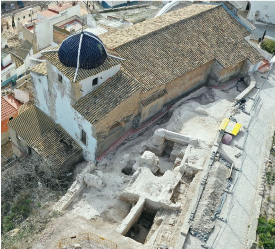
Fig. 4 Vista aérea de la zona de excavación. Fuente: Alebus Patrimonio Histórico.
