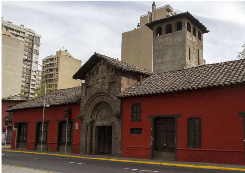
Fig. 1 Muros de adobe, Casona Quilapilún
