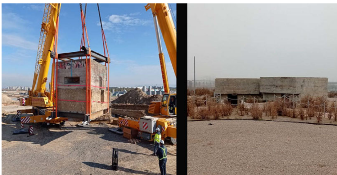
Fig. 3 Imagen del traslado de uno de los búnkeres de la Mata Espesa para la ampliación de IFEMA, y su ubicación final.
