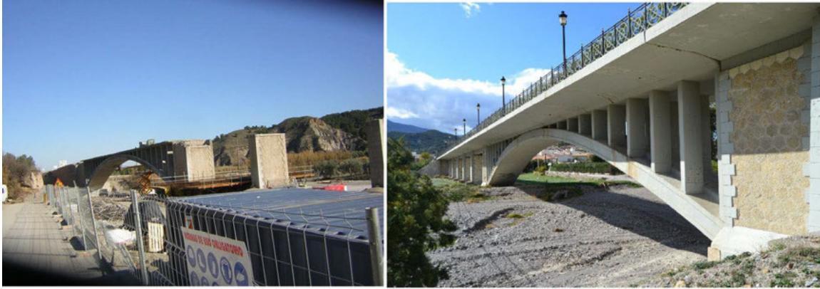
Fig. 6 Puente sobre el río Almanzora en Purchena(Almería). Izquierda, obras de restauración, en las que se sustituyó el tablero original por otro de nueva construcción más ancho. Derecha, estado actual
