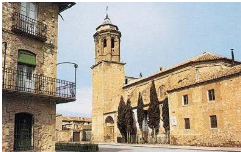
Fig. 1 Vista general de la iglesia antes de las últimas reformas. A la derecha, la sacristía. Gran Enciclopedia Aragonesa. Prensa Diaria Aragonesa SA (2000)
