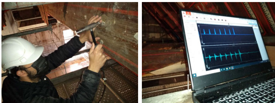
Fig. 3 Ensayos sónicos en la Iglesia de la Calandria, en La Granja de San Ildefonso (Segovia)
