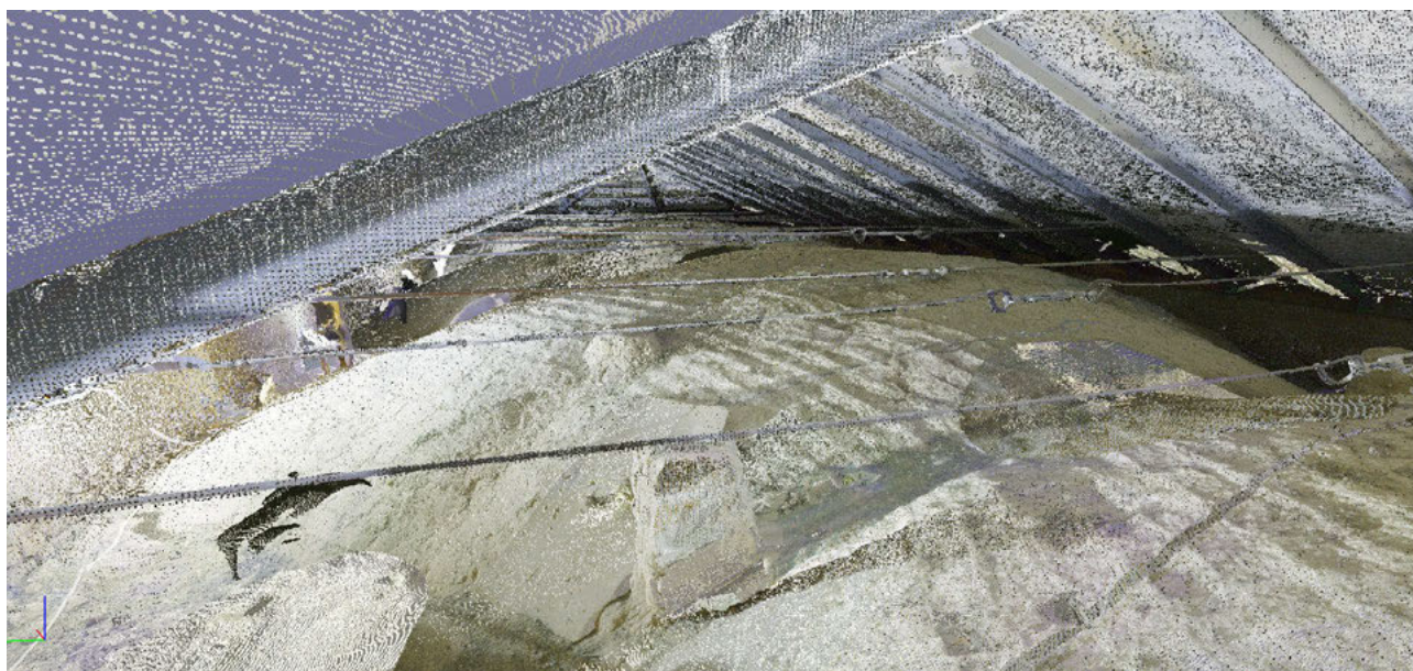
Fig. 6 Interior del espacio bajo cubierta de la nave visto a través de la maqueta virtual. Obsérvanse los enanos de apoyo de las armaduras de la primitiva cubierta y los tirantes de acero de la nueva. LeVARQ Levantamientos arquitectónicos y arqueológicos
