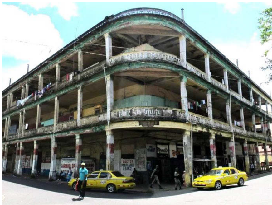
Fig. 4 Casa Wilcox, Centro Histórico de Colón. Alba, A. (2017)
