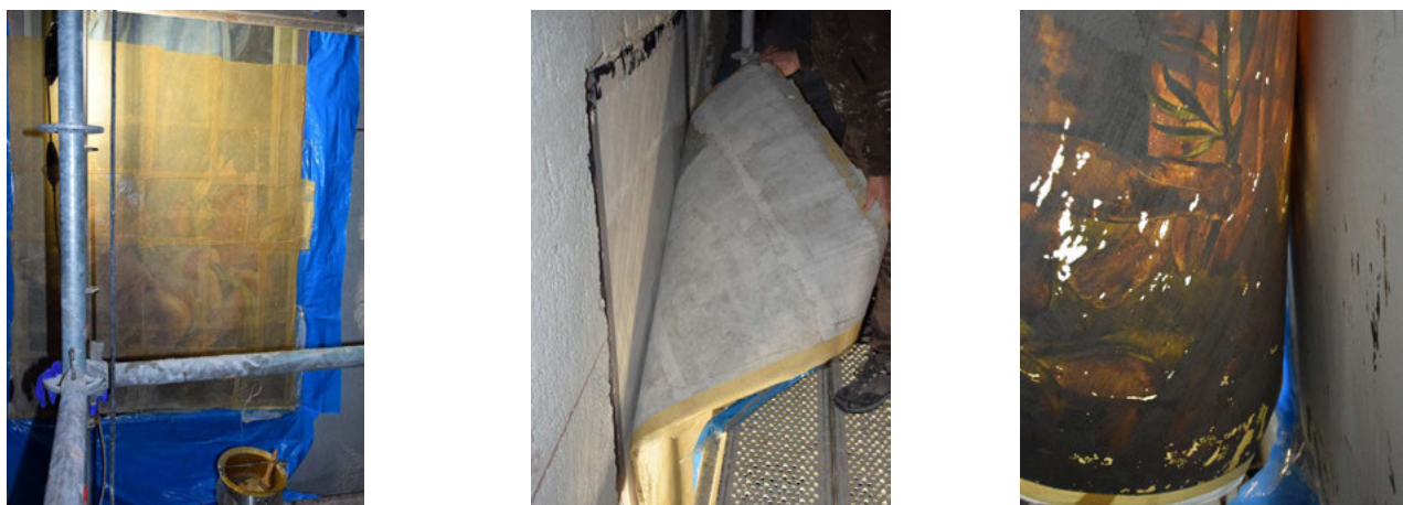
Fig. 6 Proceso de arranque a strappo . Imagen de la derecha: proceso de encolado, aplicación de la tela de retorta. Imagen del centro: proceso de desprendimiento. Imagen de la izquierda: fotografía del reverso de uno de los arranques. Pilar Soriano (2022)
