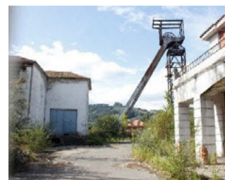
Fig. 3 Estado Actual de La Camocha, edificios principales y castillete. (2020)
