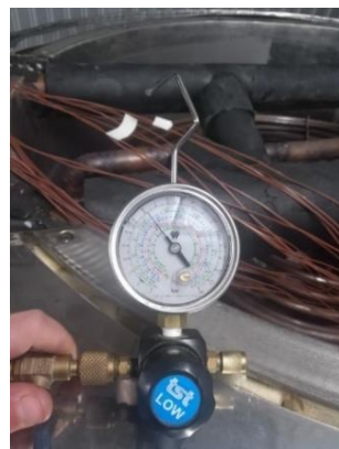
Figura 29. Manómetro usado para la comprobación del fugado.
