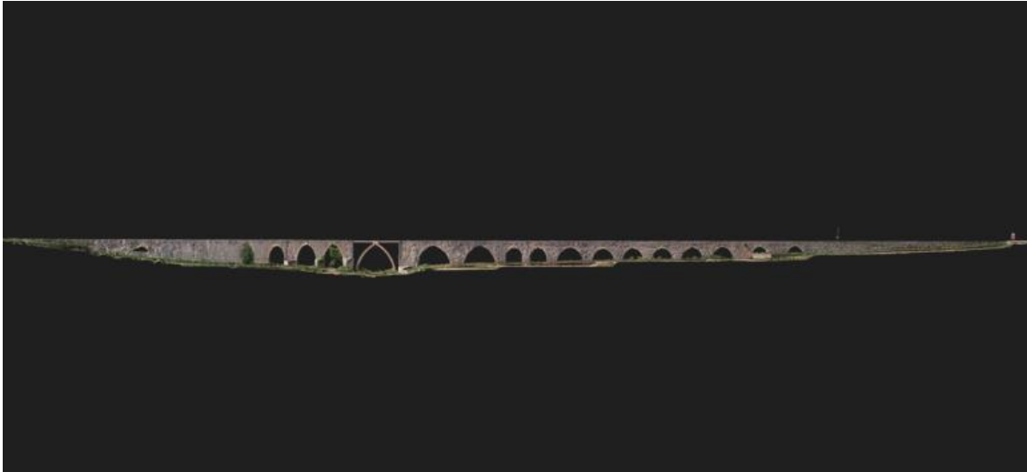
Figura 38. Ortofoto del alzado del acueducto. Fuente: (elaboración propia)
