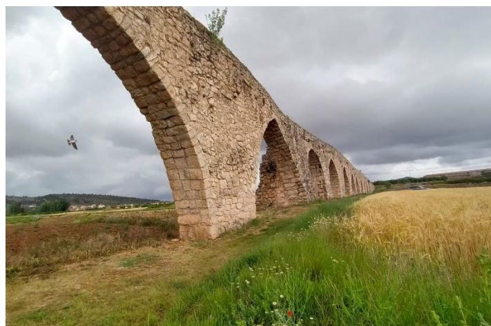
Figura 2. Acueducto Los Arcos de Alpuente. Fuente: (elaboración propia)
