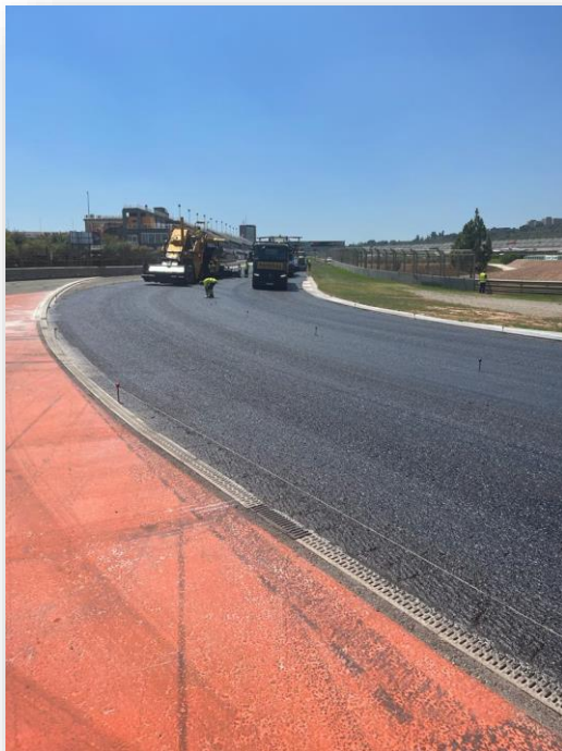
Figura 53: Puesta de lienza para guiar las máquinas y nivelar el asfalto. Fuente: Elaboración propia
