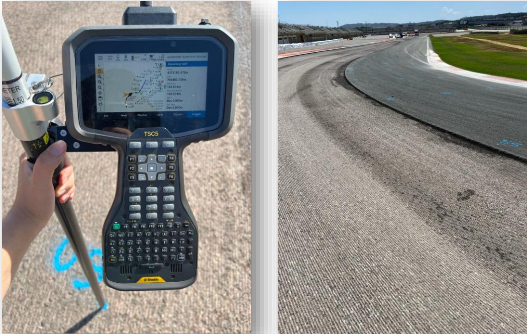
Figura 51: Comprobación del fresado. Fuente: Elaboración propia
