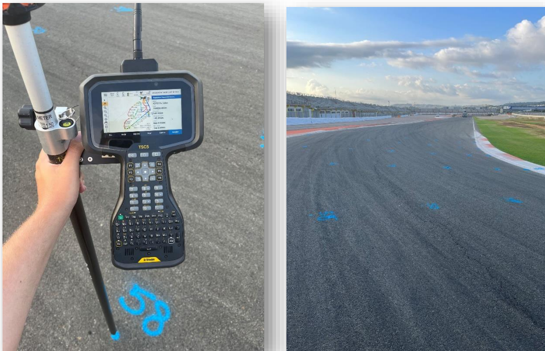
Figura 50: Replanteo de cotas con el modelo del circuito para el fresado. Fuente: Elaboración propia
