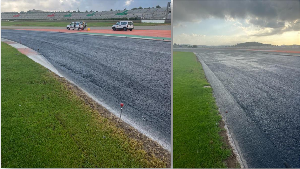
Figura 52: Instalación de tochos con sus cotas. Fuente: Elaboración propia
