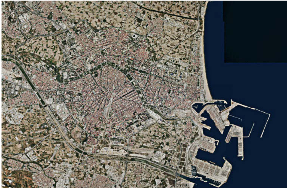
Fig. 2 Vista satelital de Valencia, 2021: todo el territorio incluido entre el casco histórico y La Huerta Norte ha sido completamente edificado. Se observan claramente los barrios pertenecientes a la avenida de Blasco Ibáñez, en la porción noroeste, y el crecimiento del área portuaria. En la parte sur, además, se aprecia la desviación del río y su impacto sobre La Huerta Sur. VCGV (recuperada el 05/04/2022)
