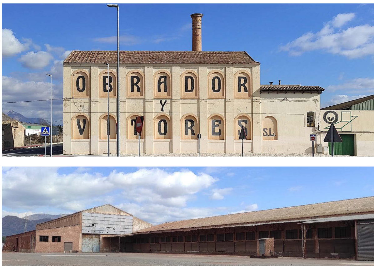
Fig. 4 (Arriba) Nave y chimenea de la antigua Cervecera Alicantina (ca. 1920), actualmente taller de madera Obrador y Vitores SL (nº 14). (Abajo) Estado actual de la fábrica de materiales cerámicos en el paraje La Monfortina (ca. 1960) (nº 15). 2022
