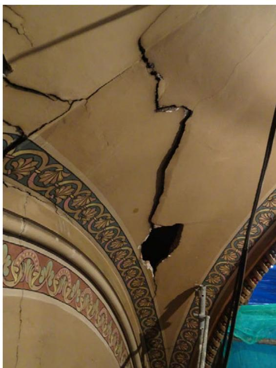
Fig. 4 Detalles de uno de los lunetos agrietados, con el agujero provocado por la caída de un trozo de bóveda (2020). ARAE Patrimonio y Restauración SLP
