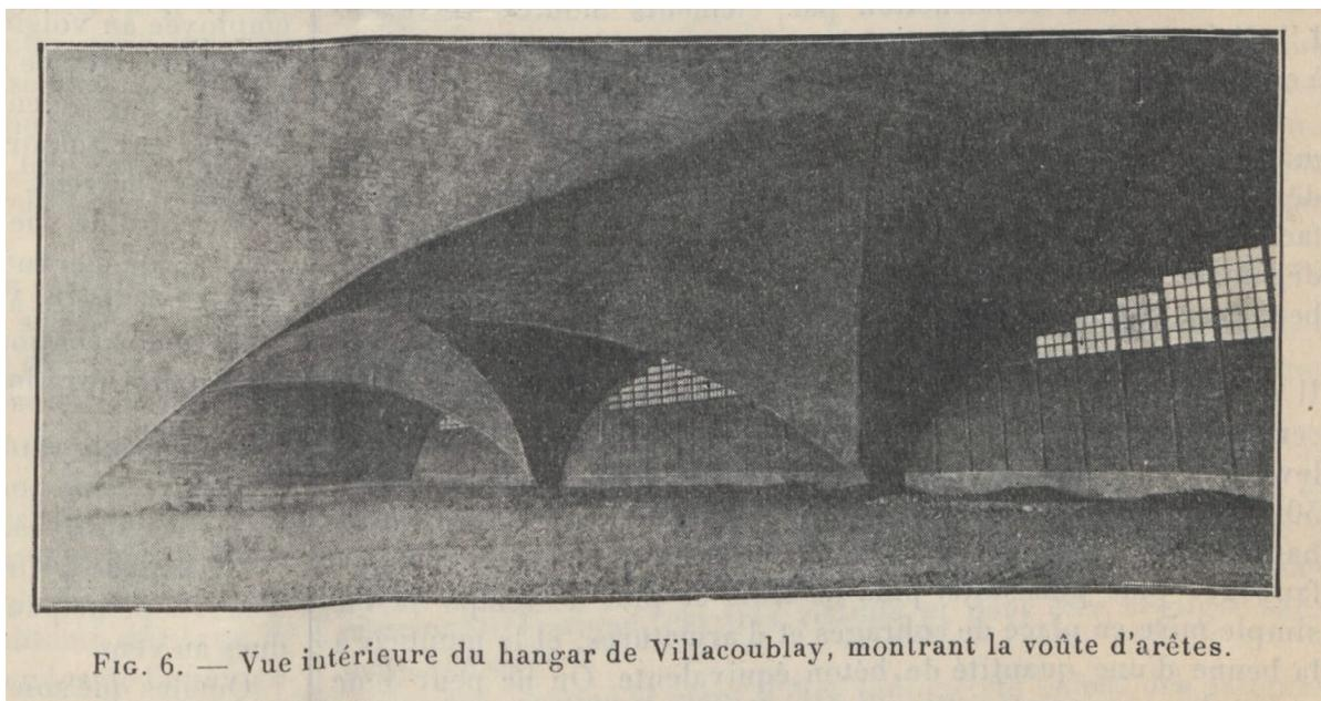
Figura 2. Vista de la bóveda de aristas propuesta por Freyssinet para el aeródromo de Villacoublay (Freyssinet 1923, LXXXIII-12, 267).
