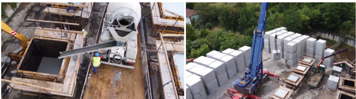
Fig. 12 Labores de fabricación y acopio en el parque de bloques. Fuente: TYPSA (2016)
