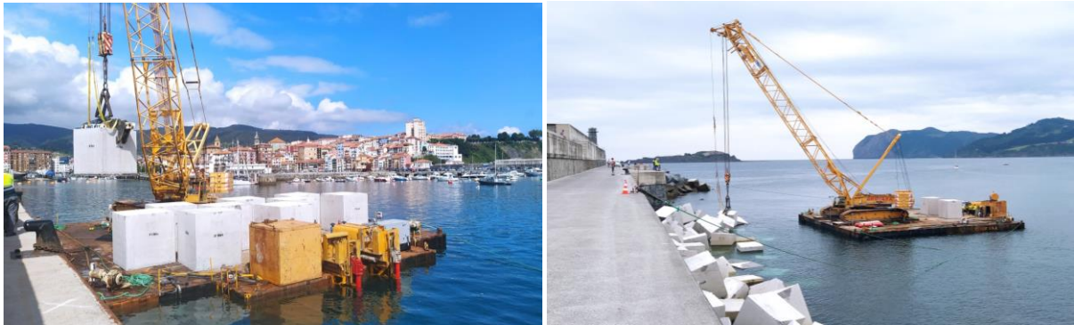
Fig. 12 Carga y colocación de bloques con pontona modular. Fuente: TYPESA (2016)
