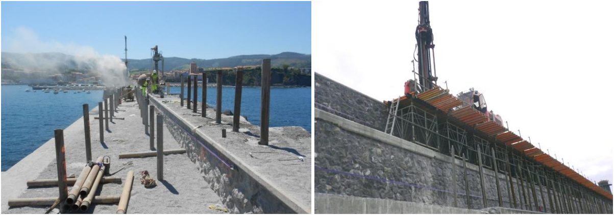
Fig. 7 Avance en las labores de micropilotaje. Fuente: TYPSA (2016)
