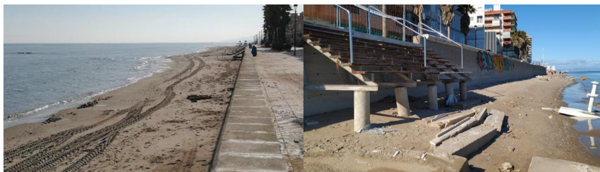
Fig. 2. Playa Les Palmeres (Sueca). A la izquierda estado de la playa tras el paso del temporal de enero de 2017. A la derecha estado de la playa tras el paso del temporal de enero de 2020 (Fuente: CEDEX).
