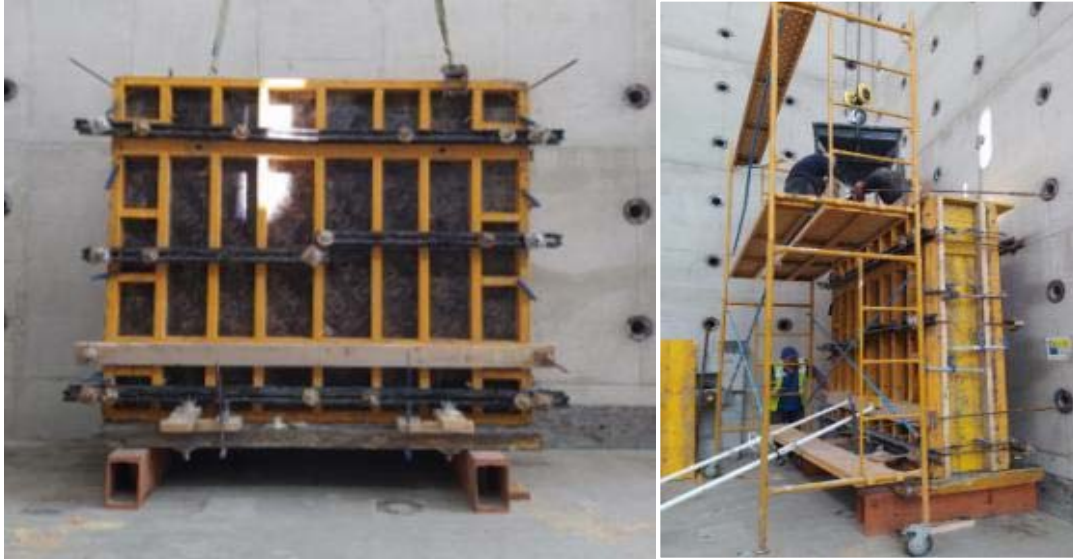
Fig. 5 Disposición del encofrado y vertido del hormigón
