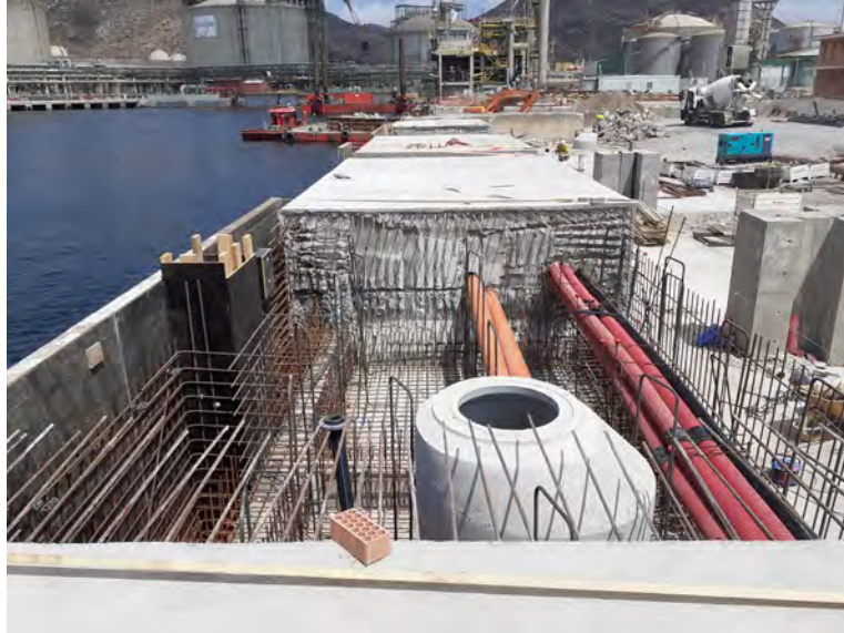
Fig. 6 Superestructura sección 1. Fuente: SATO (2020)
