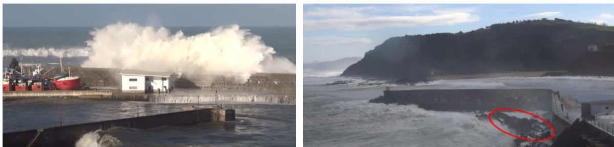
Fig. 2. Rebases en la primera alineación del dique. Fuente: TYP SA (2014)
