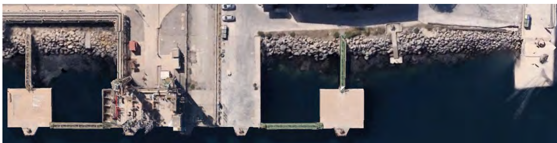
Fig. 1 Estado inicial. Fuente: Google Earth (2020)
