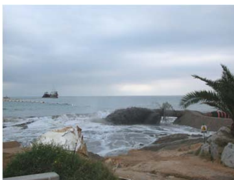
Fig. 5 Descarga del material en la playa
