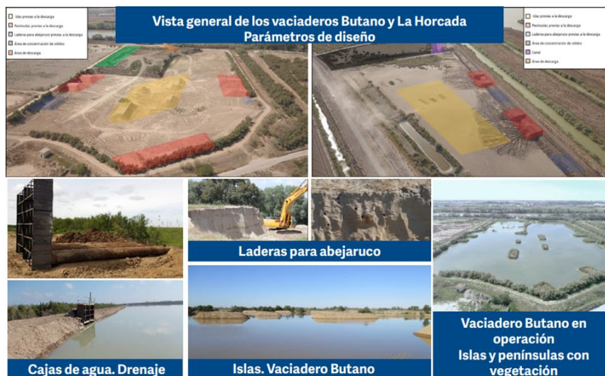
Fig. 7 Secuencia de los trabajos realizados en los vaciaderos de Butano y La Horcada. Fuente: APS
