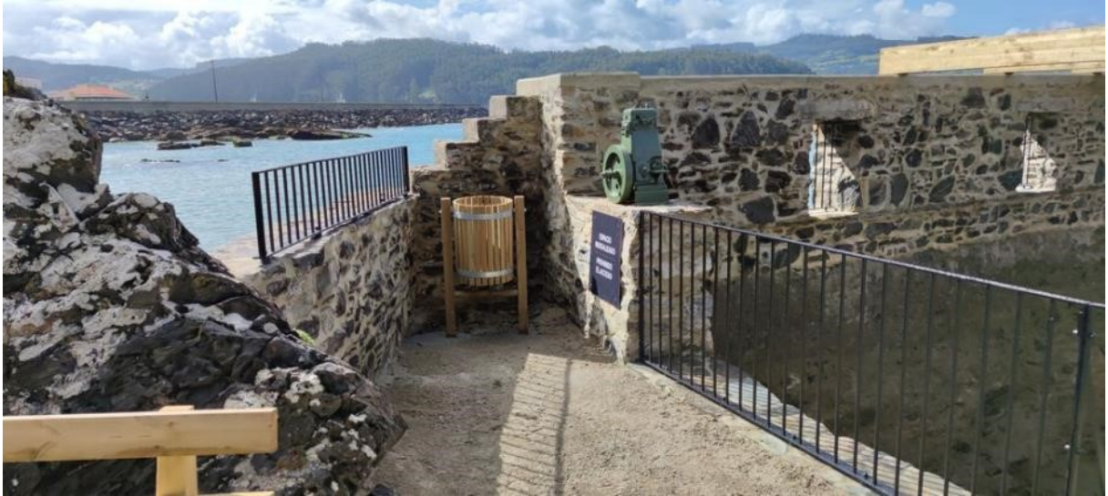
Fig. 11 Detalles constructivos de barandillas y cartelería disuasorias y maquinaria. Fuente: MITECO (2022)
