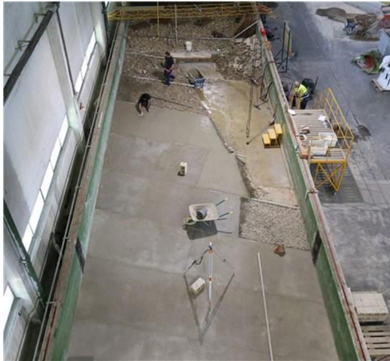
Fig. 3 Construcción de las batimétricas del modelo
