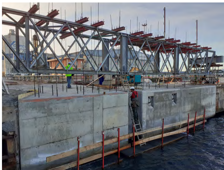
Fig. 9 Superestructura sección 3. Ejecución de los trabajos. Fuente: SATO (2020)
