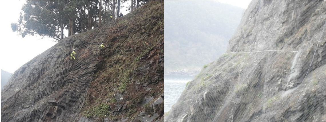
Fig. 2 Colocación de malla protectora del talud. Detalle de fijación. Fuente: MITECO (2022)
