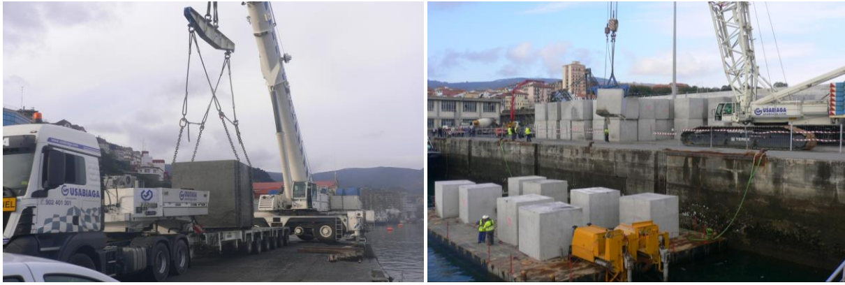
Fig. 10 Labores del transporte de bloques al dique de Bermeo. Fuente: TYPSA (2016)
