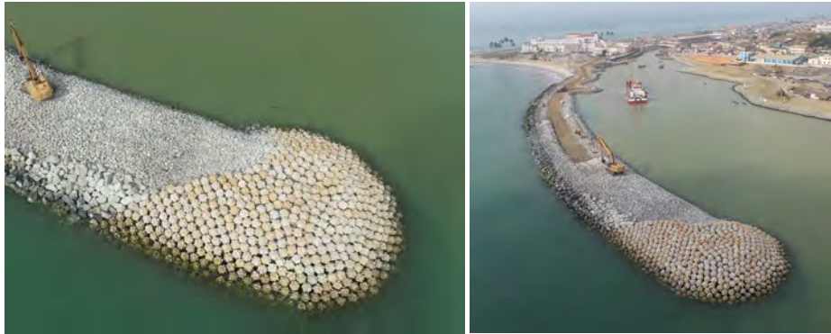
Fig. 13 Aspecto del morro a la finalización de las obras. Fuente: DEME (2022)
