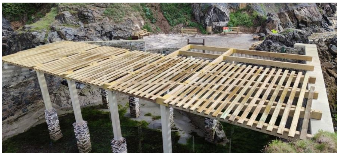
Fig. 10 Reconstrucción de cubierta de madera. Fuente: MITECO (2022)
