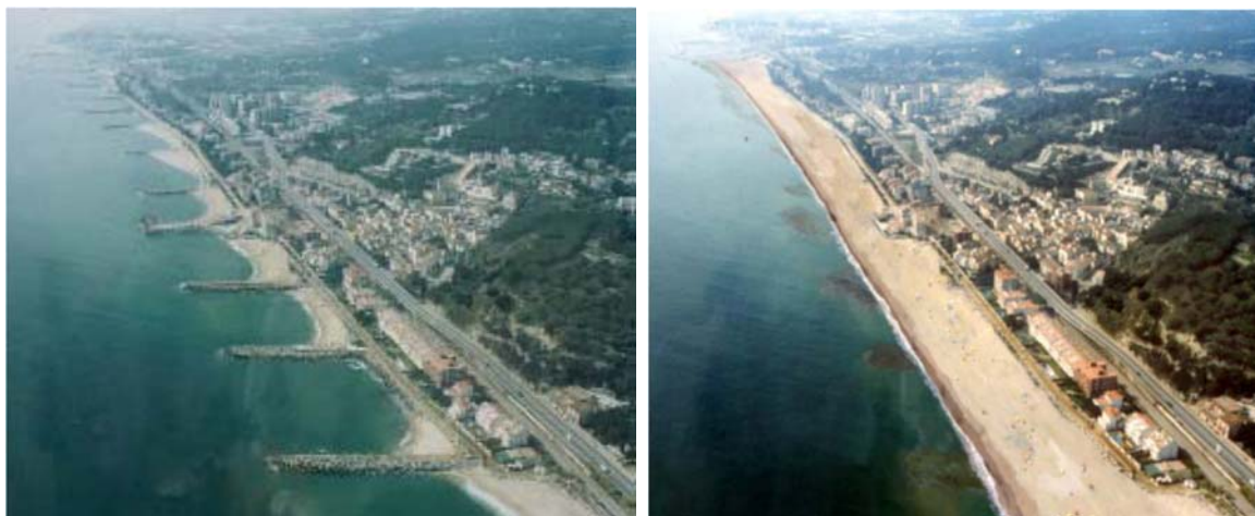
Fig. 1 Resolución de problemas de erosión
