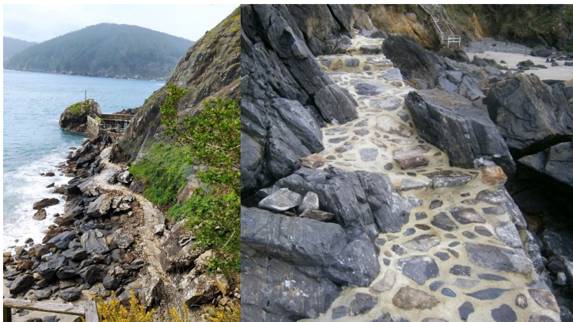
Fig. 4 Acondicionamiento de acceso peatonal con senda de piedra del litoral. Fuente: MITECO (2022)
