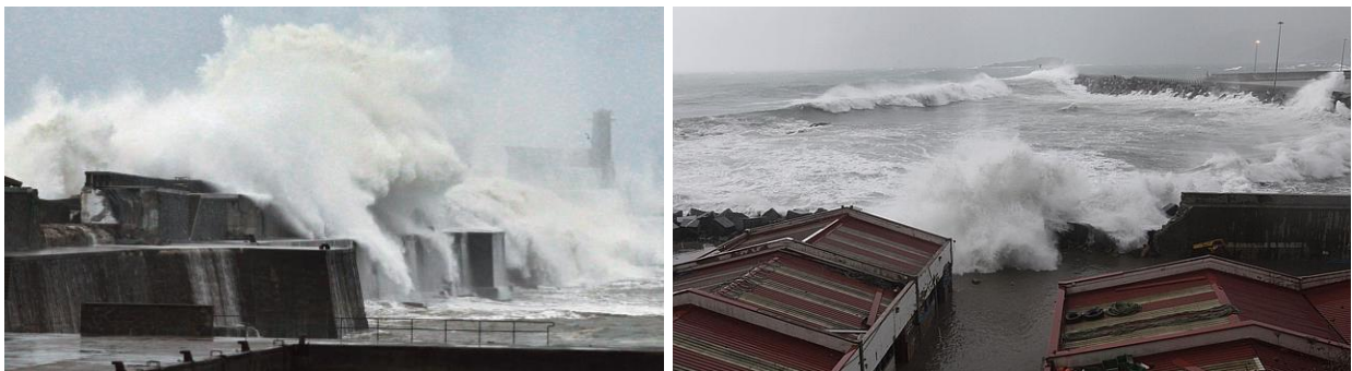
Fig. 2 Rebase espectacular y oleaje incidente en temporal del 2014. Fuente: TYPSA (2014)
