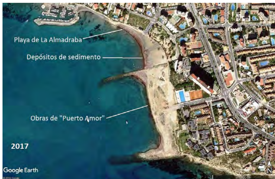
Fig. 4: Playa de La Almadraba y obras de Puerto Amor en marzo de 2017 (Foto: Google Earth)
