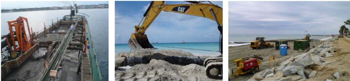
Fig. 6 Los equipos del tren de dragado
