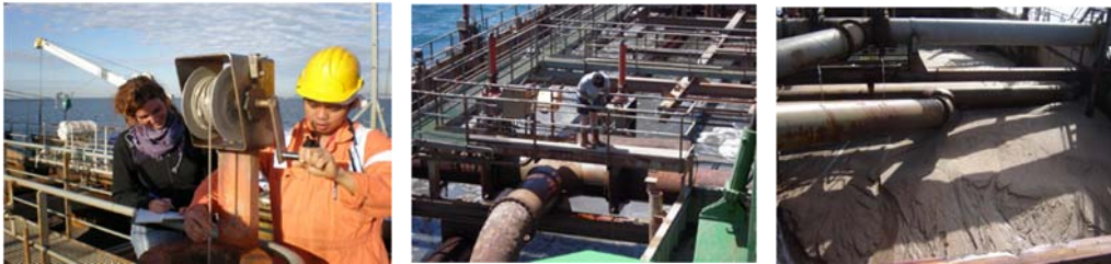
Fig. 11 Control al finalizar el dragado
