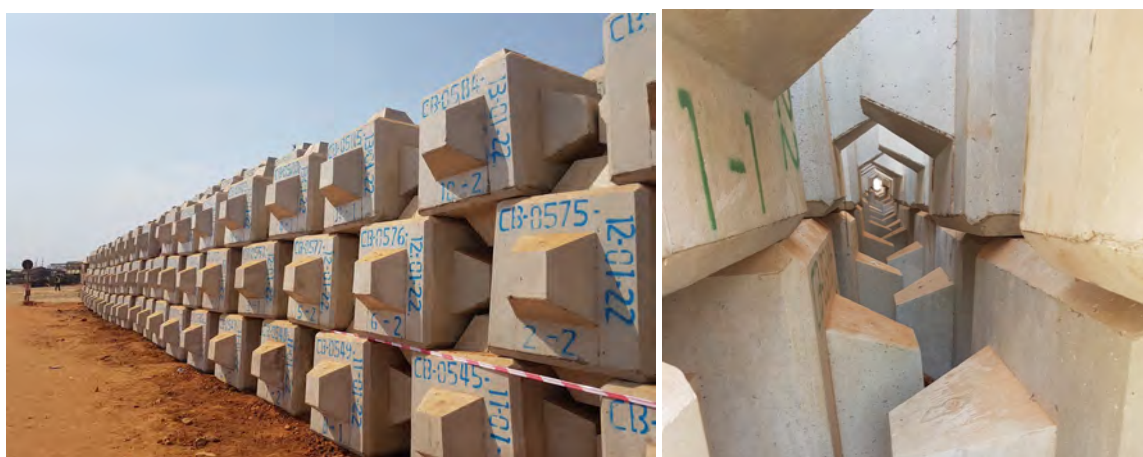
Fig. 9 Acopio de piezas. Fuente: SATO (2022)
