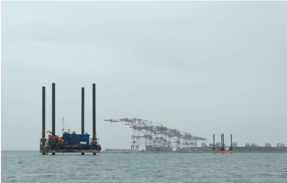
Fig. 1 Vista de las dos Jack-up en el Puerto de Barcelona
