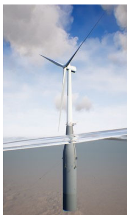
Figura 8. Hywind Tampen. La SPAR es de hormigón postensado. Fuente: Equinor
