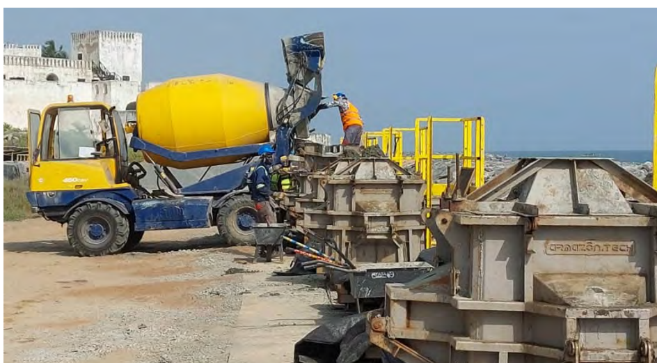
Fig. 8 Fabricación de piezas. Fuente: SATO/BELLSEA (2021)
