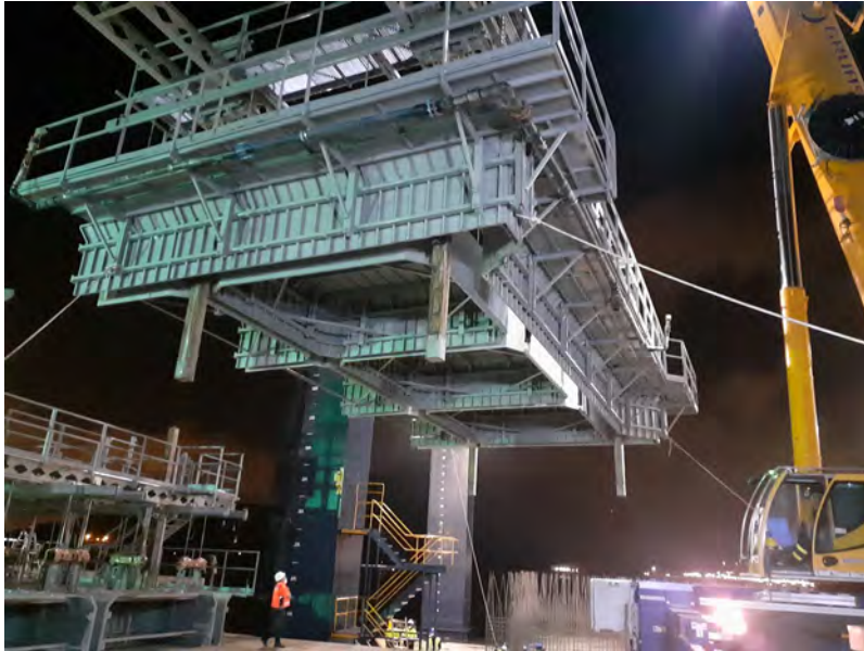
Fig. 3 Manipulación de módulos de encofrados. Fuente: SATO (2020)
