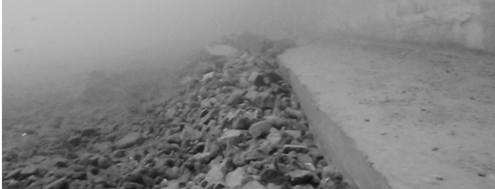
Fig. 6. Arrastre superficial de la grava de enrase. Fuente: SATO (2020)
