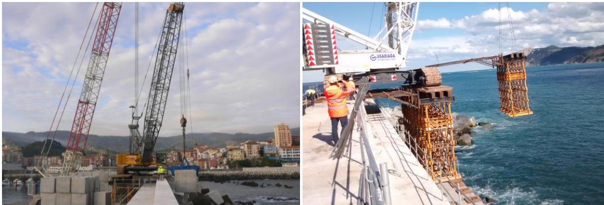
Fig. 11 Labores de colocación de bloques mediante grúa sobre cimbra. Fuente: TYPSA (2016)
