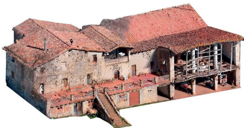
Figura 6. Levantamiento fotogramétrico de Mas Maçandell realizado a partir de fotogrametría.
