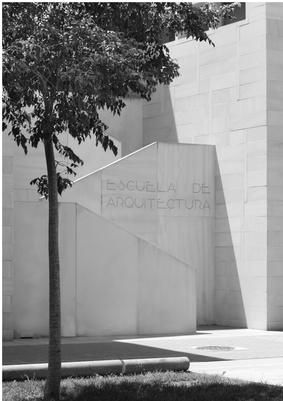
Escaleras del acceso norte
