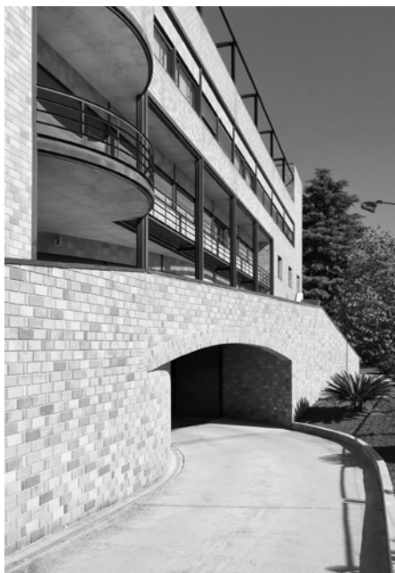
Acceso a sótano en fachada oeste
