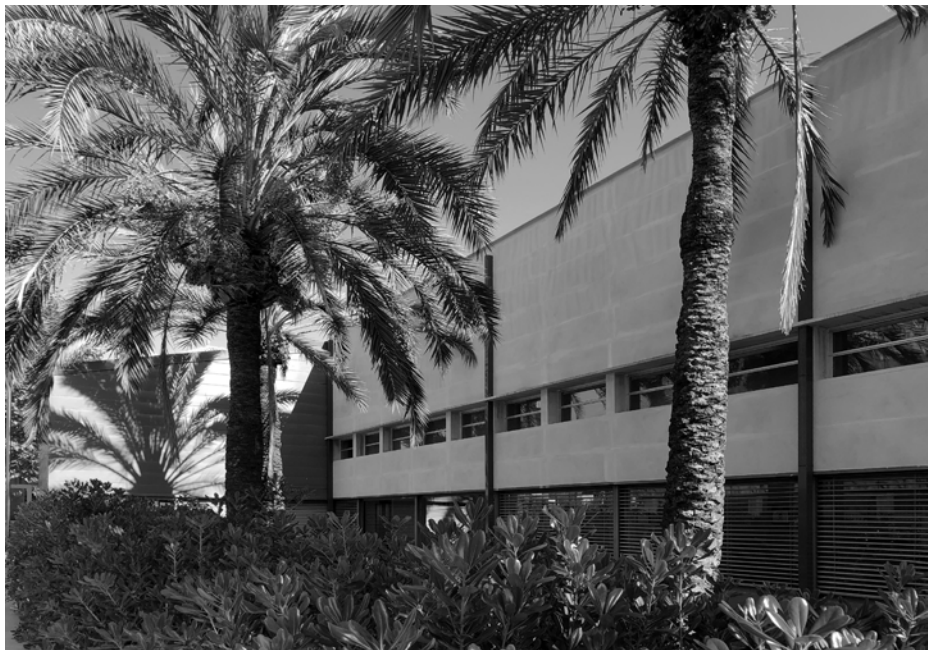
Vista del alzado oeste
