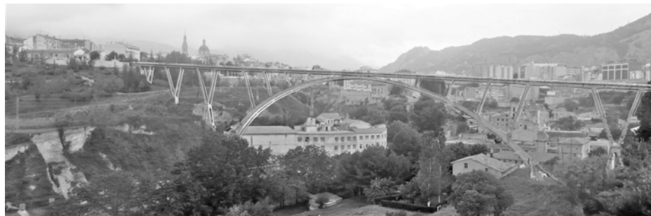
Vista del puente entre el Viaducto y la zona norte
