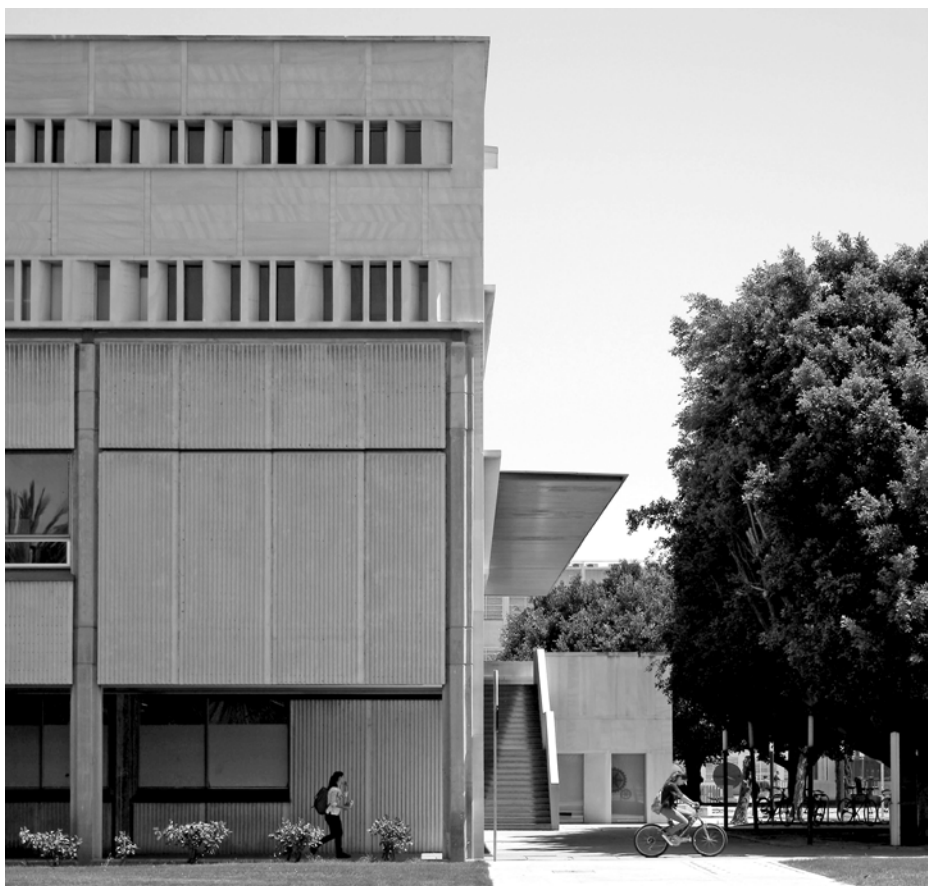
Vista del alzado oeste
