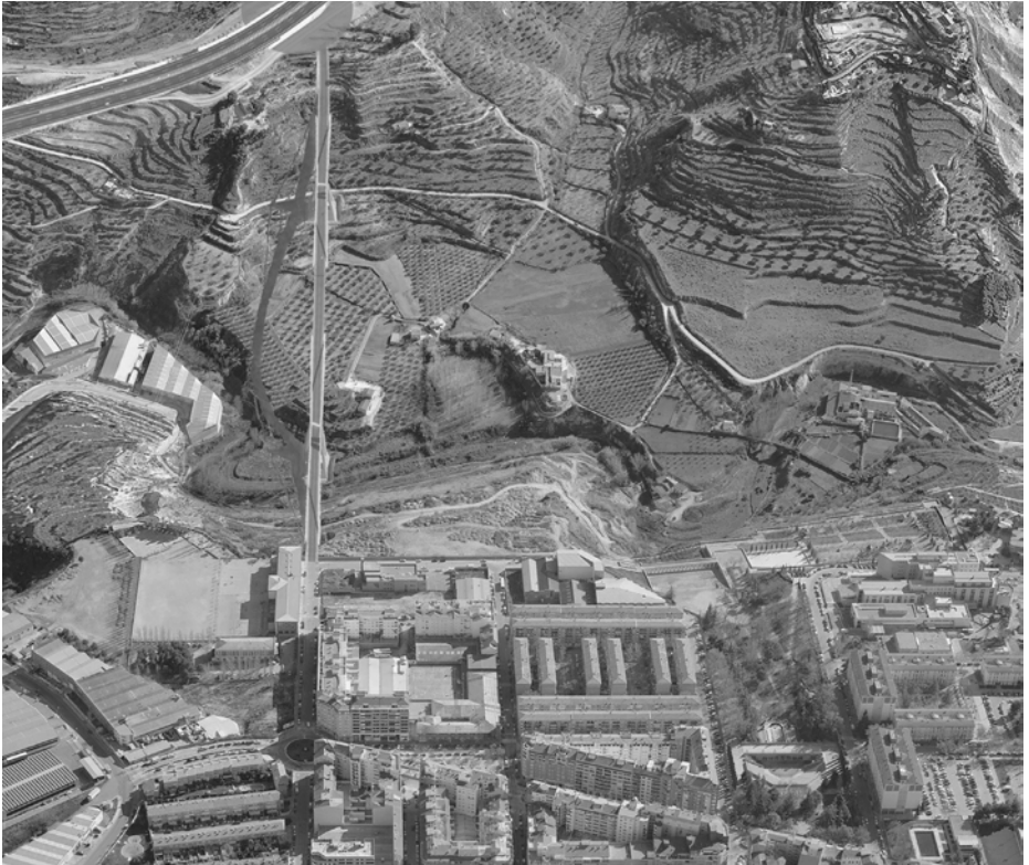
Vista aérea de la nueva conexión norte de Alcoy
