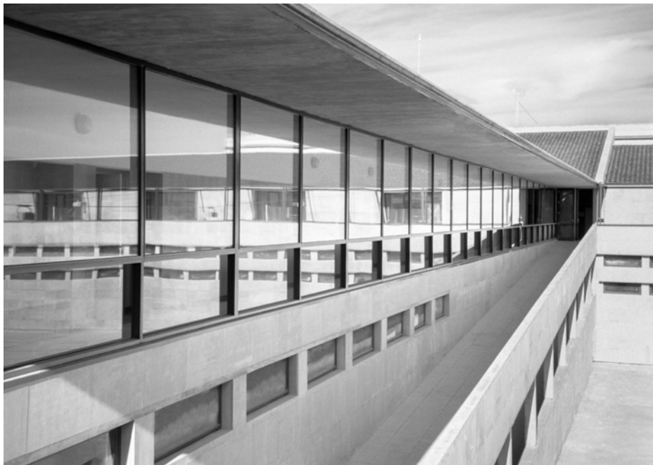
Vista de la rampa exterior
