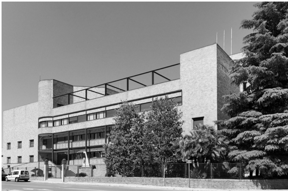
Vista del alzado oeste
