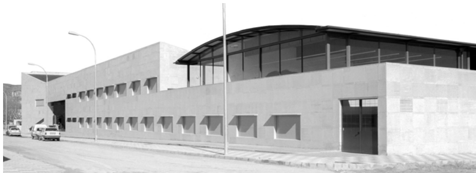
Vista del alzado oeste
