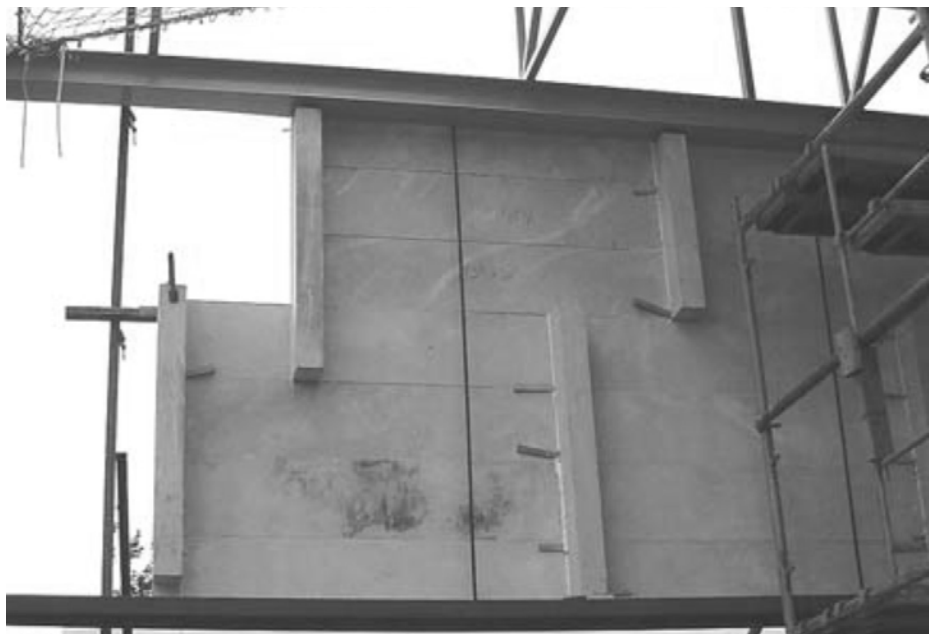
Detalle de construcción del cerramiento
