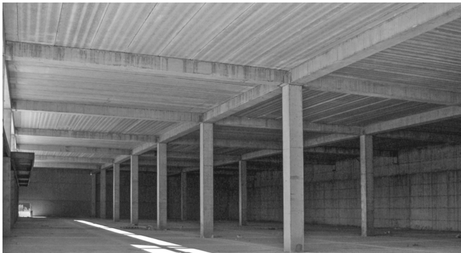
Vista del interior de la ampliación
