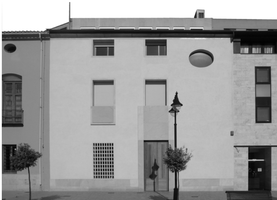
Vista del alzado oeste
