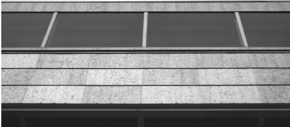
Detalle de la pasarela
