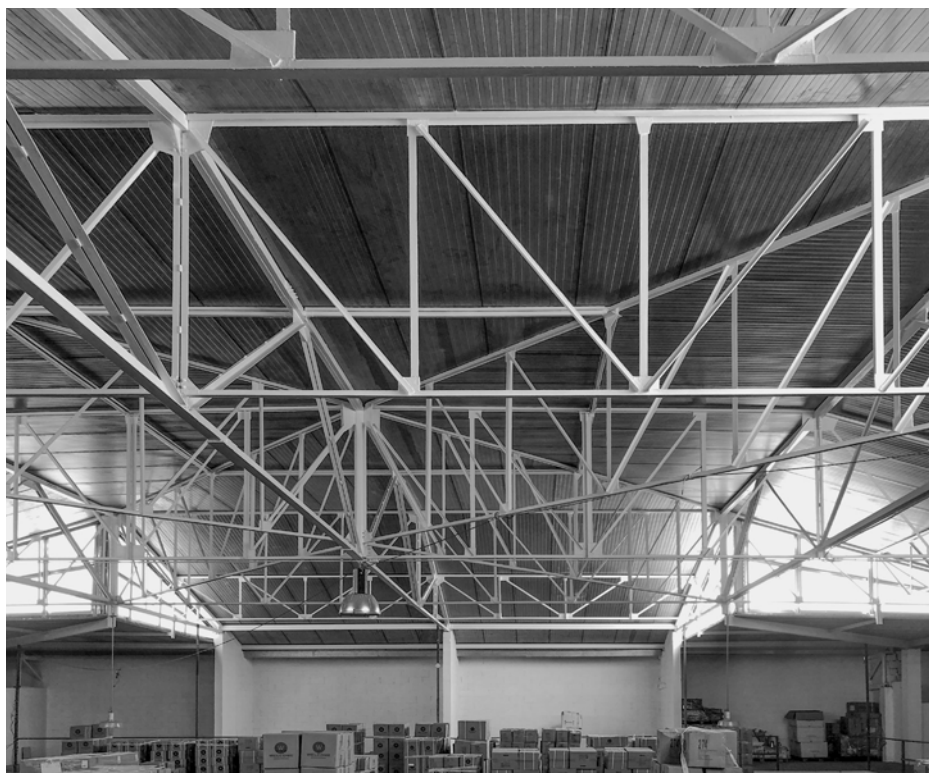
Solución de entrada de luz en el almacén
