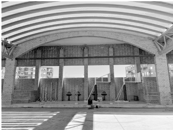
Vista de la bóveda de metal sobre el arco de ladrillo Fotografía Paula Jornet Jordá
