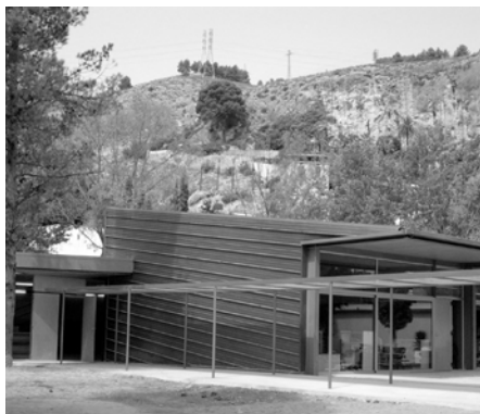
Colegio El Romeral, marquesina y pabellón infantil. 2002
