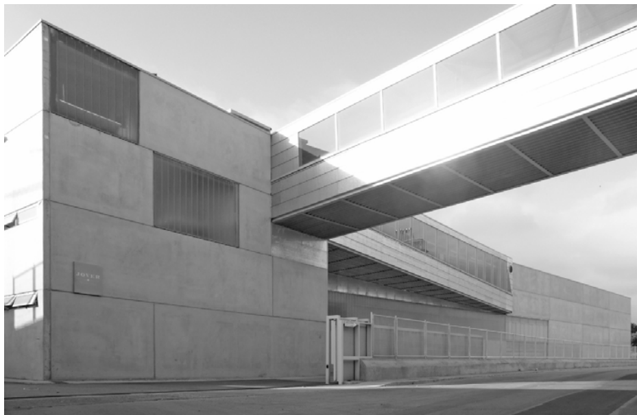
Vista del alzado norte de la ampliación y de la pasarela
