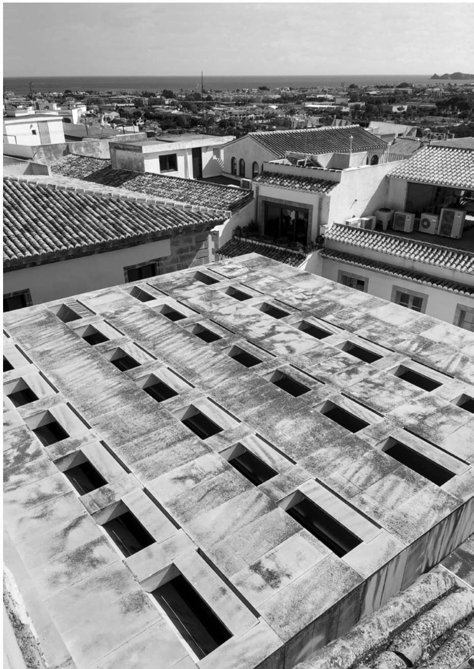
Vista de la cubierta
