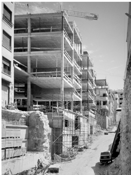
Apertura de la rampa de la Sang
