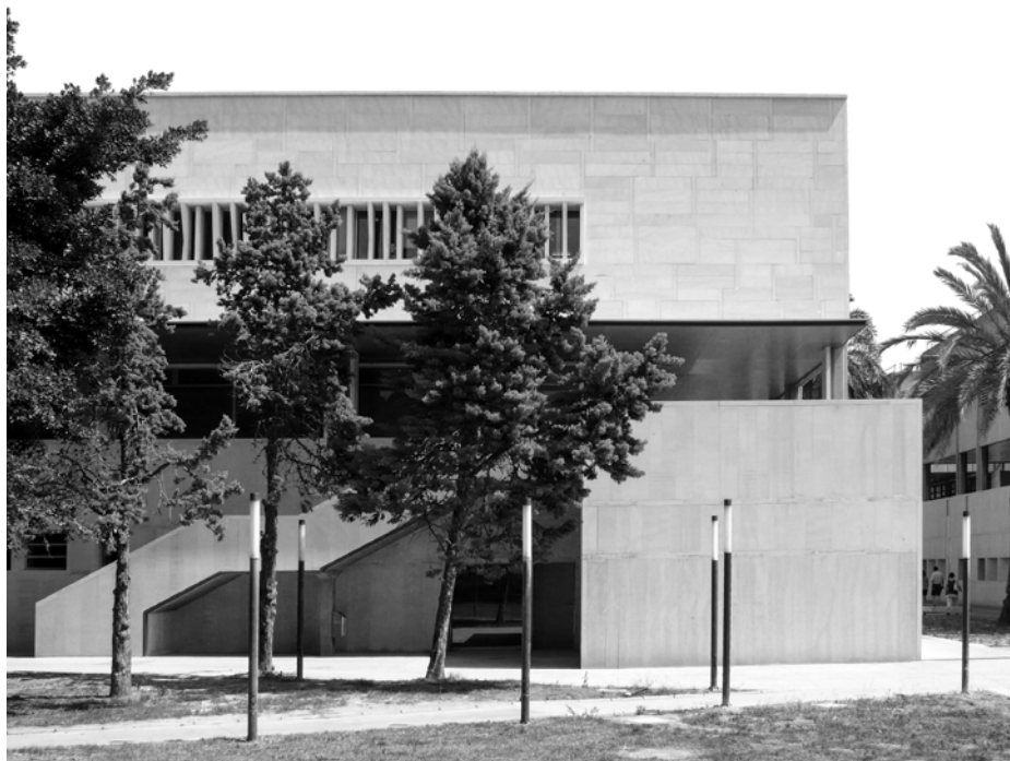
Remodelación y ampliación de la ETSA-UPV. Valencia. 2000
