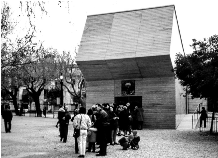
Vista del acceso
