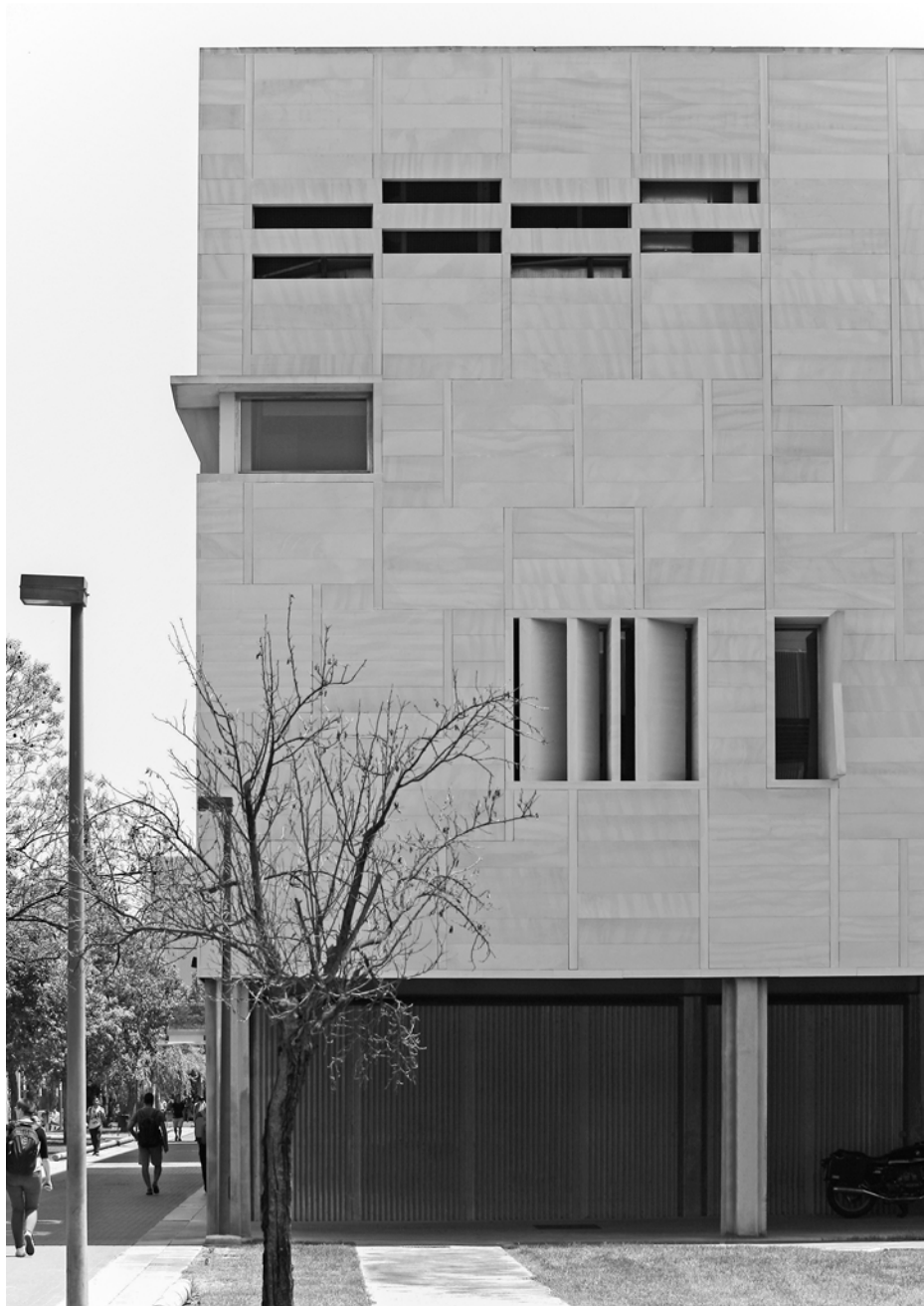
Vista del alzado oeste
