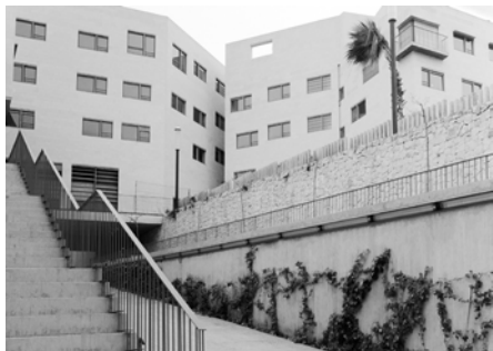
Vista desde la rampa
