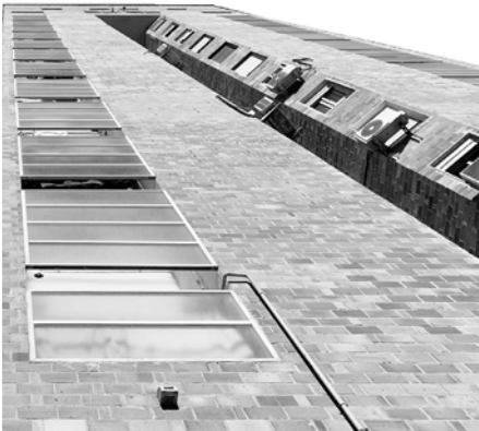
Vista del lienzo de fachada
