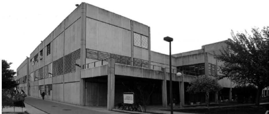
Estado previo del alzado oeste
