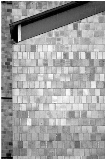
Despiece del ladrillo refractario
