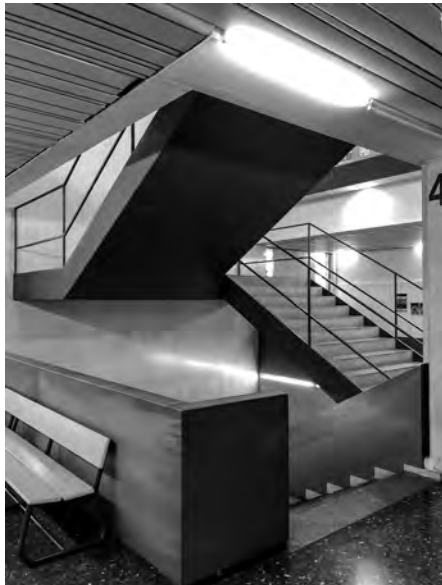
Escalera de planta primera a segunda
