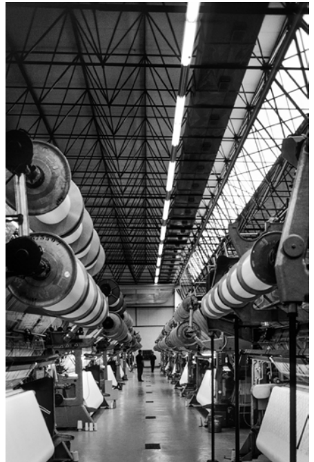
Vista interior de la sala de telares
