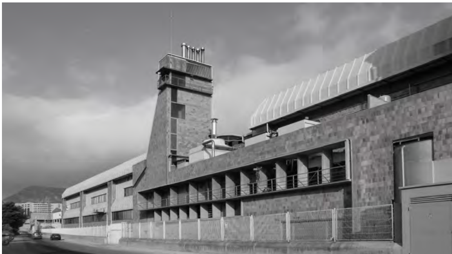
Vista del alzado sur de la cogeneración
