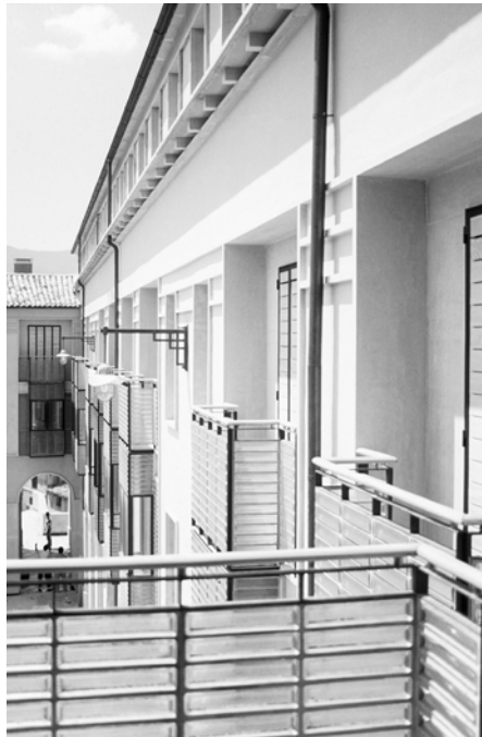
Vista desde los balcones
