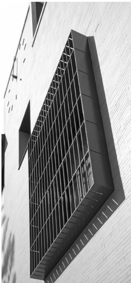
Detalle hueco del mirador
