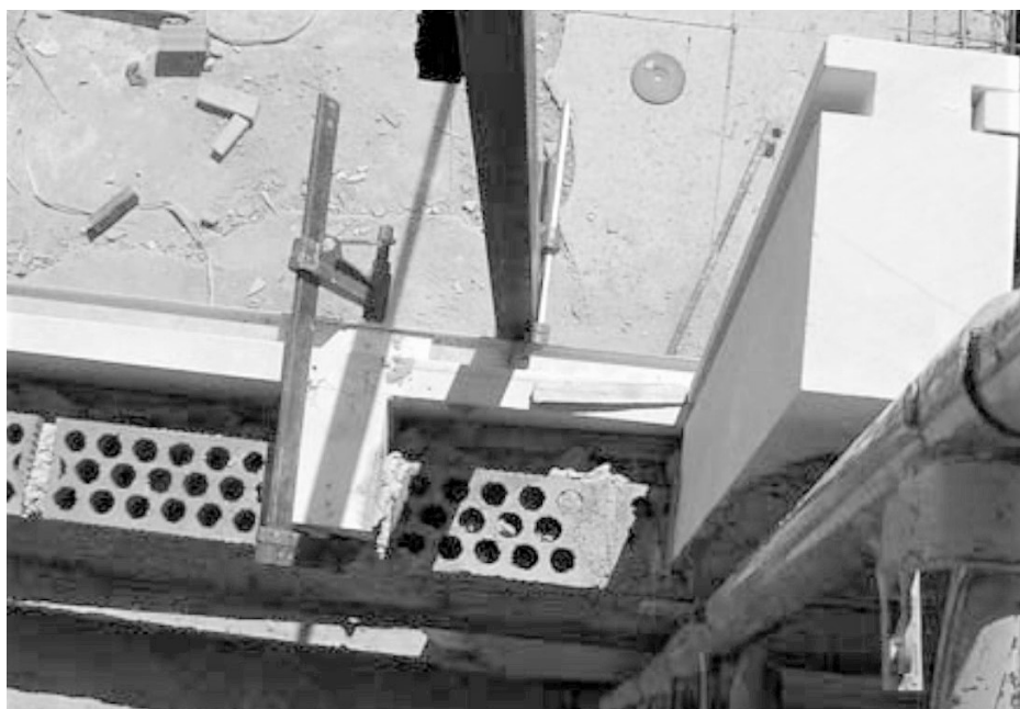
Detalle de construcción del cerramiento
