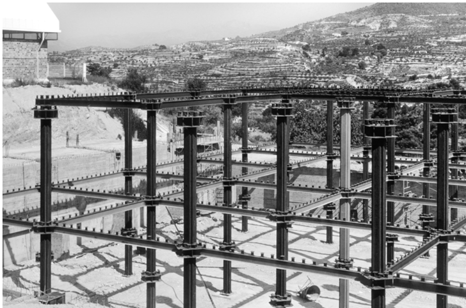
Estructura metálica de la segunda fase
