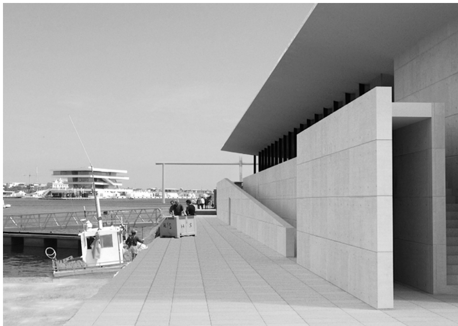
Vista del muelle
