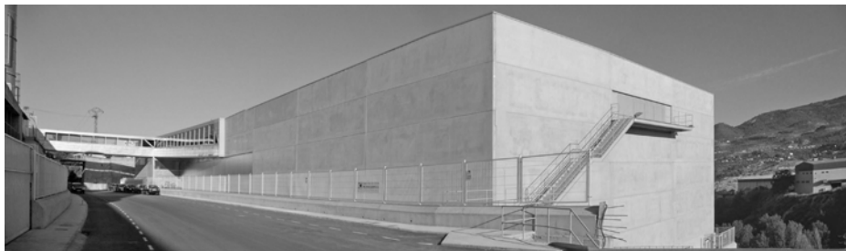
Vista del testero y del alzado norte de la ampliación
