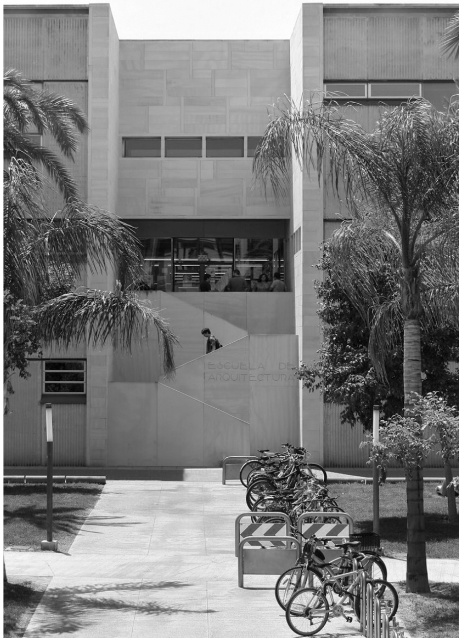
Vista del acceso norte
