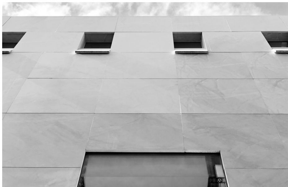
Detalle de la fachada de la calle Primicias
