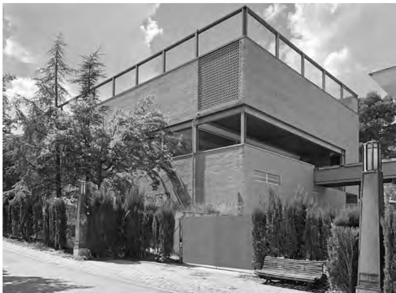
Vista sureste del pabellón de deportes
