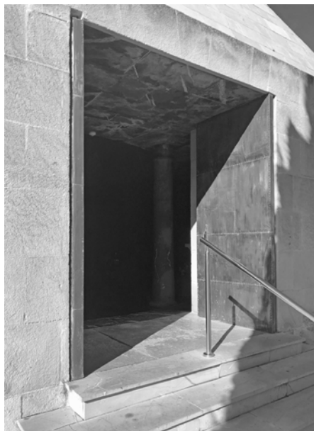
Vista del acceso
