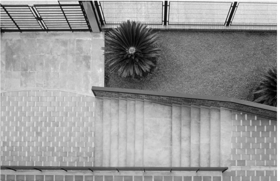
Vista de la escalera exterior
