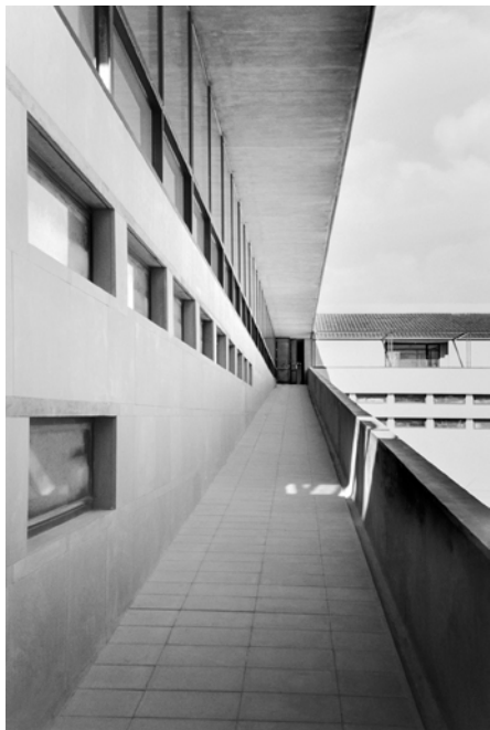
Vista de la rampa exterior
