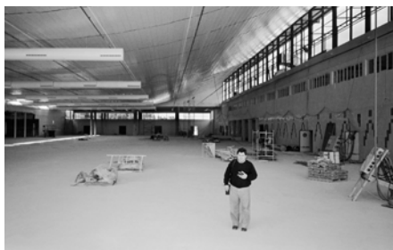
Vista de la sala principal revestida con las bandejas metálicas
