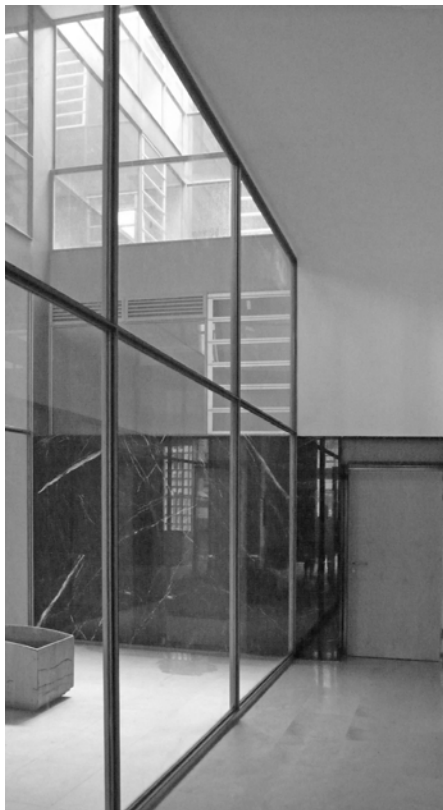
Vista del patio de planta baja
