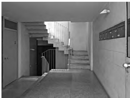
Vestibulo y escalera de las viviendas
