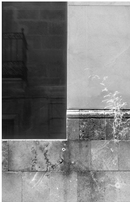
Detalle de la fachada de la calle Primicias
