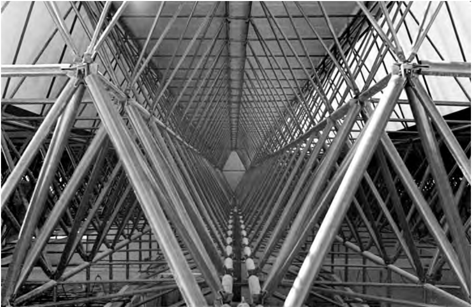
Detalle de la estructura espacial
