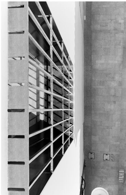
Detalle del cierre de la calle Mayor
