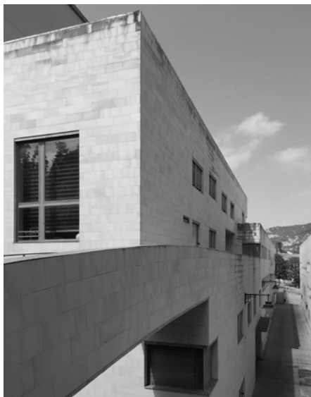
Vista de la calle Sang y pasarela sobre la calle San Mateo
