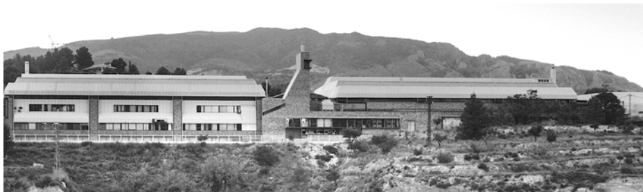
Vista del alzado sur (sin la ampliación)
