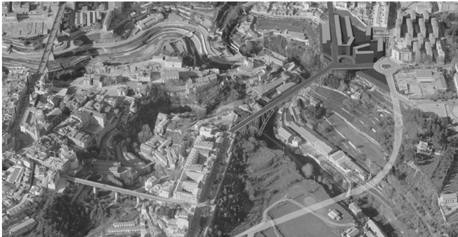
Vista aérea de la conexión entre Viaducto y zona norte
