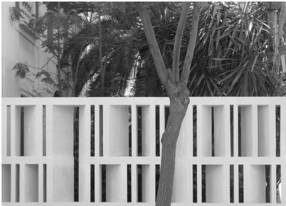
Detalle del vallado exterior
