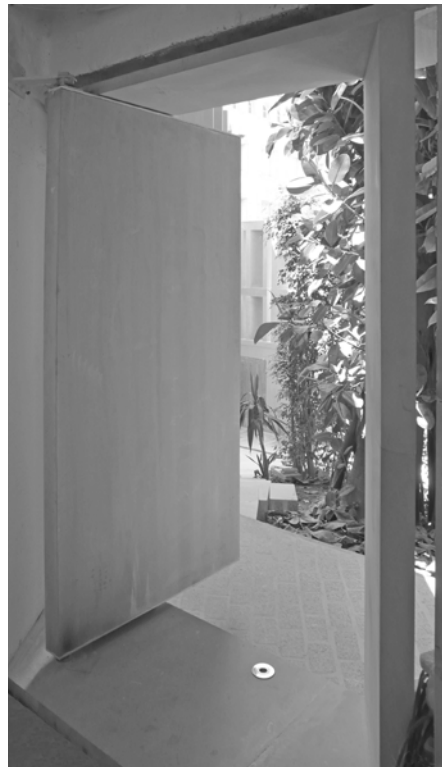
Puerta de piedra de la sala de instalaciones
