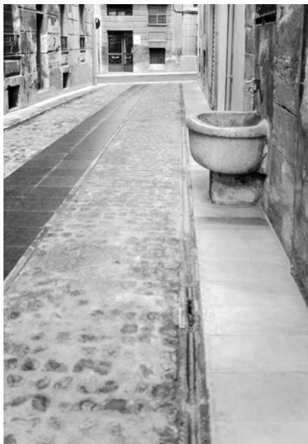
Urbanización de la calle el Tap
