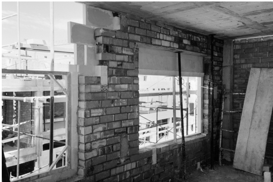
Construcción del cerramiento
