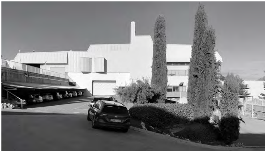
Vista del alzado oeste
