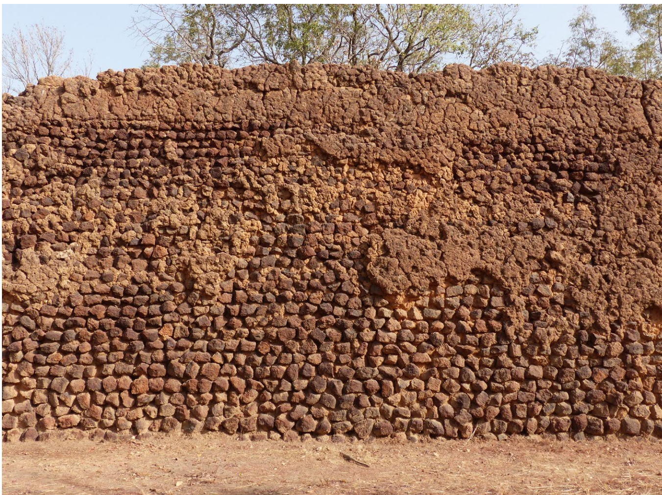
Muro de mampostería de laterita en Loropeni.
