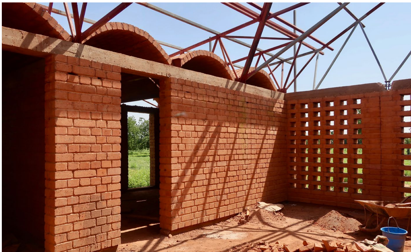
Interior del edificio de la administración en construcción, Fase 2 del proyecto.
