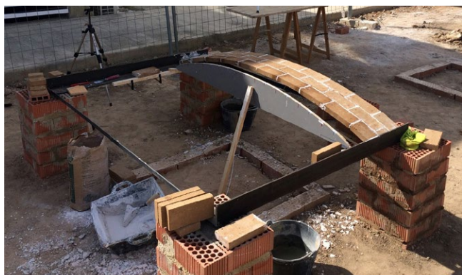
Bóveda tabicada de BTC completa y pruebas para la construcción de tabiquillos para sostener el pavimento
