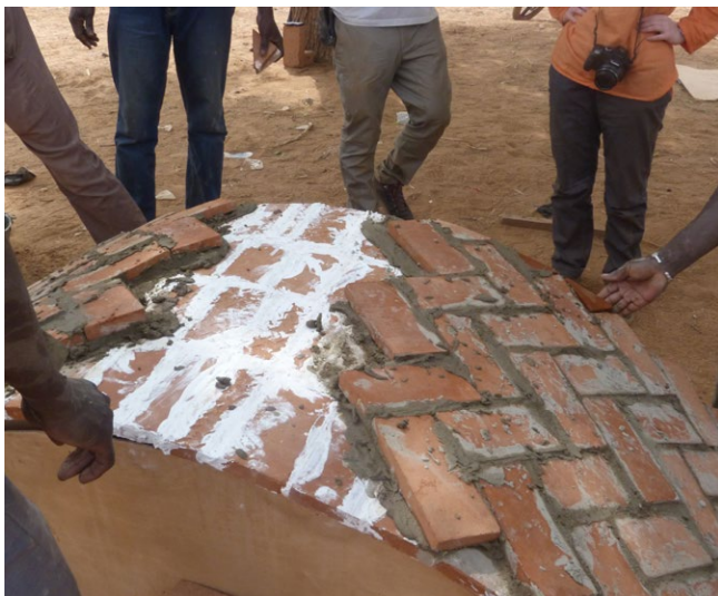
Ejecución de la hoja de doblado.
