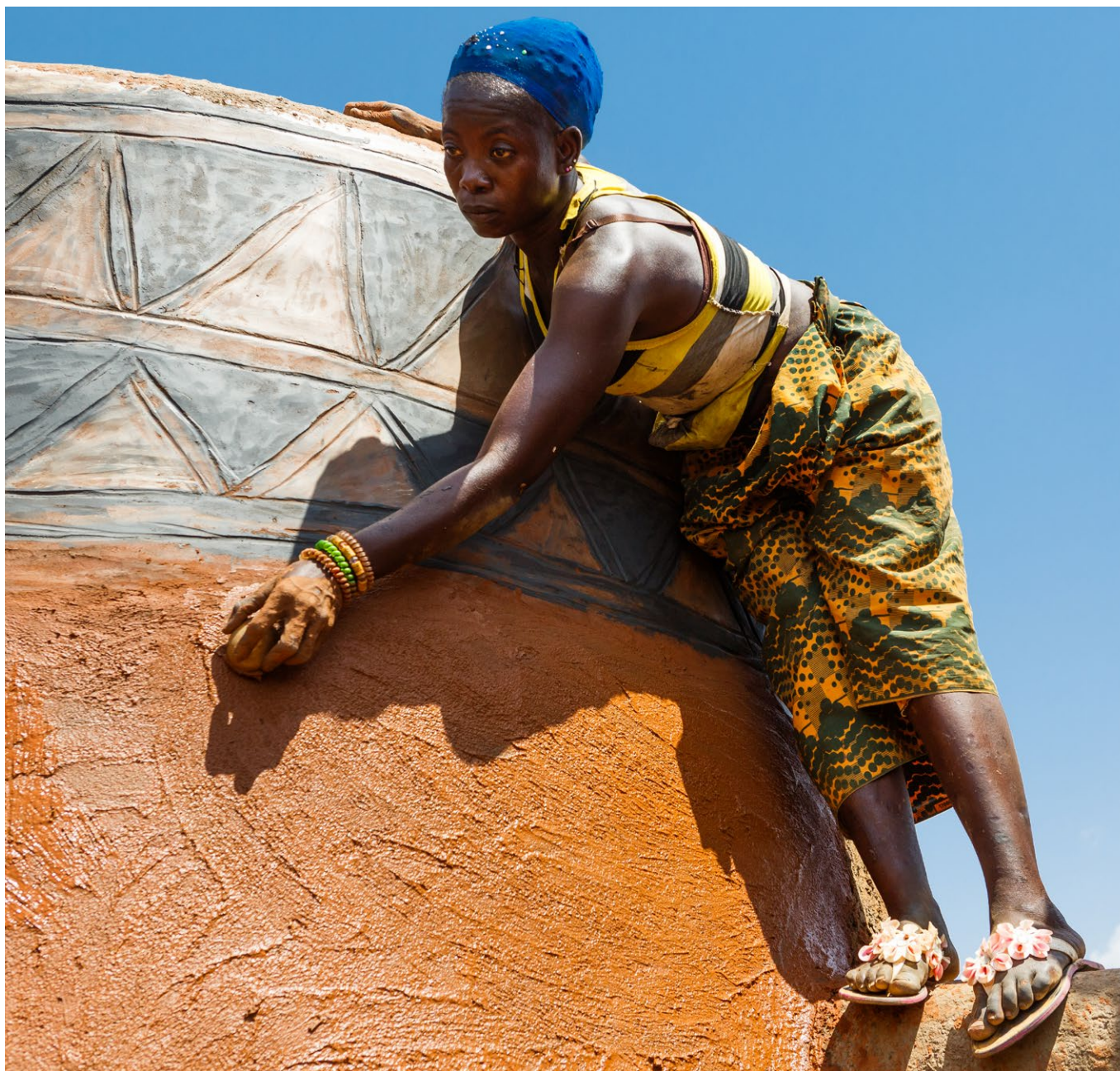
Proceso de refacción de los enlucidos policromos de una vivienda kasena en Tangasogo.
