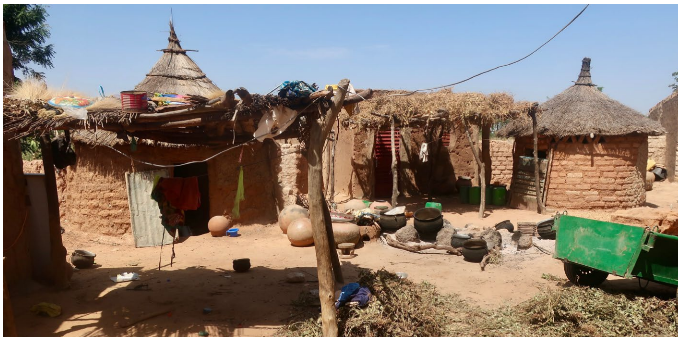
Cobertizos situados junto a la entrada de las construcciones.
