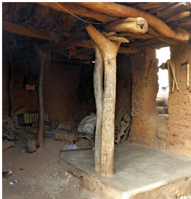
Pilar con el extremo bifurcado para recibir la viga del forjado en una entrada bobo.
