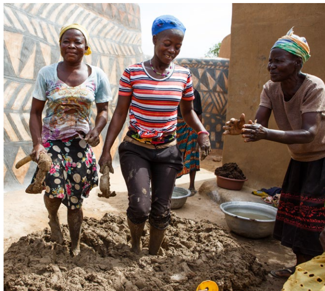
Mujeres kasena empastando el barro con los pies para proceder a tareas de mantenimiento.
