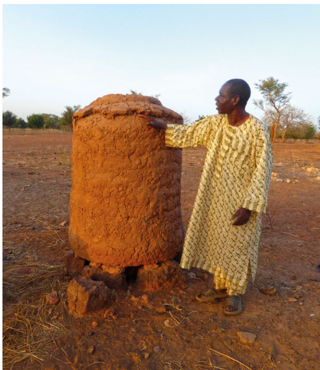
Antiguo silo mossi construido con tierra de termitero.
