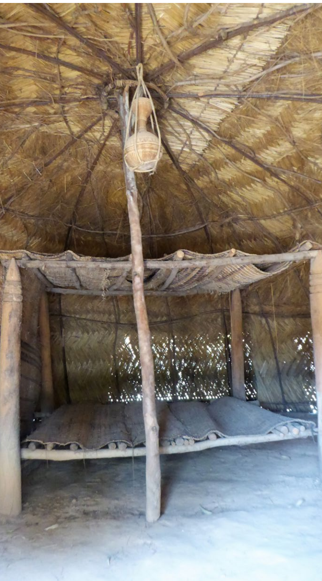
Interior de vivienda peul en muestra en el Museo de Manega, con el poste central polifurcado de apoyo de la cubierta y la plataforma de la cama.
