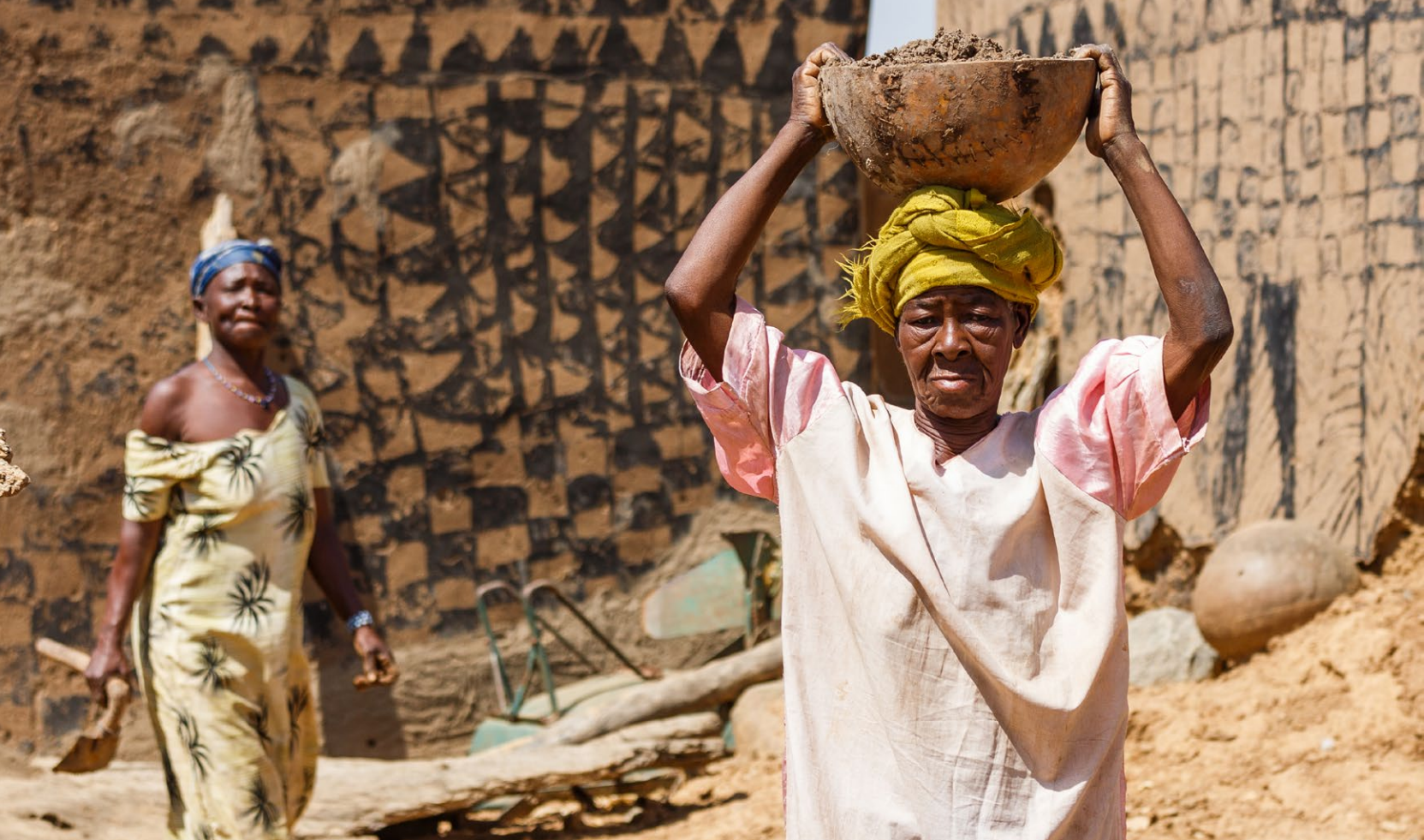
Mujeres kasena transportando barro para realizar las tareas de mantenimiento, enlucido y policromado de los muros.
