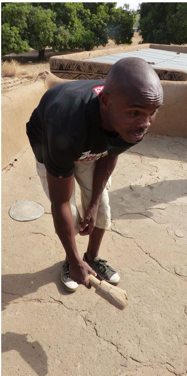
Muestra del sistema de apelmazar la tierra de los terrados de las viviendas kasena durante su reparación con ayuda de un pisón.
