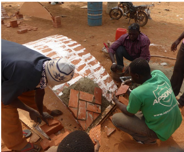
Taller de construcción de bóvedas en el pueblo de Baasneere.
