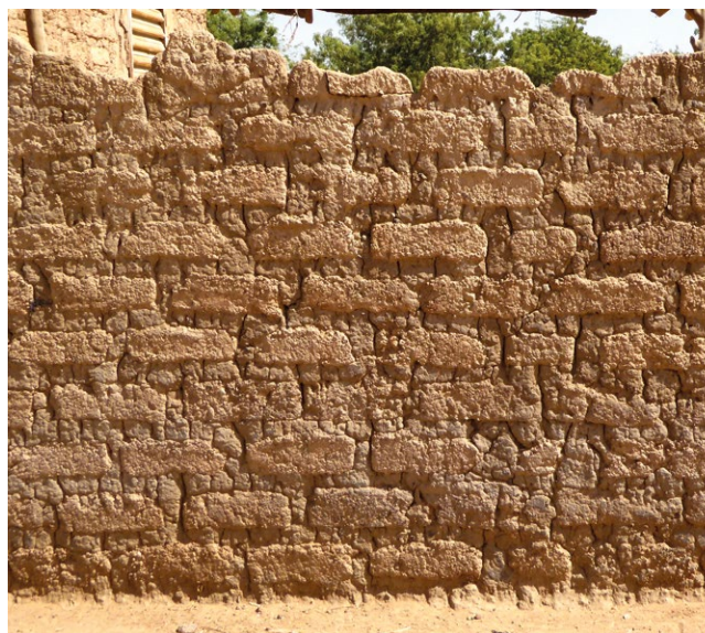
Fábrica de adobes recibida con mortero de barro.
