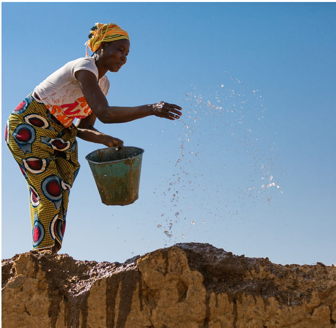
Mujer kasena salpicando de agua el terrado previamente a su reparación.
