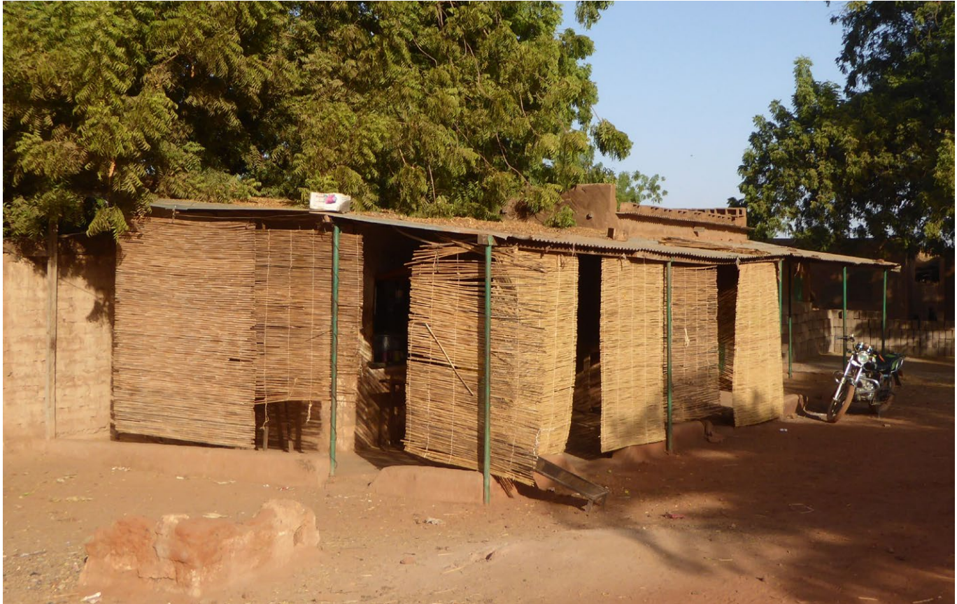
Filtros de esterillas de carrizo para proteger un porche.
