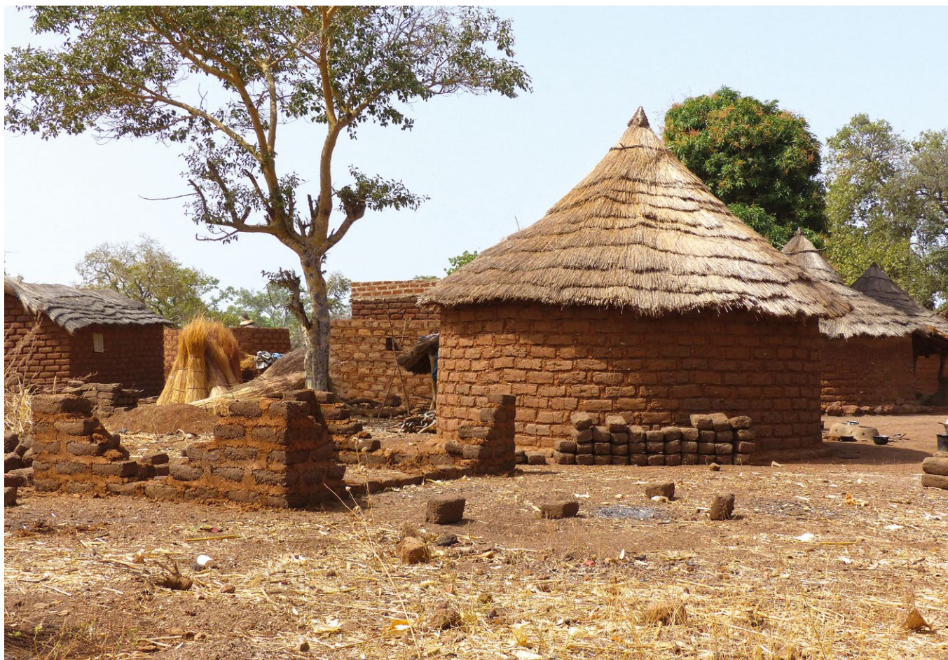
Choza rectangular en proceso de construcción junto a una choza circular en un poblado gan.
