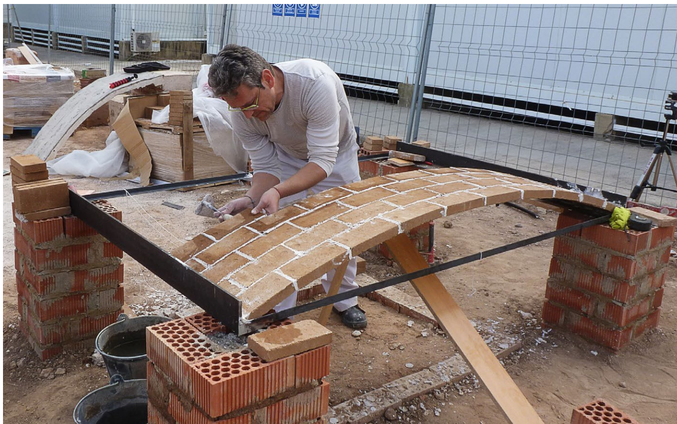
Construcción de un prototipo de bóveda tabicada de BTC en las instalaciones de la Universitat Politècnica de València.
