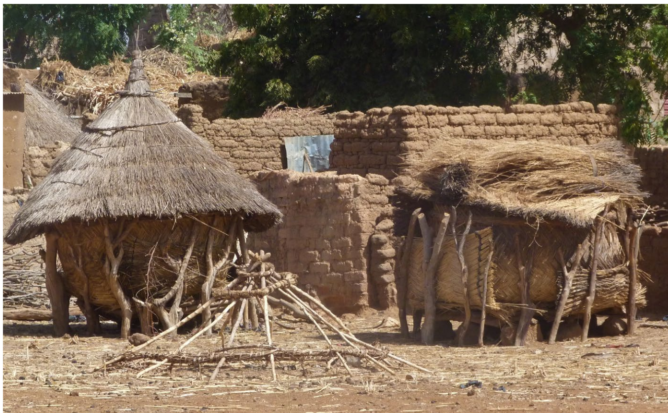
Dos silos mossi, uno cubierto con el caperuzo vegetal y otro descubierto con la estructura cónica de las ramas en proceso de sustitución de la paja.
