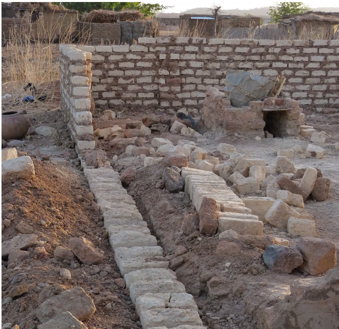
Hilada de adobes empleada a modo de cimentación.
