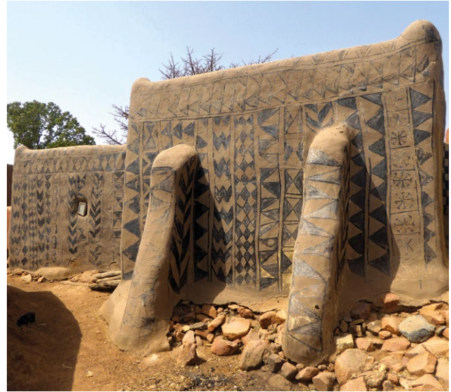
Muro de una vivienda kasena con contrafuertes.
