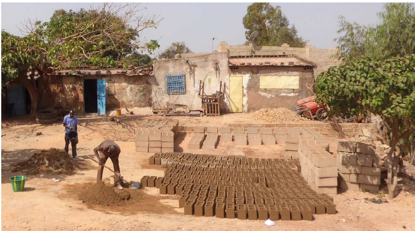
Confección actual de bloques prefabricados de cemento en Banfora.
