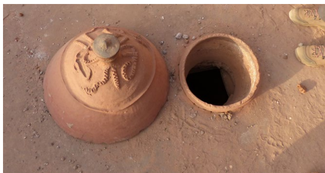
Óculo de iluminación y ventilación en la mezquita de Bobo-Diulasso con su campana cerámica de cubrición.
