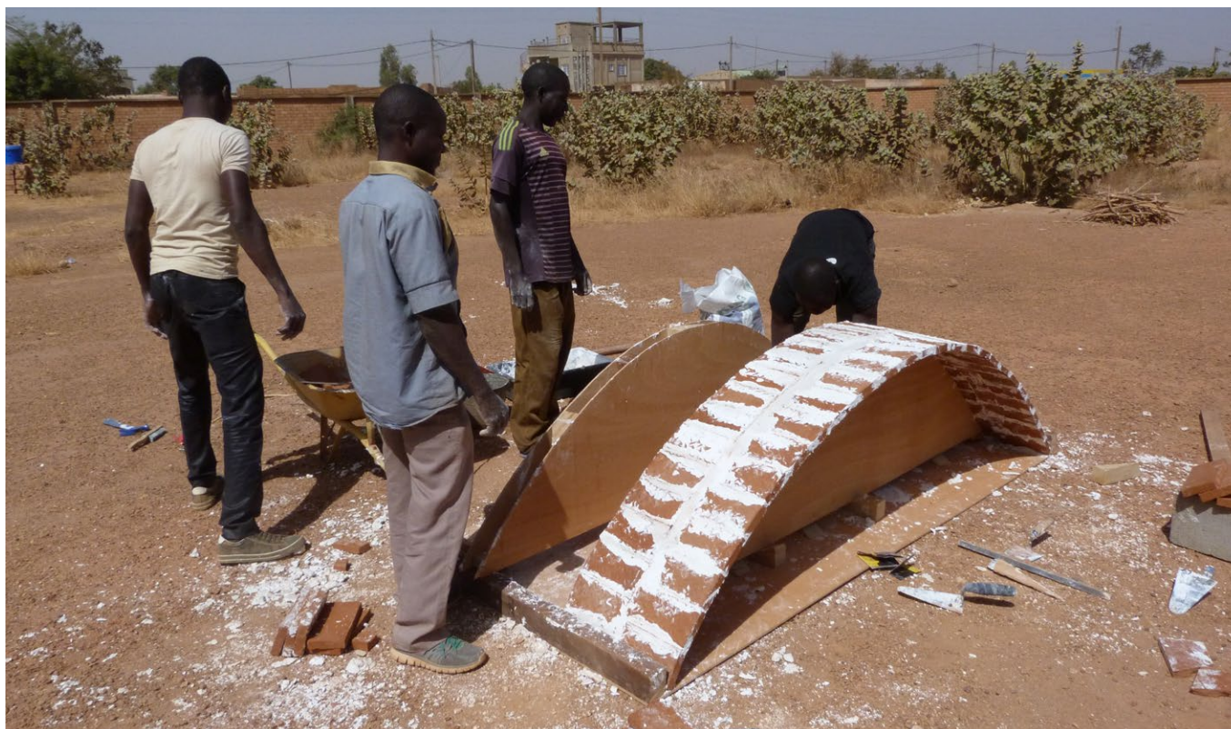
Construcción de la hoja inferior de la bóveda.
