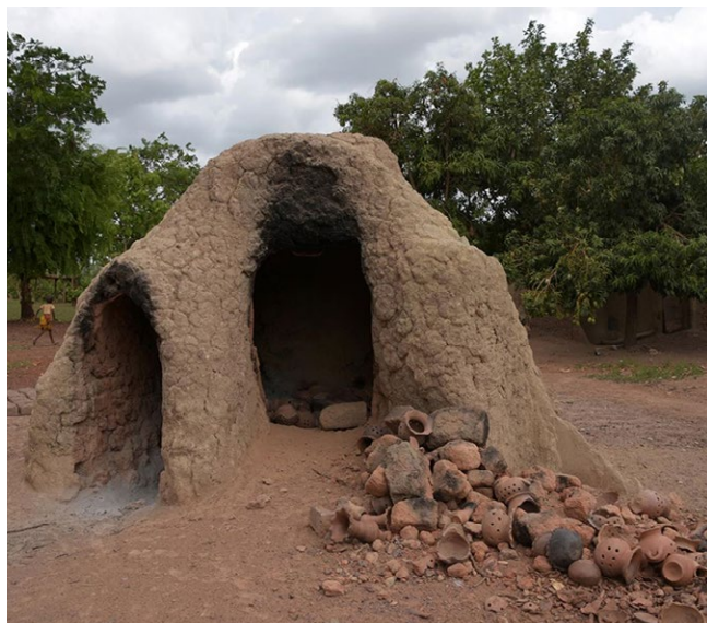
Horno cerámico lobo con sus interesantes bóvedas alabeadas derivadas de la existencia de las dos bocas de acceso.
