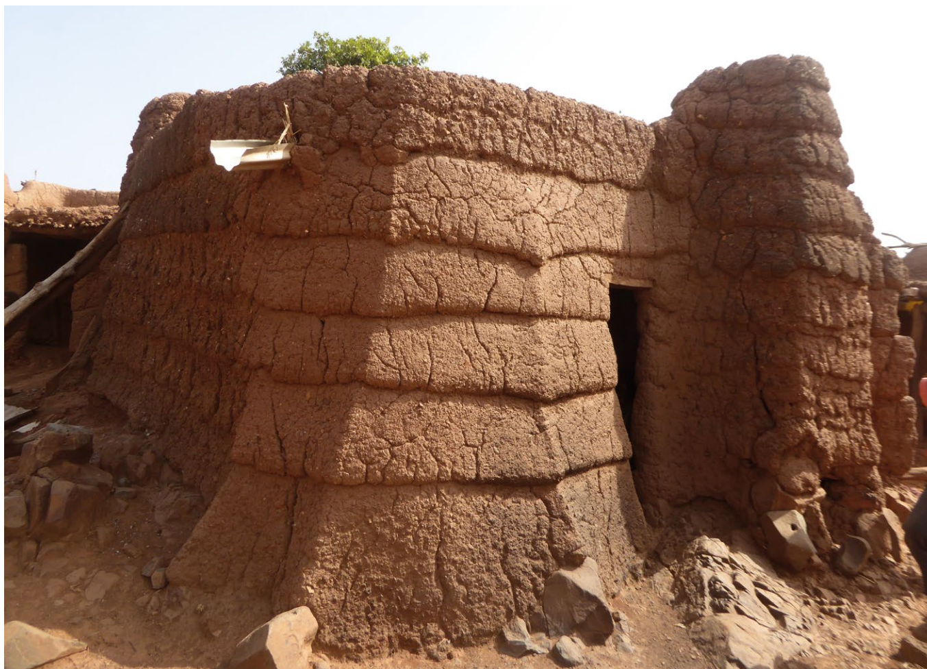
Muros ataluzados de hiladas encabalgadas de una vivienda lobi.
