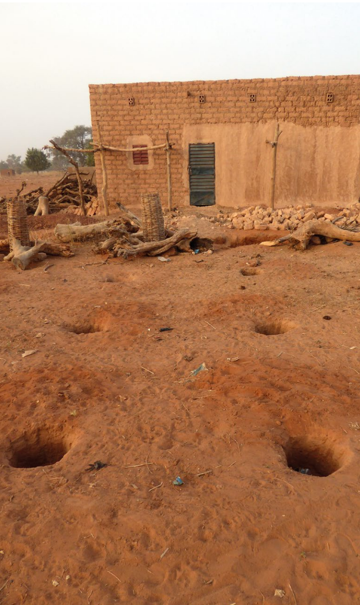
Agujeros realizados en el terreno para la cimentación de postes de madera.
