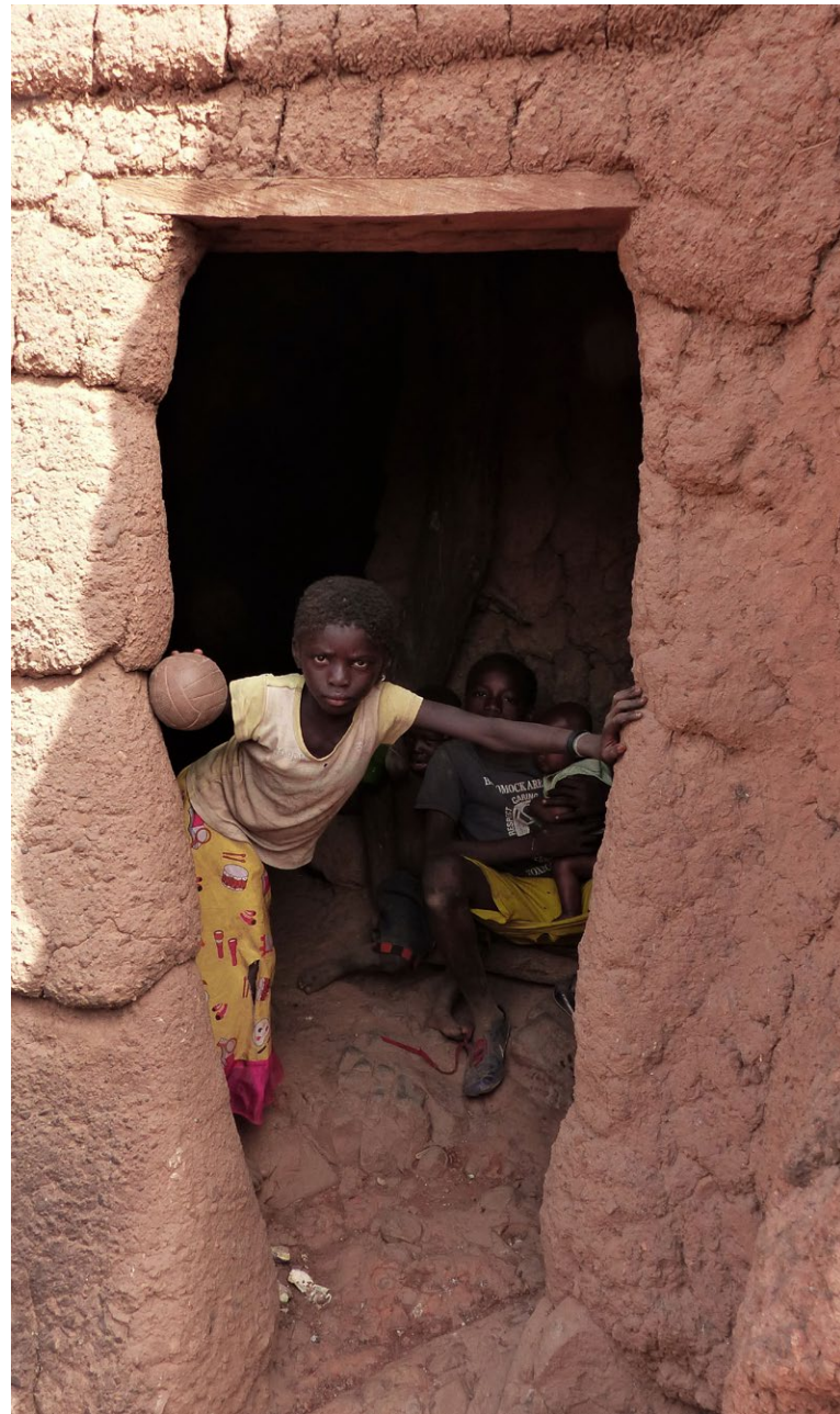
Vano ahusado de acceso adintelado a vivienda lobi.
