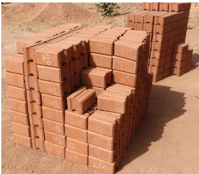
Bloques de BTC acopiados.
