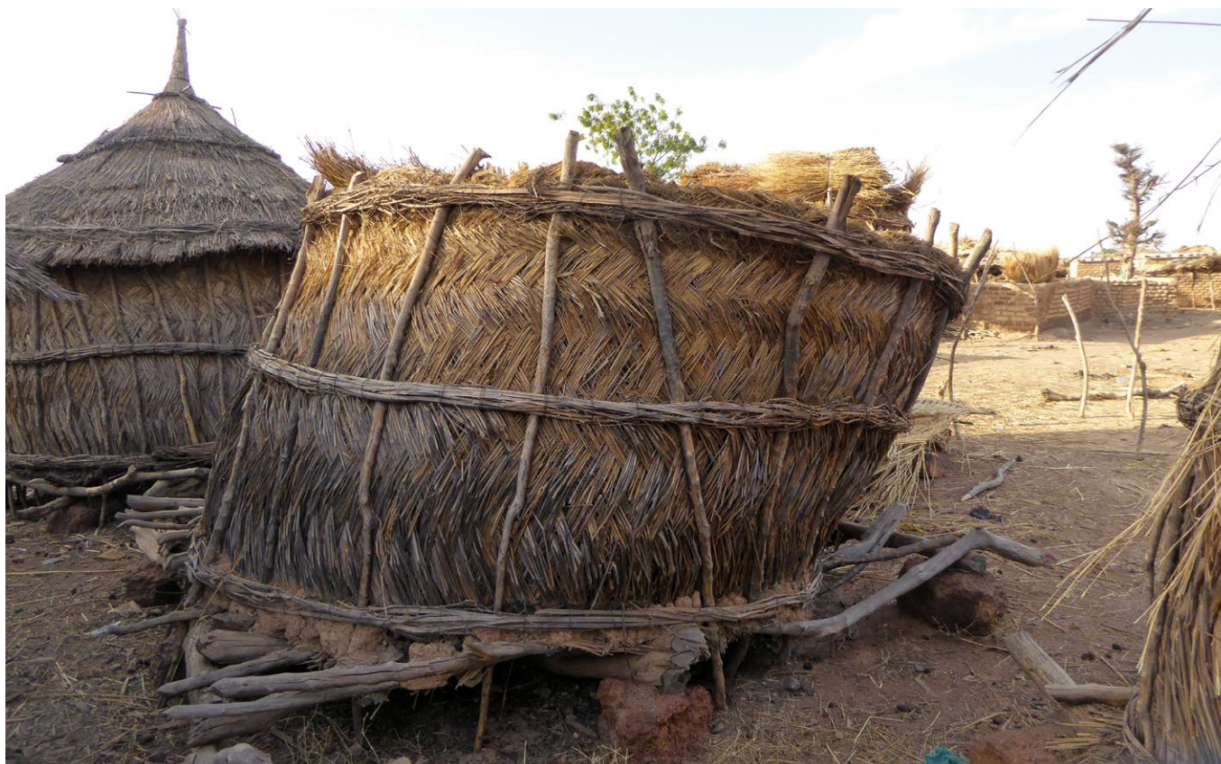
Silo mossi de paredes vegetales que ha perdido su compostura por haberse aflojado sus flejes de lianas y haberse movido la empalizada perimetral.
