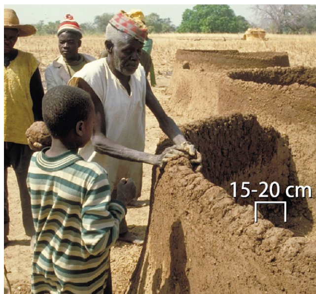
Construcción de pared de mano.
