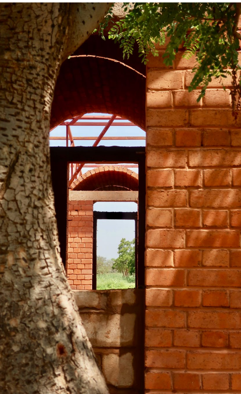
Edificio de la administración en construcción, Fase 2 del proyecto.
