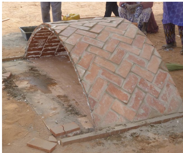
Una bóveda del taller de Baasneere, una vez terminada.
