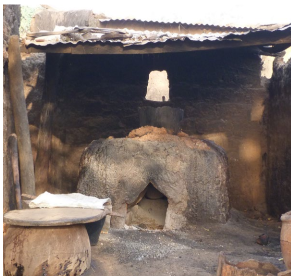
Horno de pan con bóveda rebajada sobre la cual apoyar eventualmente el pan gracias a la cubierta superior de protección que le permite despreocuparse de la evacuación de las aguas.
