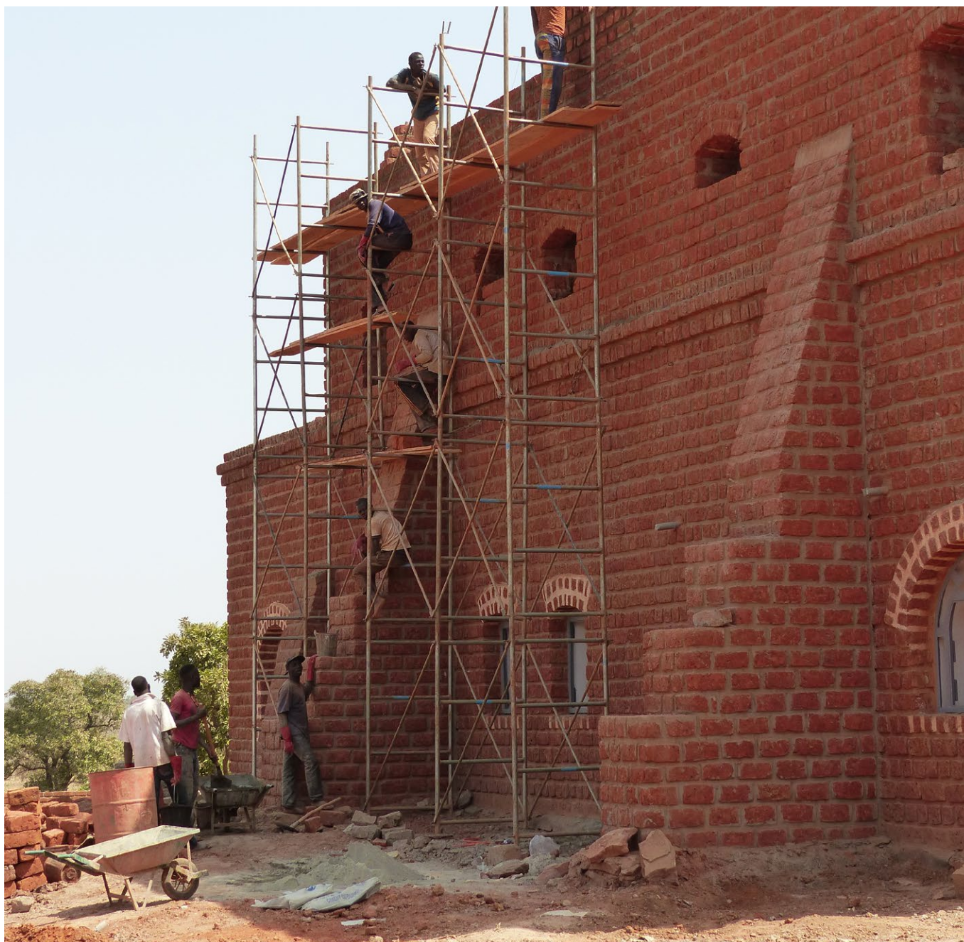
Construcción del Centro de Investigación sobre el karité en Satiri, Bobo-Dioulasso (Burkina Faso), diseñado por Chiara Rigotti.
