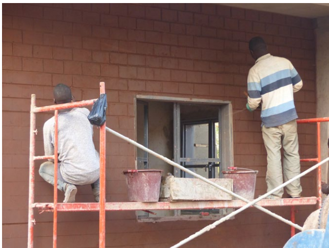
Enlucido de tierra con despiece de sillería.
