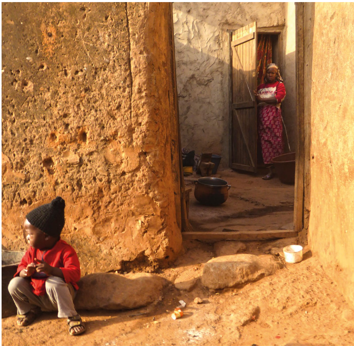
Umbral. Doble umbral de una casa bobo, el exterior a la calle y el interior al patio.
