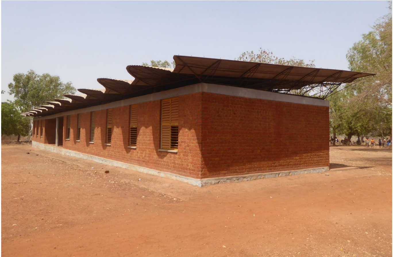
School at Dano (Burkina Faso) , diseñada por Francis Kéré.
