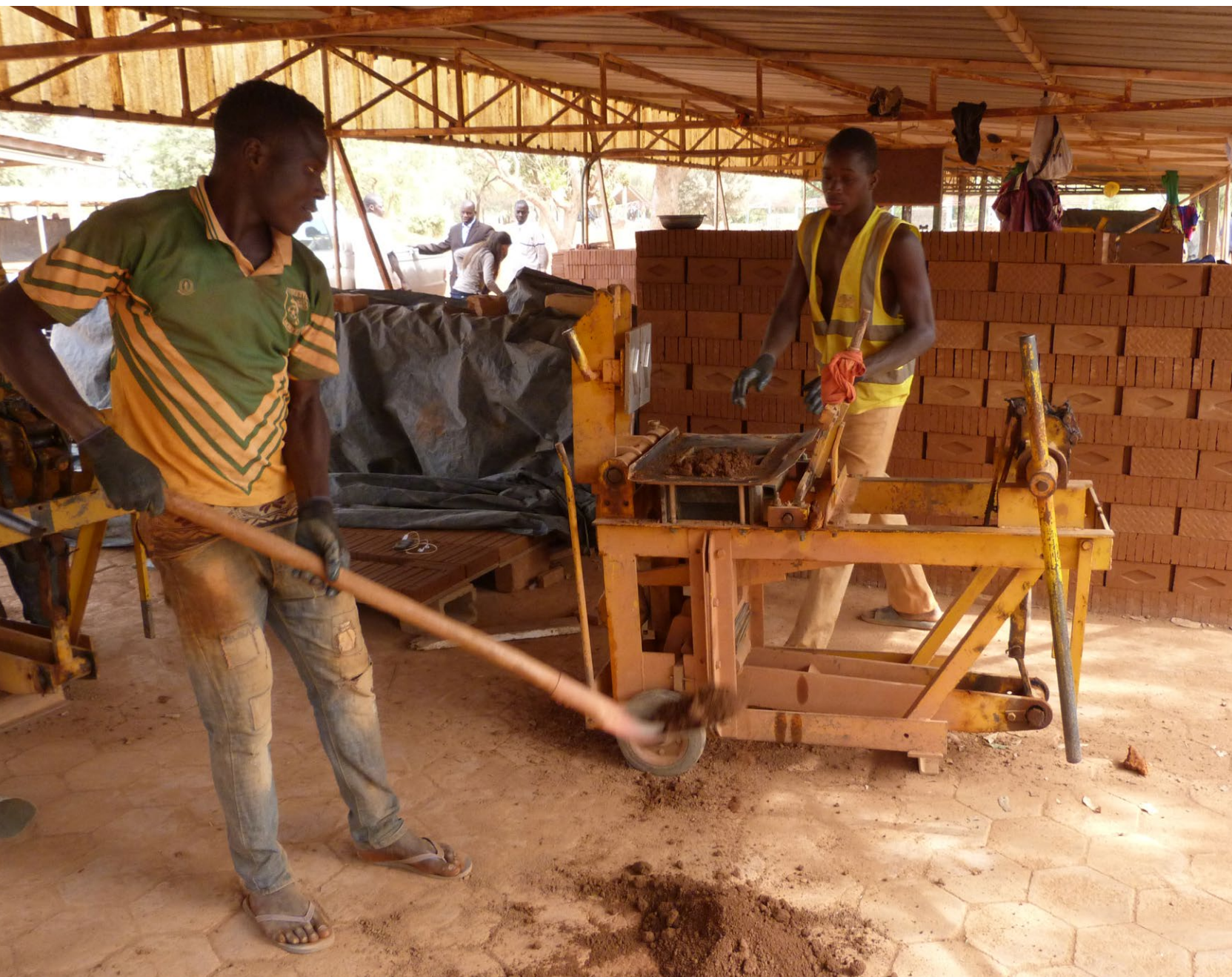
Producción local de bloques de tierra comprimidos o BTCs en Ouagadougou.
