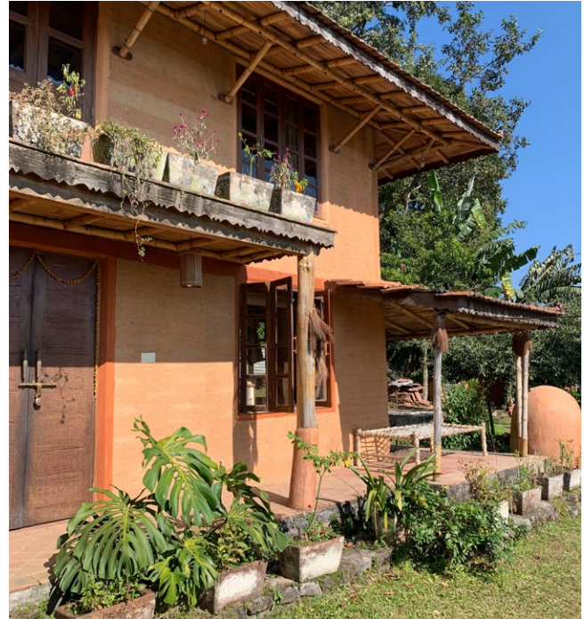
Vivienda y talleres construidos por Abari en Dhulikhel, Nepal.
