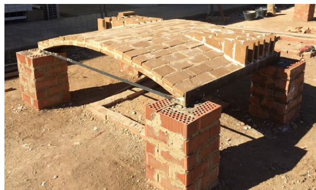
Bóveda tabicada de BTC completa y pruebas para la construcción de tabiquillos para sostener el pavimento
