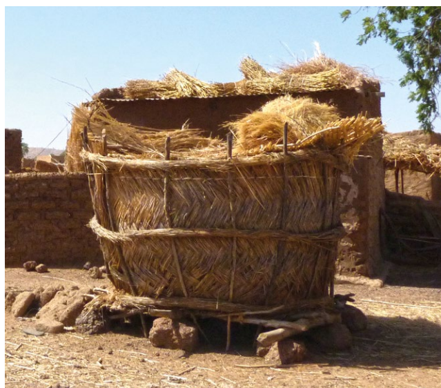
Recipiente. Cuando se les retira la cubierta cónica vegetal, los silos de esteras se revelan como los grandes contenedores que son.
