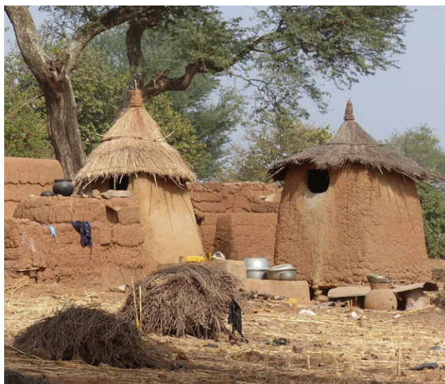
Dos silos lobi de carácter exento con sus respectivos caperuzos vegetales y sus bocas de acceso en la parte superior.
