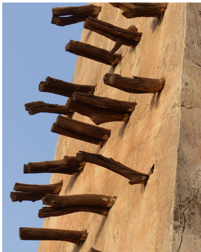
Detalle de los palos y ramas para escalar la torre de la mezquita de Bobo-Dioulasso.
