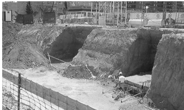
Figura 2. Talud natural en bermas en vaciado de sótano.
