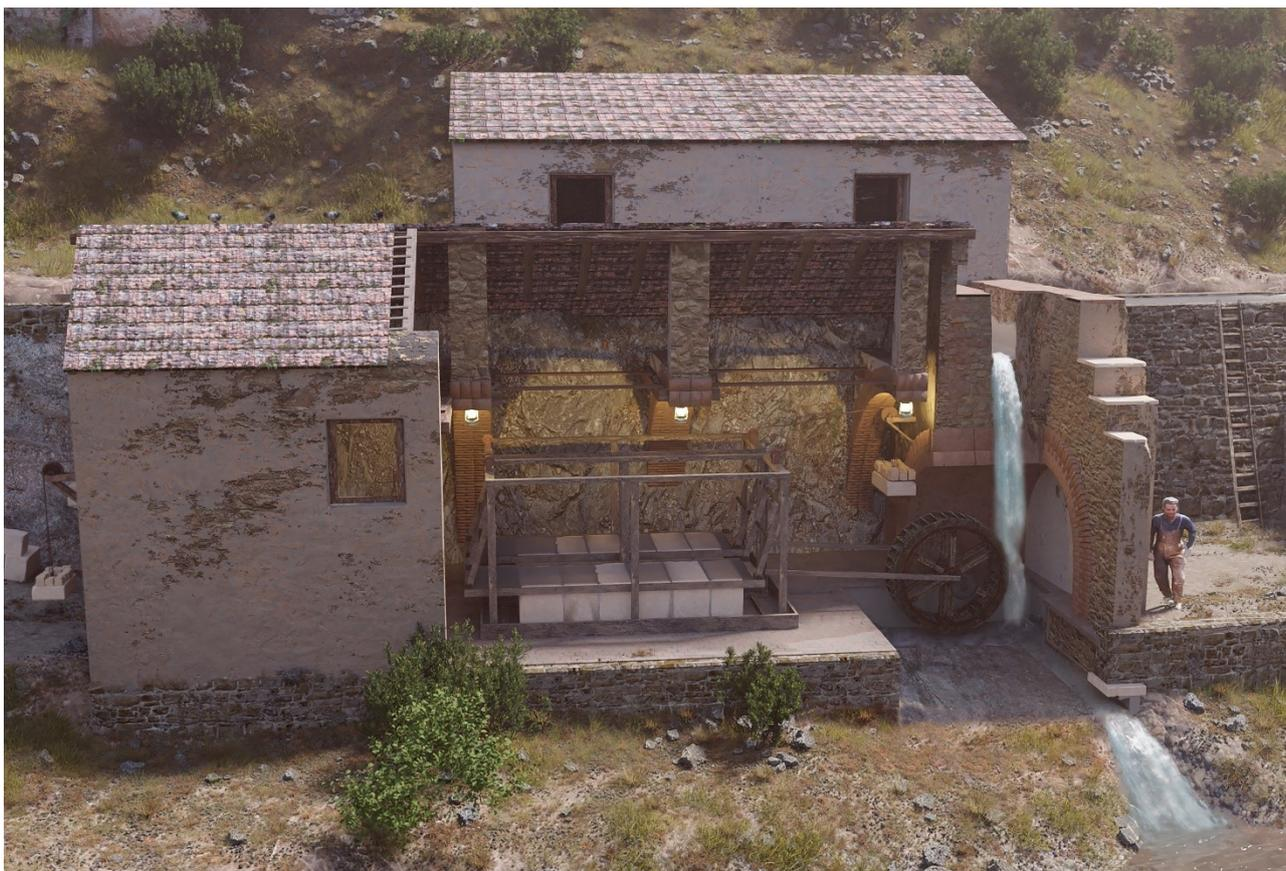
**Figura 13:** Vista renderizada de la fábrica de Nicoli seccionada para observar la disposición de los artes de corte y las estructuras hidráulicas internas.
