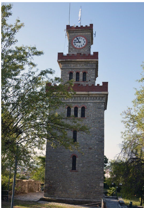
Fig. 11- Documentazione fotografica della Torre dell'orologio (Adriana Trematerra, 2020)
