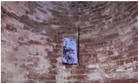
Fig. 8 - Detalle del cuerpo de la garita 4 de Mas Cabanyes de fábrica de ladrillo. Fotografía propia.
