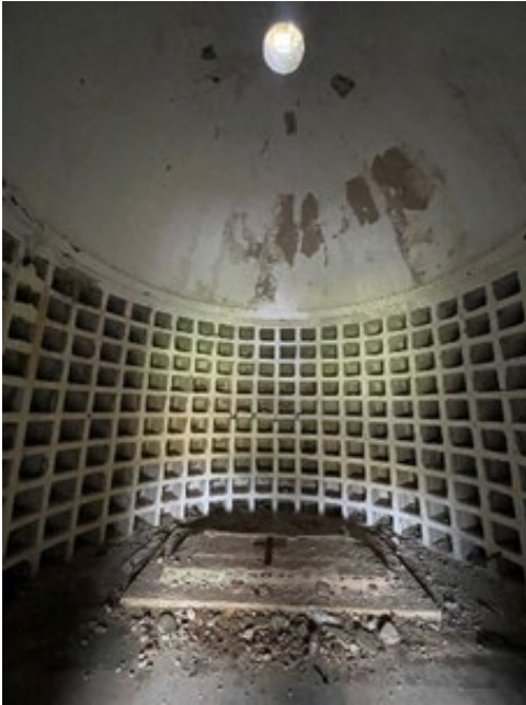
Fig. 12- Estado actual del frontal interior con los nichos perimetrales y los restos del altar.
