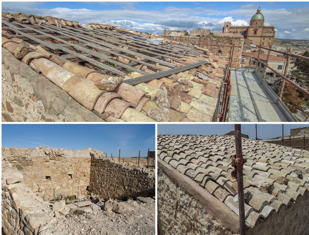
Fig. 5– Il cantiere di restauro del 2022: riconfigurazione della copertura in cotto siciliano della torre sud-est (autori).
