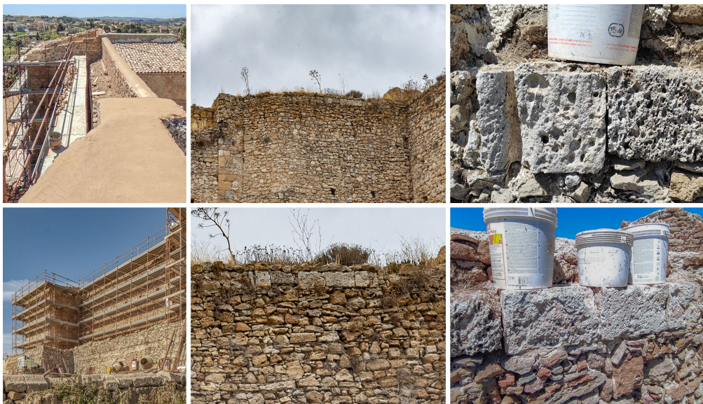
Fig. 4- Il cantiere di restauro: a sinistra, fasi di cantierizzazione e protezione delle creste murarie con bauletto in cocciopesto; a destra, interventi conservativi dei conci in pietra calcarea bianca, di una bifora sul prospetto est (autori).
