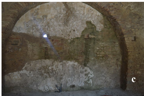
Fig.11- Foto d'archivio prima del restauro
