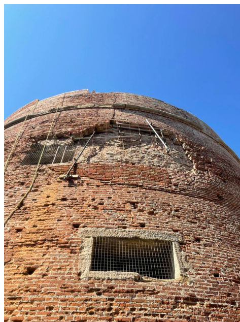
Fig. 3— Inizio integrazione muraria mancanza bastione Sud-Est (Impresa Edile Franco s.r.l., 2022)
