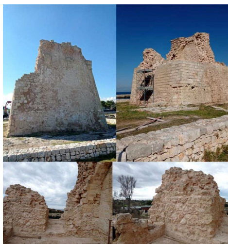
Fig. 4- Interventi di messa in sicurezza della torre (Comune di Monopoli, Soprintendenza ABAP Bari, 2021).
