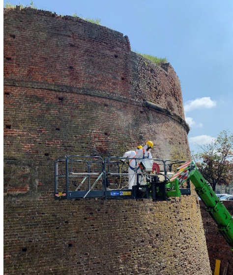
Fig. 1– Trattamento biocida (Gentilini, 2022)
