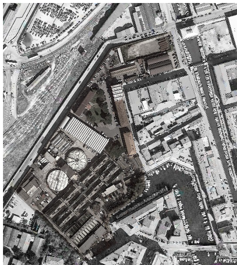
Fig.3– Depuratore-Rivellino, stato attuale. (Google earth, 2019)
