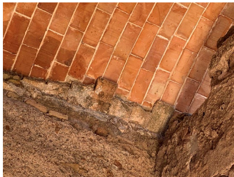
Fig. 11- Punto de encuentro entre los restos de la bóveda tabicada histórica y la nueva bóveda tabicada construida encima. El aparejo es el mismo, pero el color y la dimensión de los ladrillos es ligeramente diferente para que se puedan distinguir (Autores: Vegas y Mileto).
