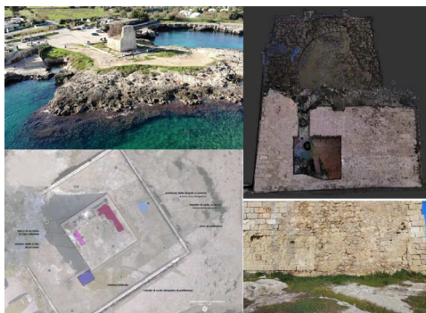
Fig. 3- Indagini eseguite sulla torre (Comune di Monopoli, rilievi Landnet Srl, 2021)
