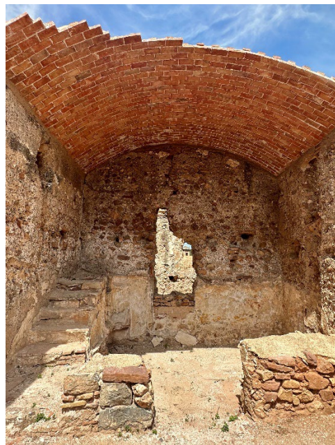
Fig. 12- La bóveda tabicada inacabada que cubre una parte de la sala meridional (Autores: Vegas y Mileto).
