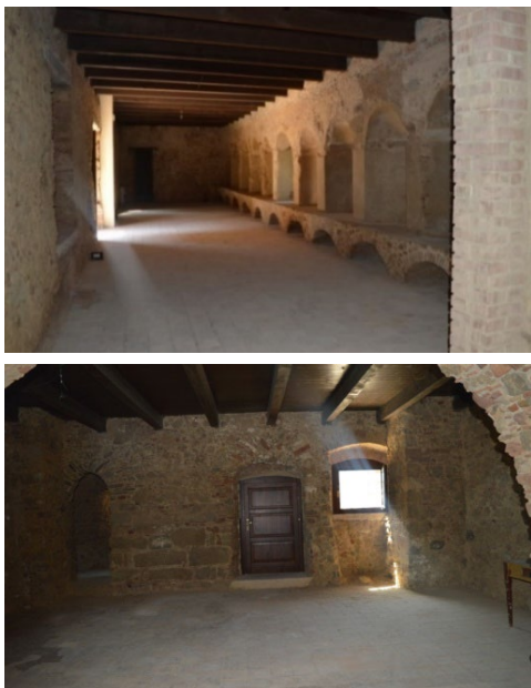
Fig.14- Solai in legno
