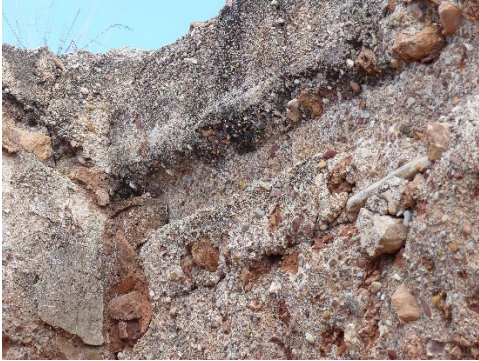
Fig. 4- Hendidura ejecutada con el encofrado del muro con el objetivo de alojar al arranque de la bóveda (Fotografía: Vegas y Mileto).
