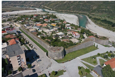
Fig. 5- Tepelene, veduta aerea della fortezza
