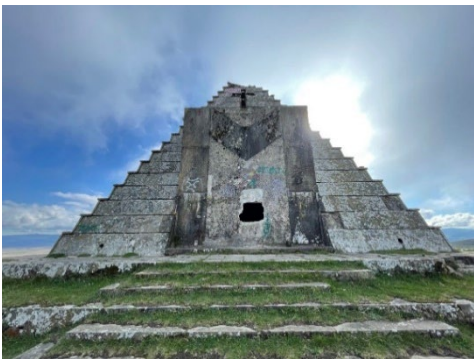
Fig. 13- Estado actual de la fachada sudeste con los peldaños de acceso y la entrada parcialmente tapiada.
