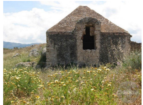
Fig. 4- Fortaleza de Retino (Creta). SXVI. Almacén de pólvora con remate piramidal, capaz de mitigar los impactos de artillería.
