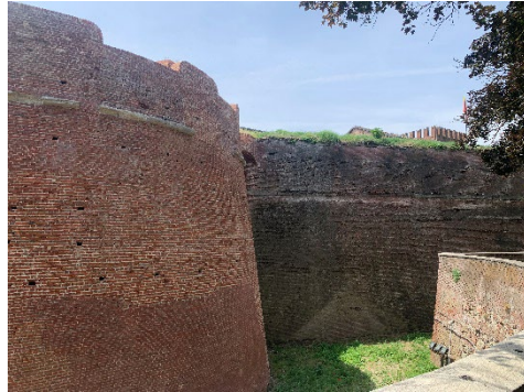
Fig. 7– Vista del bastione Nord-Est restaurato verso la cortina settentrionale da restaurare (Gentilini, 2023).
