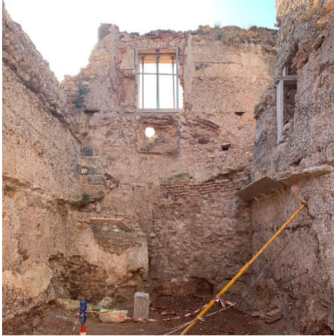
Fig. 8- La sala este tras la excavación arqueológica. Se aprecian las huellas de las bóvedas en diversos niveles y al fondo el depósito de líquido (Autores: Vegas y Mileto).
