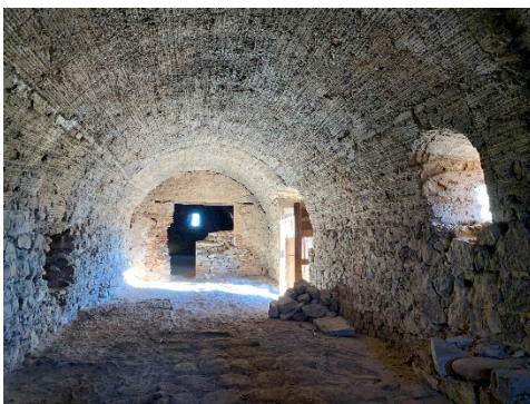
Fig. 2- Bóvedas que cubren los espacios semienterrados del castillo de Petrés (Fotografía: Vegas y Mileto)
