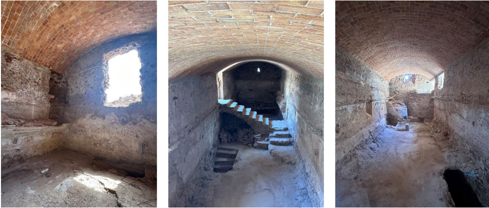
Fig. 13- Los espacios de la sala noreste (a la izquierda) y este (al centro y a la derecha) tras la construcción de las bóvedas tabicadas (Autores: Vegas y Mileto).
