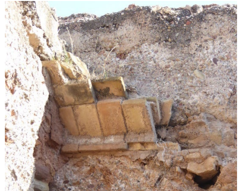
Fig. 3- Restos del arranque de la bóveda que cubría la habitación noreste de la planta baja del castillo de Petrés (Fotografía: Vegas y Mileto).
