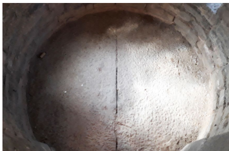
Fig. 7 - Ménsula de granito de dos piezas de la garita 2 del Castell de Pallejà . Fotografía propia.
