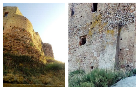
Fig.10- Foto prima del restauro
