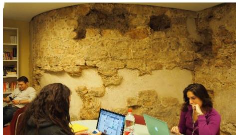
Fig. 4- Vestigios del torreón situado en el interior de un edificio de la calle de las Rocas. Es de destacar el adorno mediante pequeñas piedras de color negro incrustadas en la argamasa de la mampostería.
