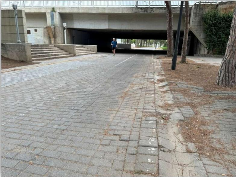
*Ilustración 21: Estado del firme carril bici*
