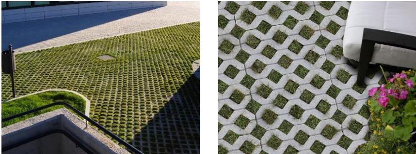
Figura 78. Sistema pavicesped. 2024. Fuente: pavicesped.com
