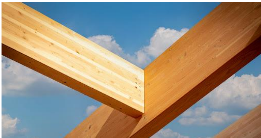
Figura 79. Unión viga-vigueta madera. 2024. Fuente: Maderasantana.com
