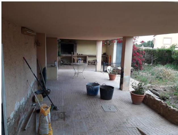
Figura 15. Fotografía Porche trasero. 2024. Fuente: Propia
