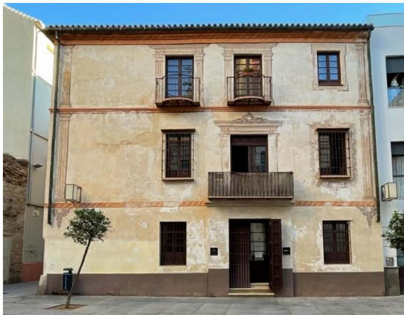
Figure 3. Street Arco de la Cabeza two on the corner of Plaza Virgen de las Penas 5. Source: Royo, L. (2023)
