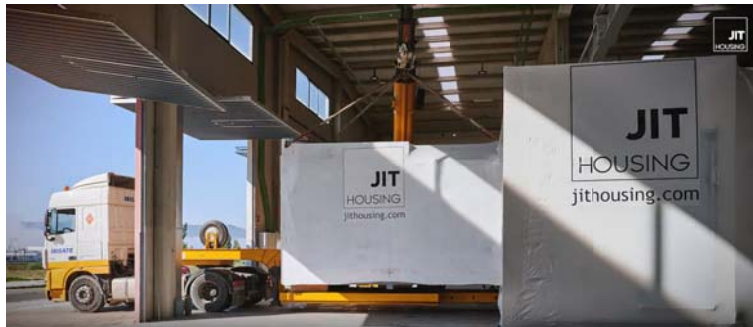
Fig. 8 Transporte de módulos. Fuente: JIT Housing (2023)
