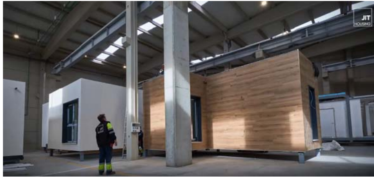
Fig. 7 Cadena de módulos en fábrica. Fuente: JIT Housing (2023)
