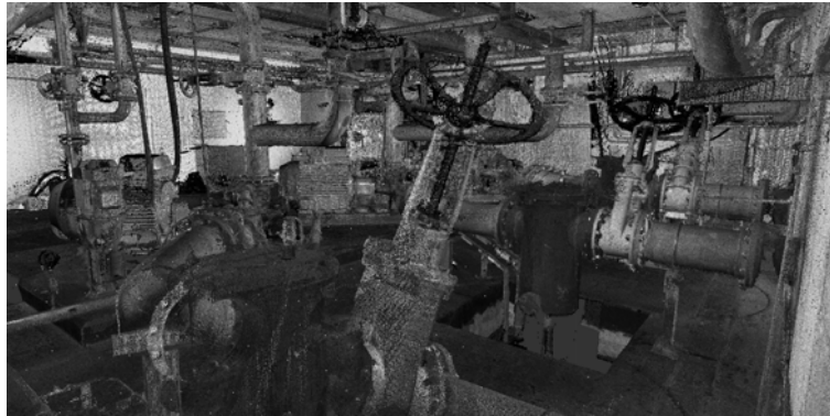
Fig. 2 Nube de puntos de la sala de PCI del edificio BEC. Fuente: elaboración propia.
