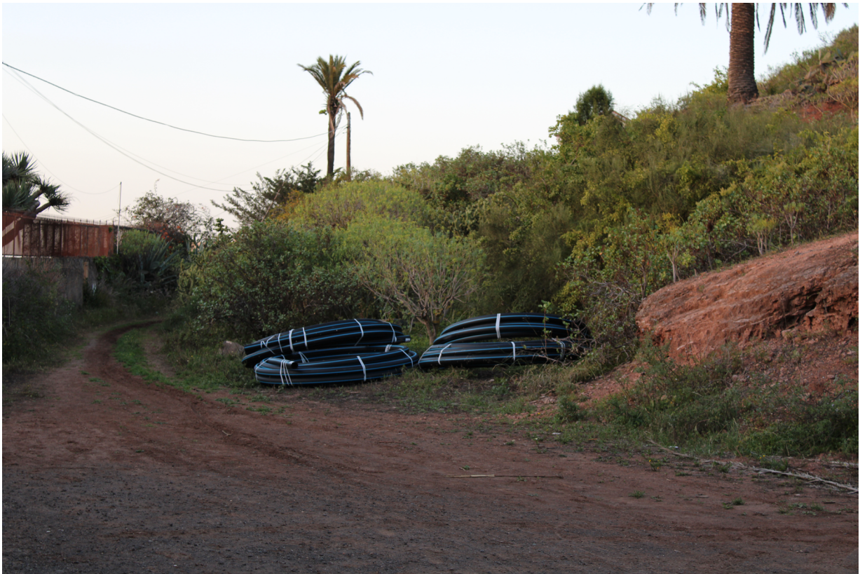
Fig. 85. Tuberías esperando a ser instaladas justo donde el acueducto.
