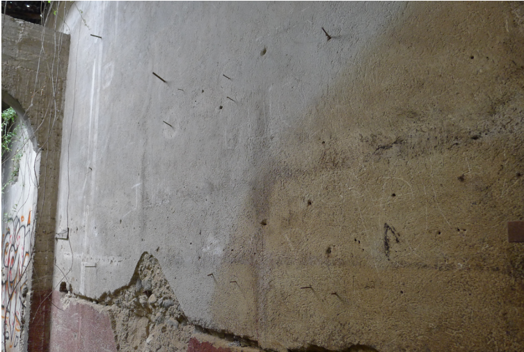
Fig. 105 y 106. El agua ha cambiado . Instalación del proyecto para el PAM! 24 Detalle de los clavos.
