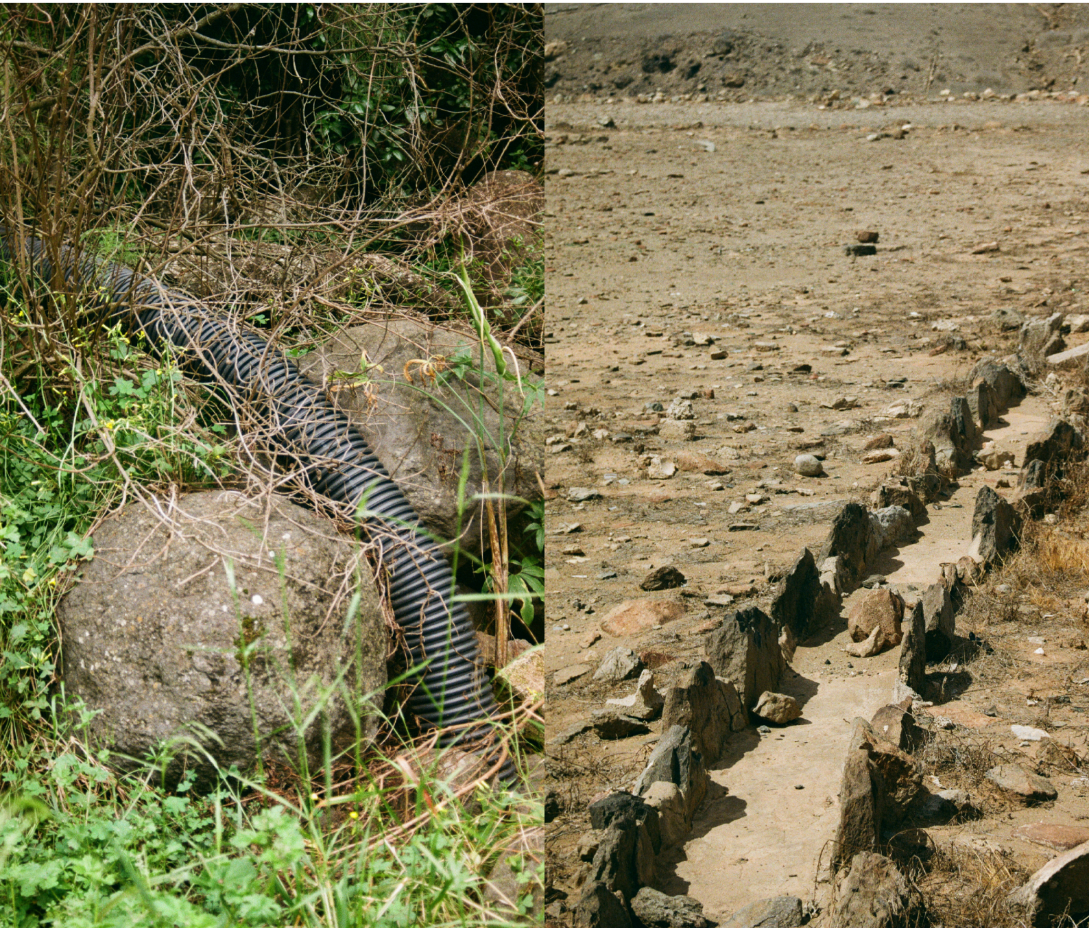
Fig. 96 y 97. El agua ha cambiado . Tubería en el Barranco Alonso y acueducto en Montaña Arena..
