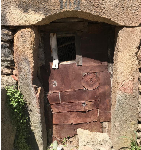
Fig. 12. Puerta forrada con chapa reciclada.
