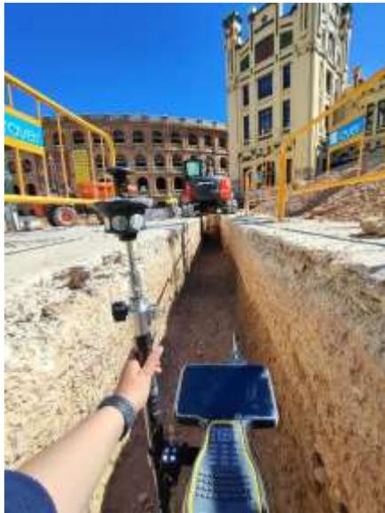
Ilustración 14. Zanja telecomunicación
