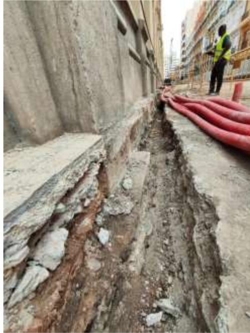
*Ilustración 4. Excavación muros guía*
