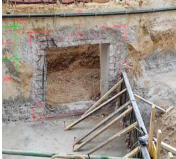
*Ilustración 11. Hueco en la losa para colector*
