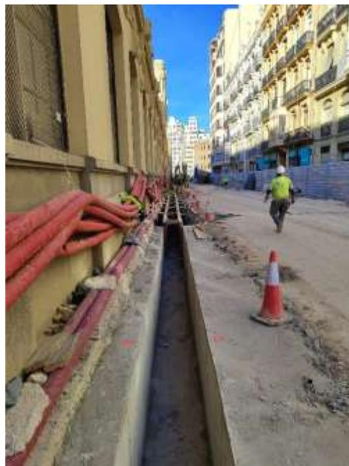
*Ilustración 5. Construcción muros guía*
