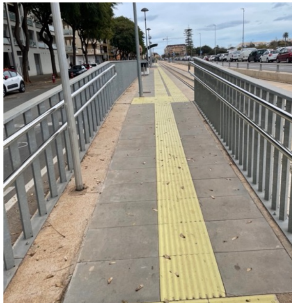
Figura 39. Vista general de la rampa accesible a dicha parada.
