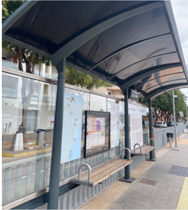
Figura 38. Vista general de la parada de TRAM Pedrera-Vessanes en la avenida Joan Fuster.
