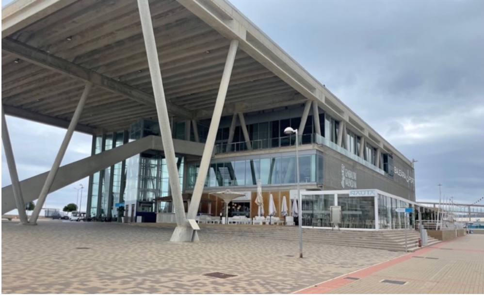
Figura 43. Vista general de la estación marítima de Denia.
