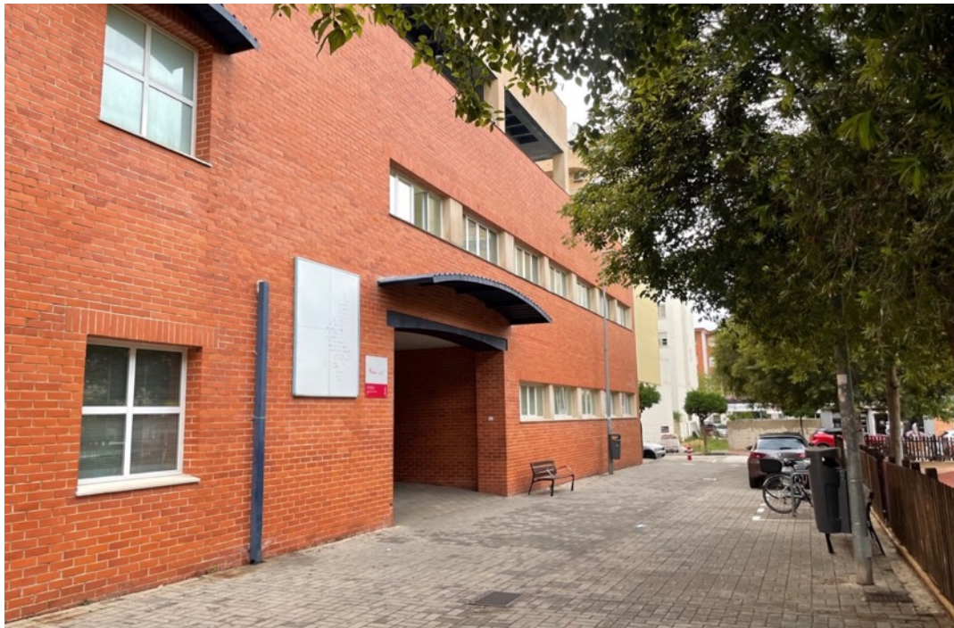
Figura 7. Vista general del centro de salud Joan Fuster.
