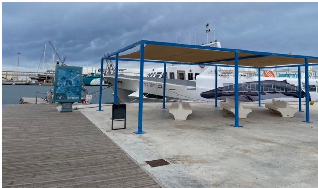
Figura 44. Vista general de la estación de salida de La Panseta.
