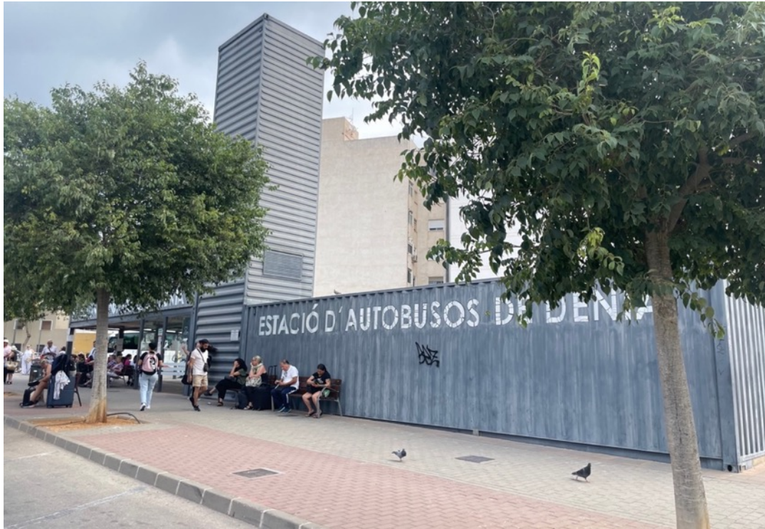
Figura 35. Vista general de la estación de autobuses de Denia.
