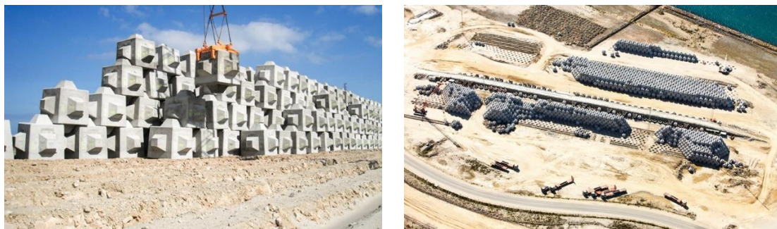
Figura 149: Acopio de Cubípodos.
