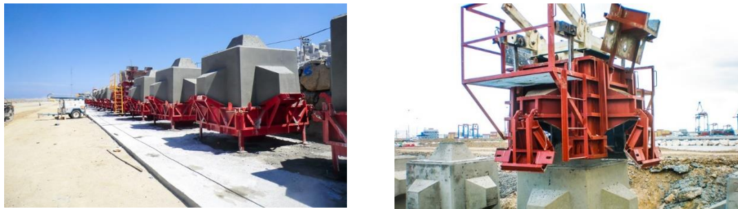
Figura 147:Encofrado del Cubípodo.
