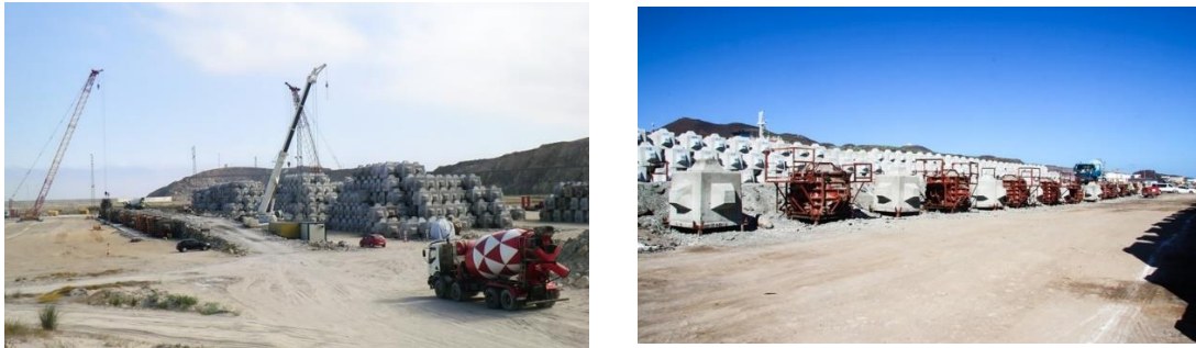
Figura 148: Hormigonado de los Cubípodos en obra.
