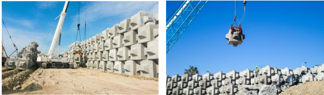
Figura 150: Manipulación del Cubípodo.
