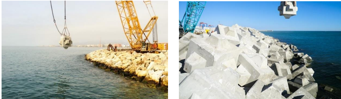
Figura 152: Colocación del Cubípodo.
