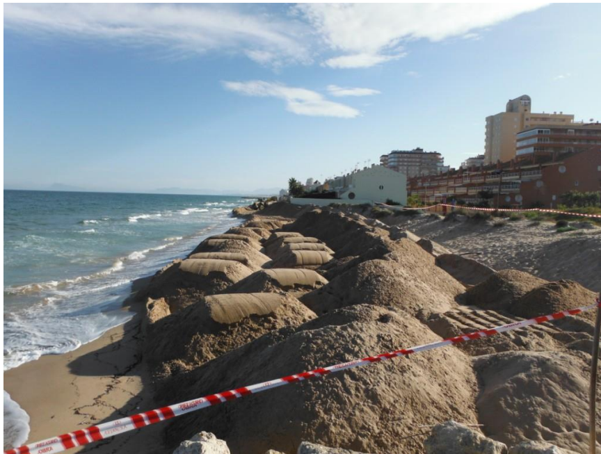
Figura 120: Traslado de arena en la playa de Tavernes de la Valldigna.
