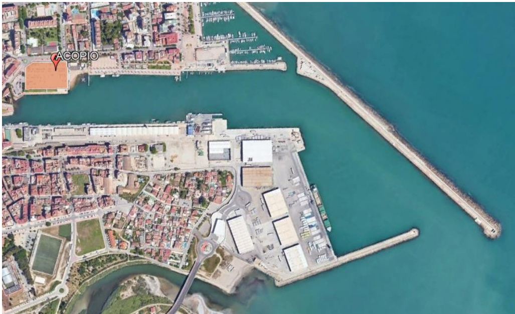
Figura 153: Zona de acopio.
