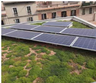
Figura 93 . Instalación de placas solares en cubierta ajardinada. Fuente propia
