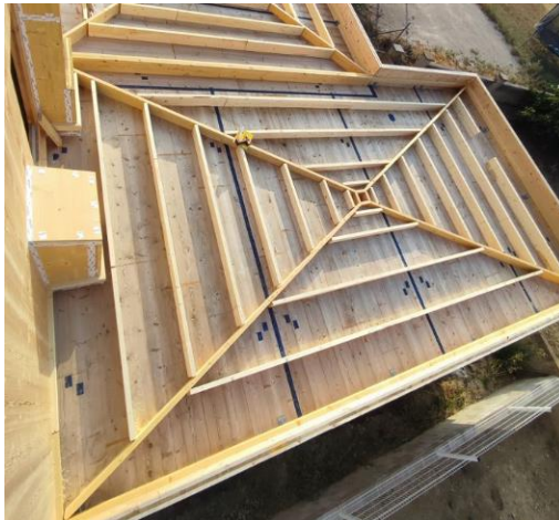
Figura 65. Formación de pendientes con maestras de madera. www.soloarquitectura.com
