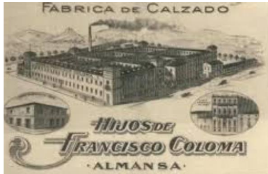
Figura 12. Fábrica de los Colomas. www.googleimágenes
