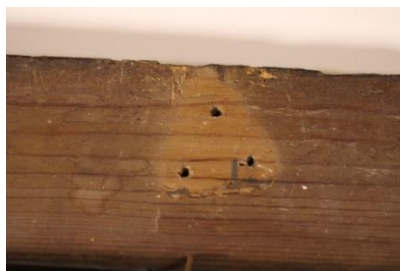
Figura 46. Detalle de los orificios del marco en el reverso.
