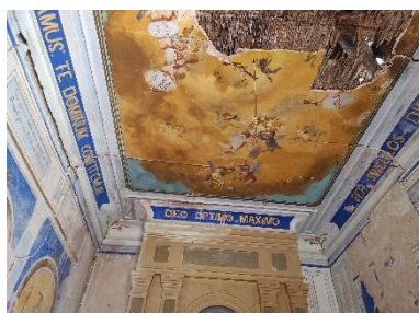
Fig. 30. Techo de la capilla, diciembre 2022
