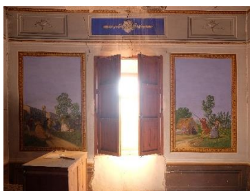
Fig. 3. Fotografía general de la pared sur del salón de Mas de la Foia, diciembre 2022
