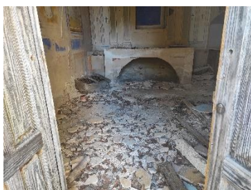
Fig. 29. Suelo de la capilla, diciembre 2022
