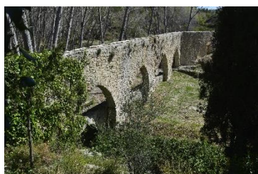
Fig. 20. Acueducto de Planes
