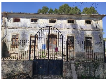
Fig. 1. Fachada exterior principal Mas de la Foia, abril 2023
