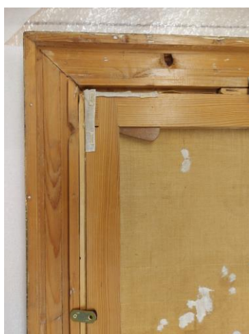
Figura 100. Detalle final del conjunto montado con un sistema de pletinas.
