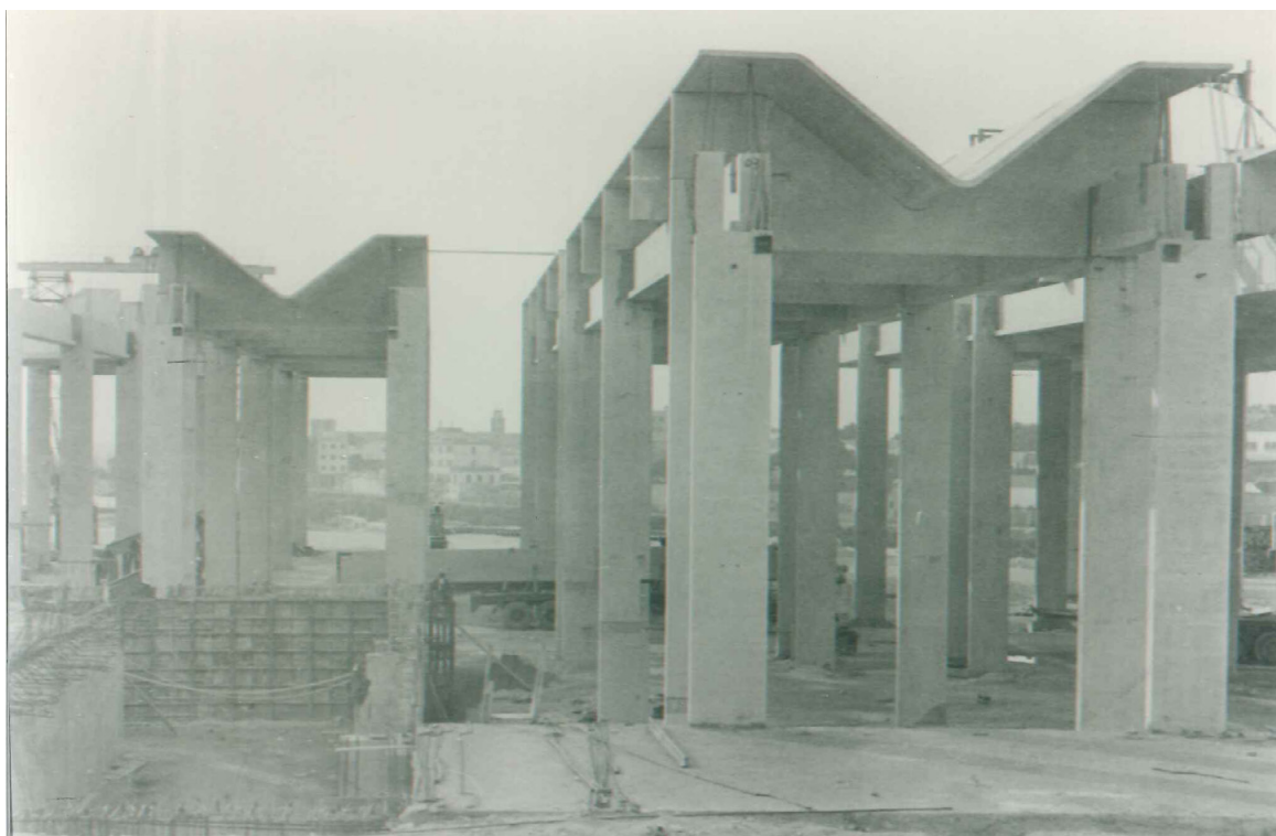
Figura 4. Ejecución de vigas en V de hormigón armado, 1969. Departamento Técnico y de Sistemas de la Feria de Muestras de Valencia, 2021.
