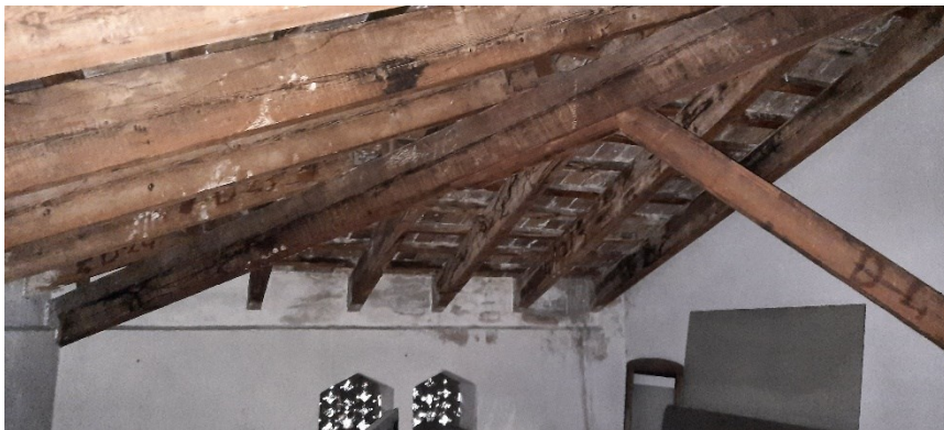
Figura 19. Fotografía de la estructura de la cubierta inclinada. Fuente: Propia.
