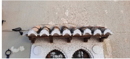
Figura 26. Volado fachada Jardín principal. Fuente: Propia
