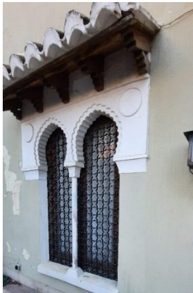
Figura 23. Fotografía de la carpintería tipo que se repite en todas las fachadas. Fuente: Propia
