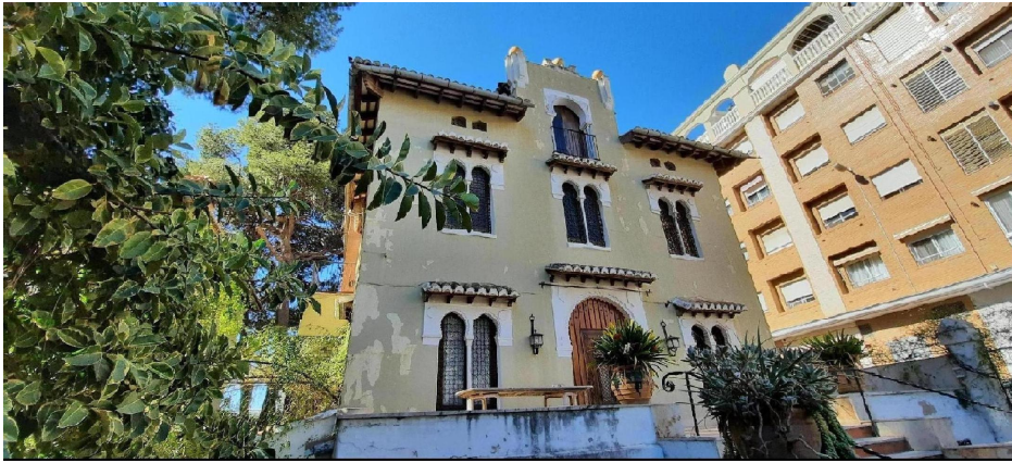
Fotografía de la fachada principal
