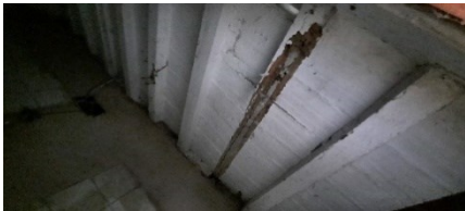
Figura 40. Viguetas de la cubierta del trastero. Fuente: Propia.
