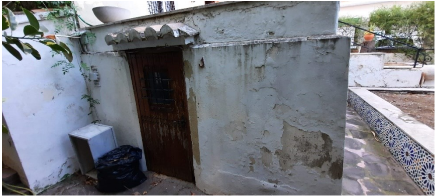
Entrada al semisótano
