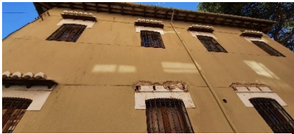
Figura 27. Volados fachada F. García Lorca. Fuente: Propia
