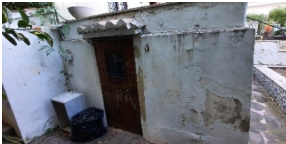
Figura 35. Zócalo de fachada en zona del semisótano. Fuente: Propia
