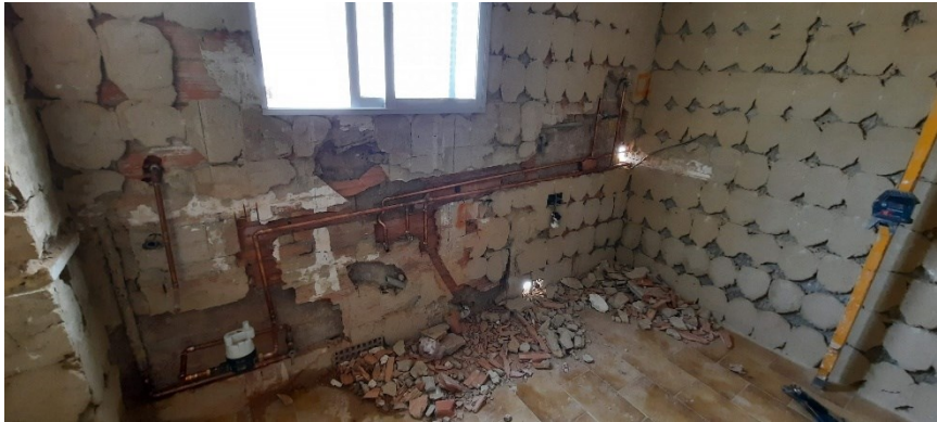
Baño 1. En estado de reforma.
