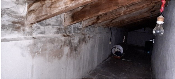
Figura 37. Parte inferior de la cubierta inclinada general. Fuente: Propia.
