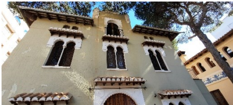
Figura 31. Fachada Trasera. Fuente: Propia
