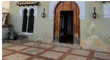
Figura 34. Zócalo de fachada trasera. Fuente: Propia
