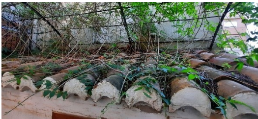
Figura 41. Fotografía del techo de la caseta. Fuente: Propia
