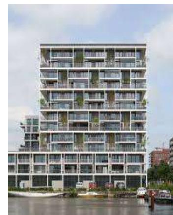
FIG 21. Vista edificio BSH20A
