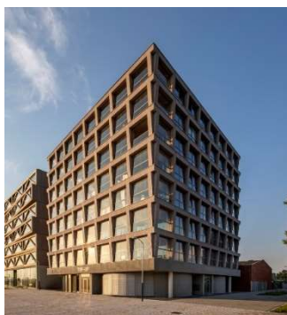
FIG 22. Vista edificio Top-up
