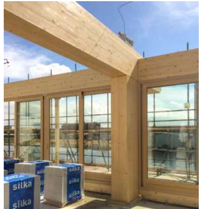
FIG 32. Vigas y columnas glulam del edificio Patch 22
