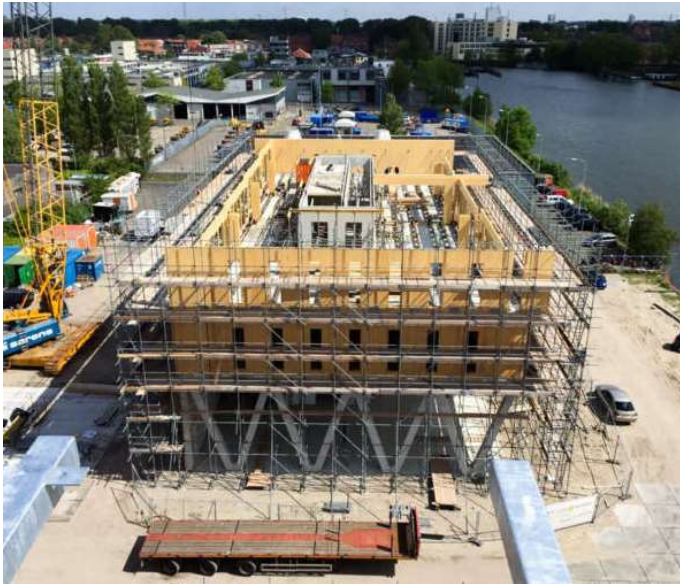
FIG 30. Edificio Patch 22 en construcción con andamios
