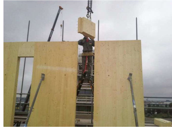
FIG 31. Ensamblaje de un muro de CLT
