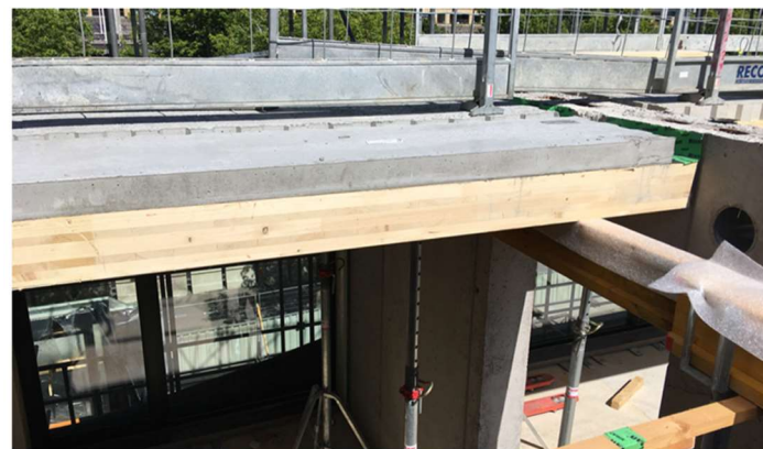
FIG 47. Vista en obra del forjado del edificio HAUT
