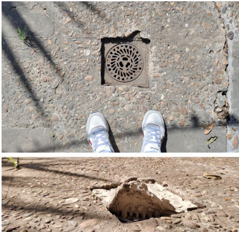
Fig. 4. Proceso de registro de la pieza III (Desagüe) con pasta PRAI refractaria. Técnica del apretón. Ubicación: EASD Sevilla. Fuente: Elaboración propia (2023)
