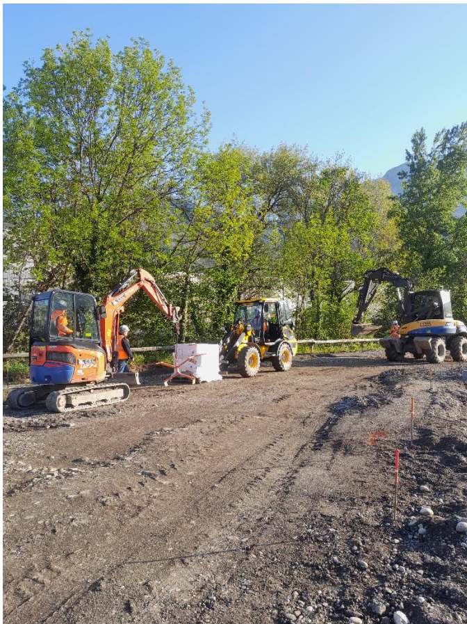
Figure 17 : Pose de béton avec pelle
