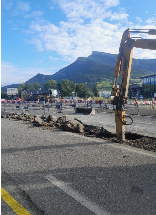
Figure 15 : Démol Avec Pelle + BRH
