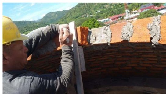
Figura 5.13. construcción de la cúpula de ladrillo. Fuente: Informe final de proyecto facilitado por la empresa constructora CONGESAHN.
