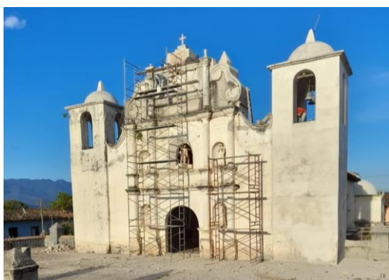
Figura 6.73. Restauración de la fachada principal del templo, San Sebastián. Autor: J. E. Álvarez (octubre 2021).
