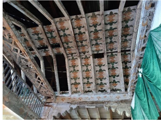
Figura 6.76. Montaje de entablado restaurado siguiendo la codificación elaborada para su desmontaje, San Manuel de Colohete. Autor: J. E. Álvarez (septiembre 2023).
