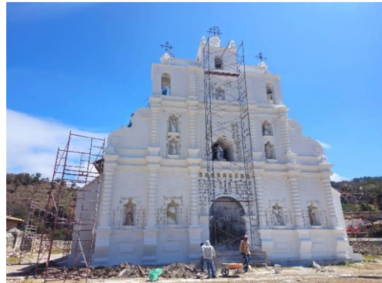
Figura 6.78. Finalización de los trabajos de restauración en fachada, San Manuel de Colohete. Autor: J. E. Álvarez (febrero 2024).
