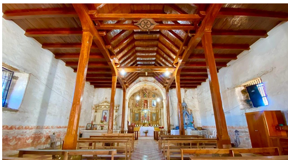
Figura 6.64. Artesón restaurado de la iglesia de San Sebastián Mártir, San Sebastián, Lempira (Honduras). Fuente: Fondo fotográfico de la Mancomunidad Colosuca (2020).
