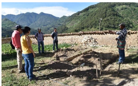
Figura 6.71. Supervisión a la construcción de bateas para el tratamiento de la cal en la casa cural de San Manuel. Autora: R. Roperó (2018).
