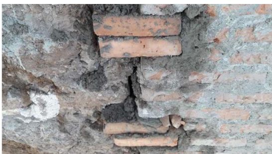
Figura 5.12. Reparación de grietas causadas por la unión de sistemas distintos (muros adobe y ladrillo cemento) con endentados de ladrillo y mortero. Fuente: Informe final de proyecto facilitado por la empresa constructora CONGESAHN.
