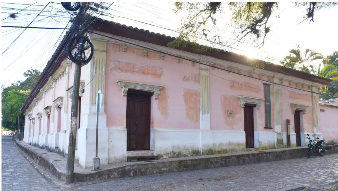
Figura 6.12. Vista exterior de casa Galeano desde el extremo de la plaza San Sebastián. Autora: A. Ferrando Ortiz (enero 2024).
