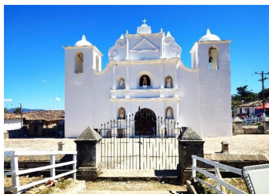
Figura 6.74. Resultado de la restauración de fachada, San Sebastián. Autor: J. E. Álvarez (enero 2023).
