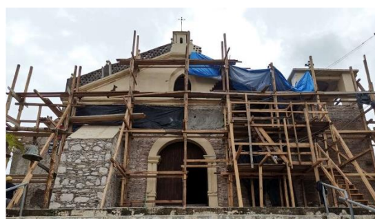
Figura 5.11. Fachada de la iglesia católica de Marale durante su restauración. Fuente: Informe final de proyecto facilitado por la empresa constructora CONGESAHN (2022).
