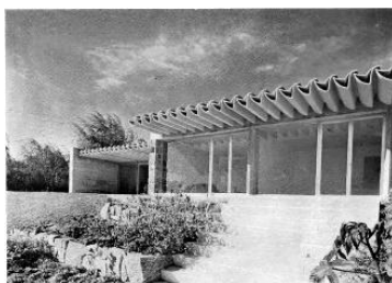
F. 29_ Vista de la marquesina del patio de entrada, resuelta con vigas hueso. (Fuente: (Fundación Docomomo Iberico, s.f.))
