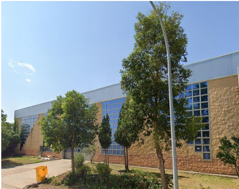
Figura 6. Cara norte de la nave de mayor tamaño.
