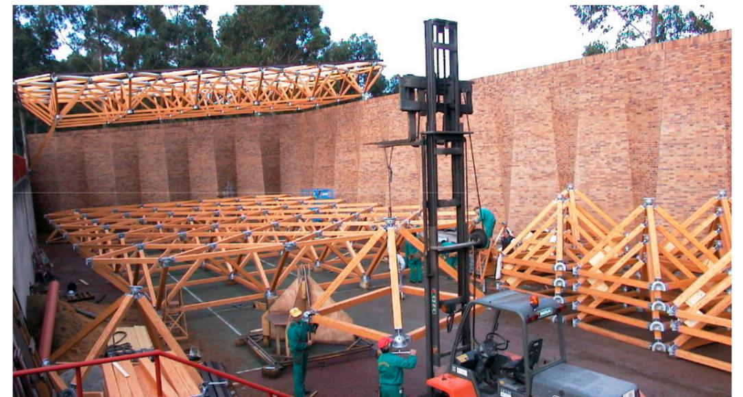
La celosía se transporta mediante la apilación de sus módulos semioctaédricos. Una vez en el lugar, se va montando la celosía por tramos y se va levantando para colocarla en su posición final. Ésta es una manera de facilitar su transporte y su puesta en obra, optimizando el espacio necesario para almacenar la celosía.
