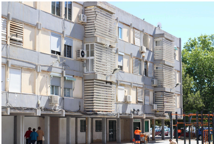
Figura 3.3. Bloque de viviendas A4-3. Fachada sur.
