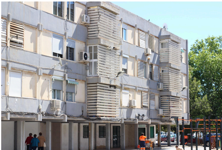
Figura 3.8. Vista general de la fachada sur. Imagen de autor.
