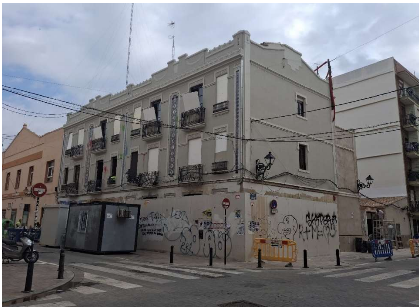
Figura 53. Edificio en construcción del nuevo hotel boutique.
