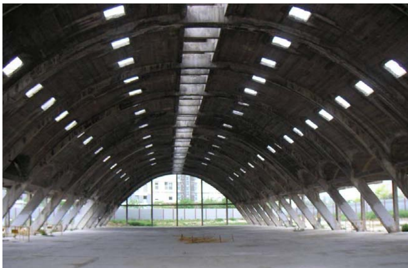
Ilustración 10.84. Interior de la nave (Diana Sánchez, 2006).
