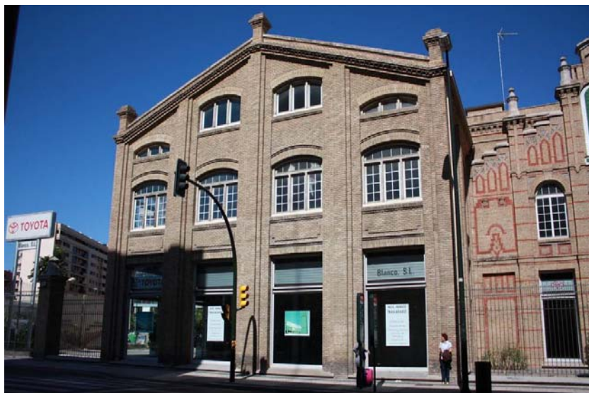
Ilustración 7.28. Imágenes del estado actual, Diana Sánchez, 2008.
