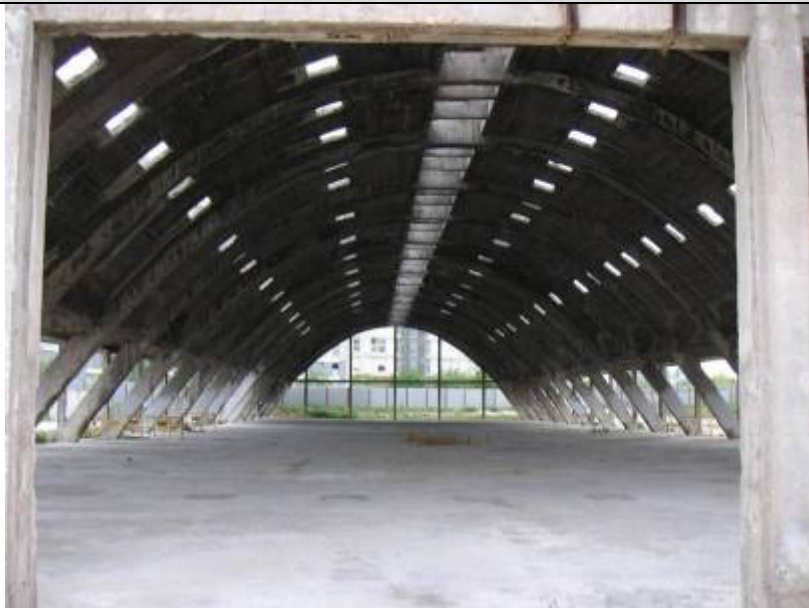
Interior de nave totalmente diáfana.
