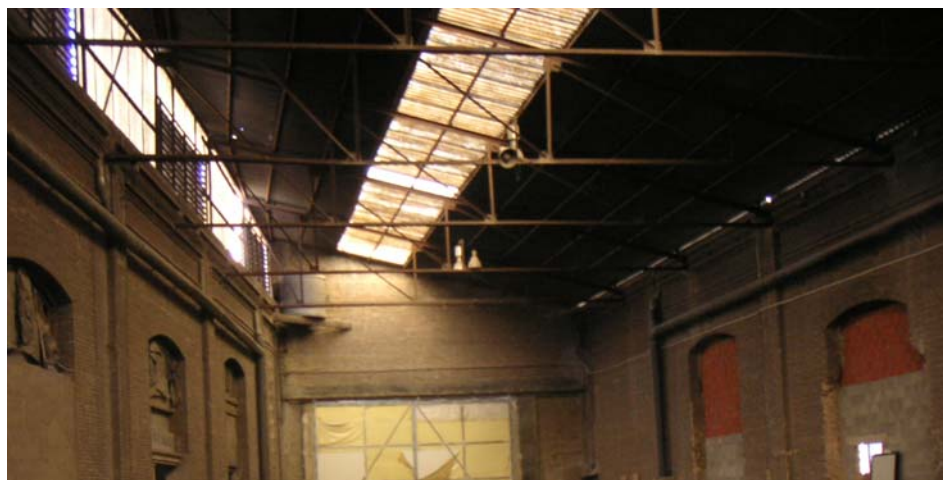
Ilustración 10.40. Vista de la cubierta del patio (Diana Sánchez, 2007).
