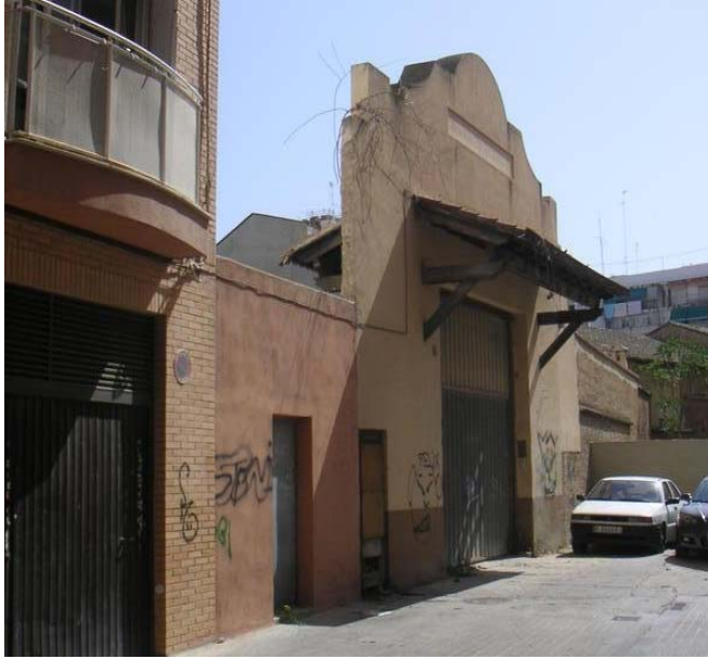
Ilustración 3.12. Mantenimiento del pórtico de antiguo almacén como cierre de solar en C/ de la Guatla en Valencia (Diana Sánchez 2009).
