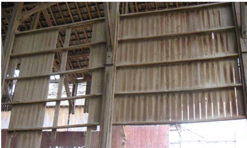
Ilustración 10.77. Vista interior del cerramiento de madera (Diana Sánchez, 2006).
