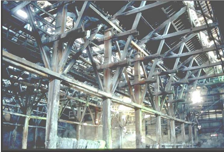
Ilustración 10.92. Vista del interior de las naves Fesa-Ercros. Fotografía de José Eugenio Villar Ibáñez. 464
