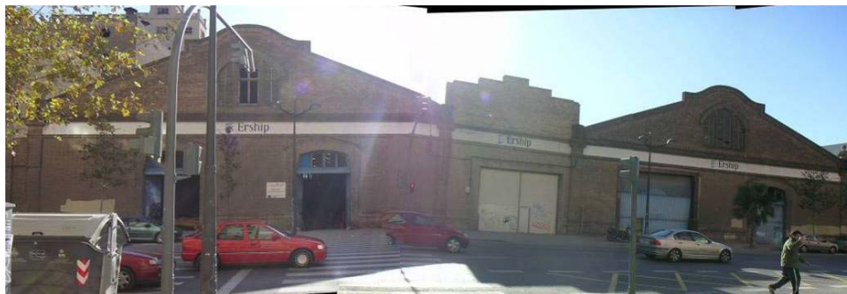
Ilustración 10.33. Panorámica de fachada principal, c/ Joan Verdeguer. (Diana Sánchez, 2007).
