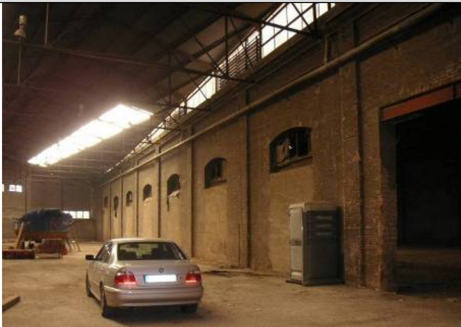
Vista interior de patio cubierto.
