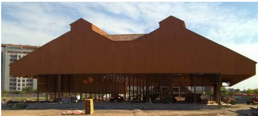
Ilustración 10.98. Imagen de la nave A reconstruida (Diana Sánchez, 2010).
