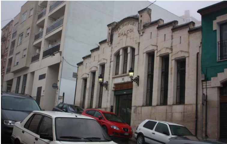
Ilustración 2.30. Antiguo taller en casco urbano de Alcoy (1914), transformado en Tanatorio (Diana Sánchez, 2011).
