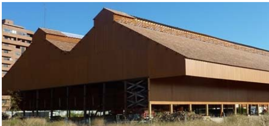
Ilustración 10.86. Vista de la nave A rehabilitada (Diana Sánchez, 2010).
