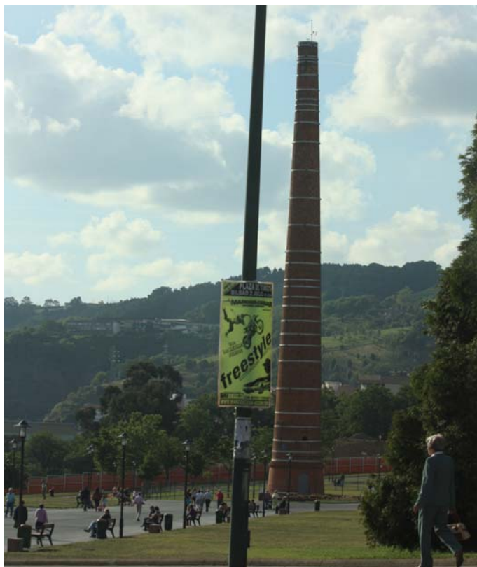
Ilustración 3.34. Chimenea de antigua la Fundición Echevarría, Bilbao (Diana Sánchez, 2011).
