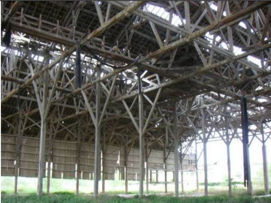
Interior de nave A
