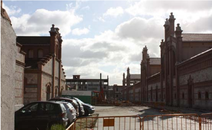
Ilustración 3.20. Vista exterior de parte del conjunto del Matadero de Madrid (Diana Sánchez, 2009).
