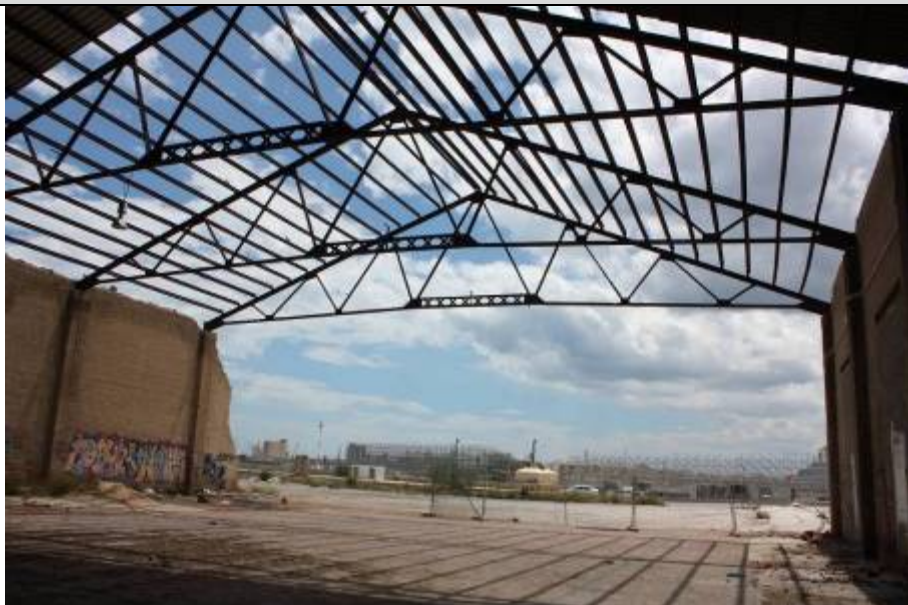
Vista interior de nave izquierda, no existe fachada posterior.
