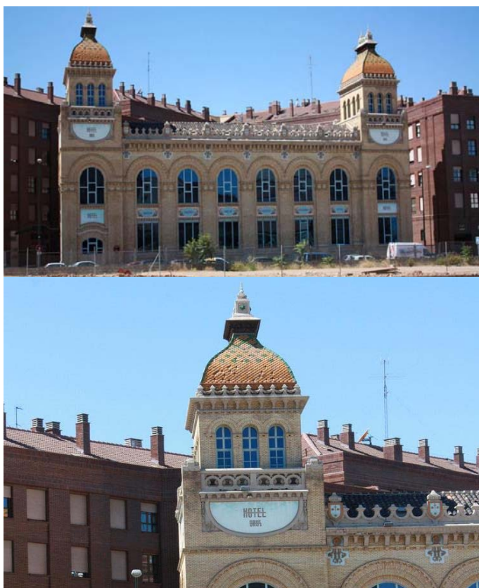
Ilustración 7.23. Vista de fachada principal, Diana Sánchez, 2008.
