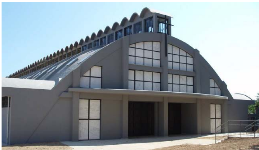
Ilustración 10.100. Estado de la nave tras su reconstrucción en iglesia (Diana Sánchez, 2010).
