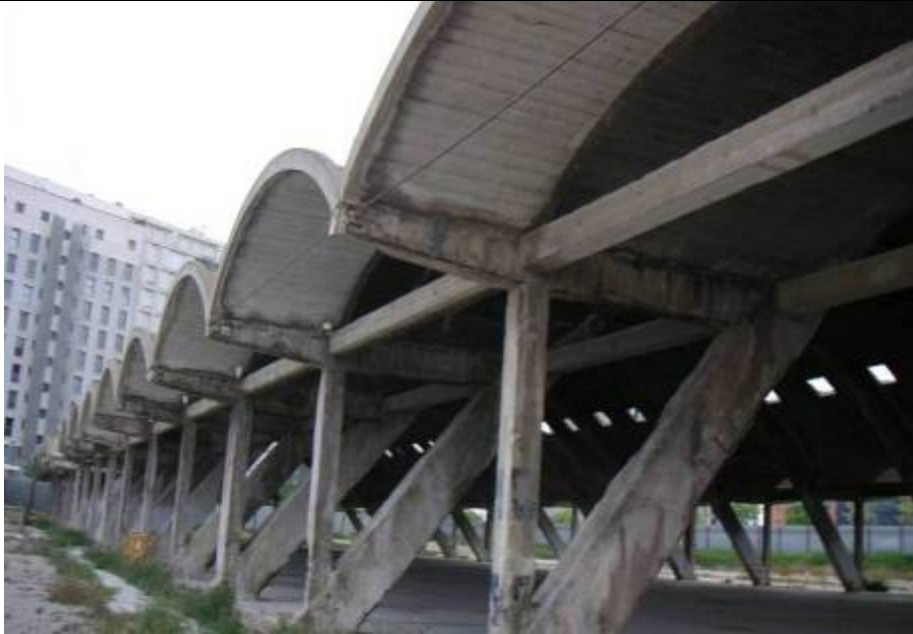
Vista lateral de la nave, estructura auxiliar, con bóvedas perpendiculares a la bóveda principal.
