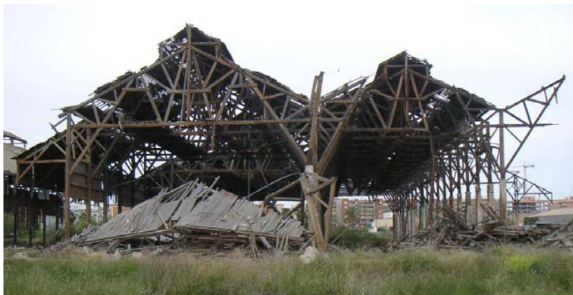
Ilustración 10.74. Nave de 3 vanos, uno de ellos desaparecido (Diana Sánchez, 2006).
