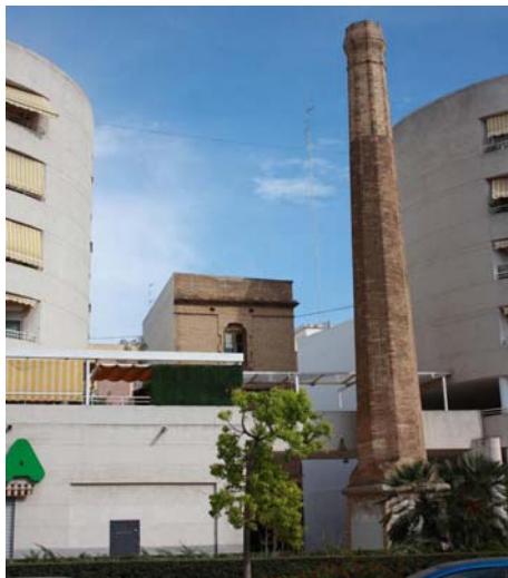
Ilustración 3.5. Chimenea mantenida en Avd. Serrería de Valencia, hallándose la entrada a los bloques de viviendas pegada a la misma (Diana Sánchez, 2008).
