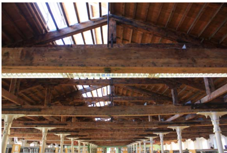
Ilustración 3.33. Interior de Vapor Vell, Barcelona, rehabilitado y transformado en biblioteca (Diana Sánchez, 2012).
