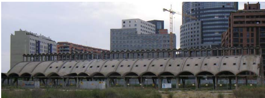
Ilustración 10.83. Vista exterior de la nave, cubierta de la bóveda de hormigón (Diana Sánchez, 2006).
