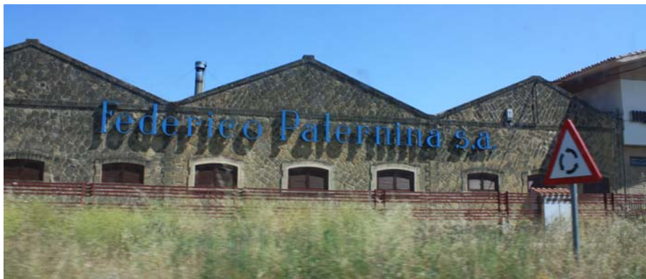
Ilustración 3.17. Vista de la fachada de la Bodega de Federico Paternina de Haro - La Rioja- (Diana Sánchez 2011)
