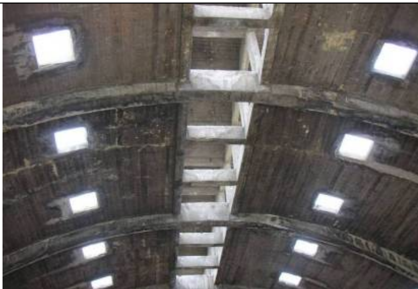
Detalle de bóveda y arcos de hormigón. Vista de huecos cenitales y lucernario para iluminar el interior.
