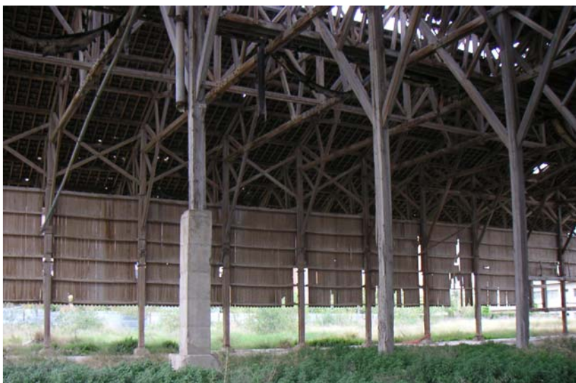
Ilustración 10.97. Interior nave A (Diana Sánchez, 2005).
