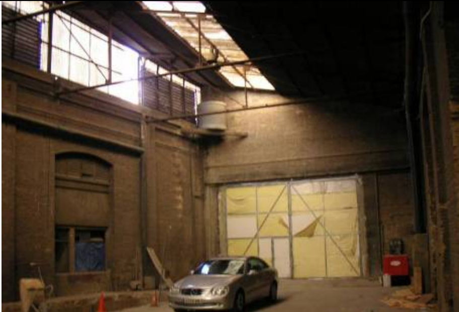
Vista interior de patio cubierto, fachada principal.
