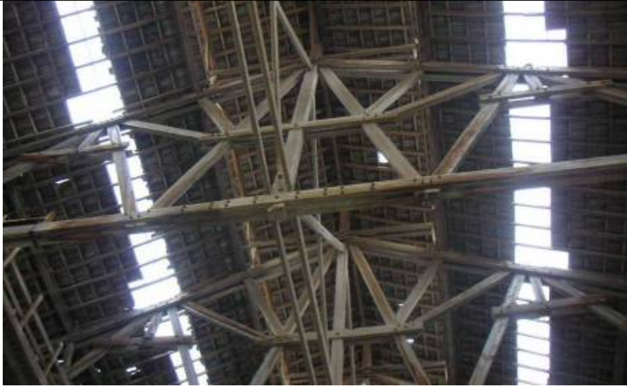
Vista de cerchas de madera y del anclaje entre ellas mediante cruces del mismo material.
