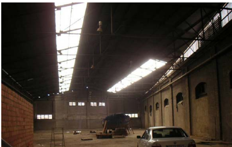
Ilustración 10.36. Interior del patio, vista de cerchas enteras (Diana Sánchez, 2007).
