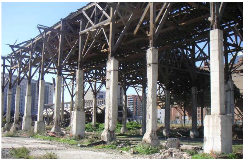
Ilustración 10.85. Pylares reforzados con hormigón de la nave B (Diana Sánchez, 2008).
