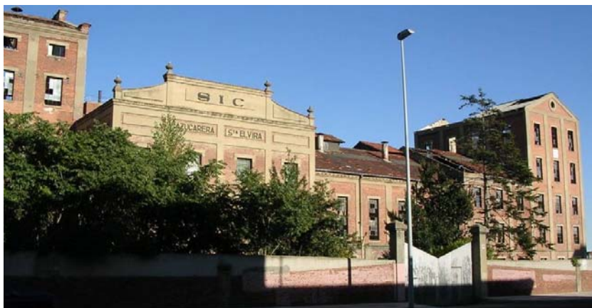
Ilustración 7.41. Estado actual de la azucarera (Diana Sánchez, 2008).
