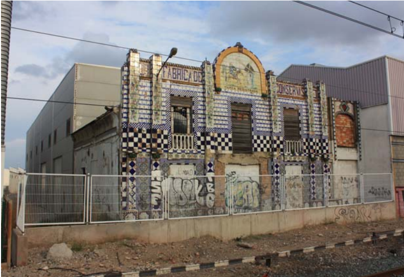
Ilustración 3.36. Antigua fábrica de conservas en el polígono industrial de Catarroja, Valencia (Diana Sánchez, 2011).
