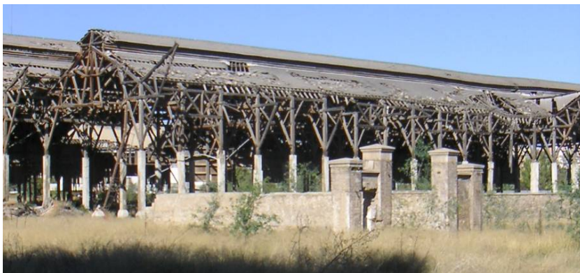
Ilustración 10.96. Vista de la nave B y de parte del muro aún existente (Diana Sánchez, 2005).
