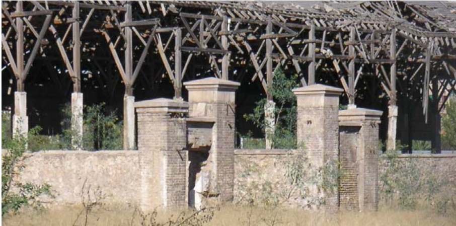
Ilustración 10.64. Imagen de parte del muro que se mantenía en el año 2005 (Diana Sánchez, 2005).
