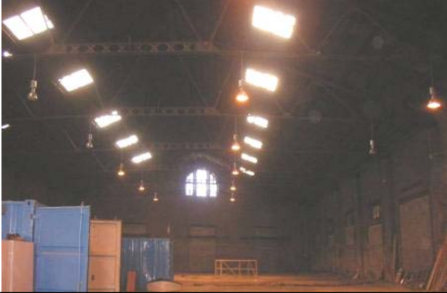
Vista interior de nave izquierda del conjunto.
