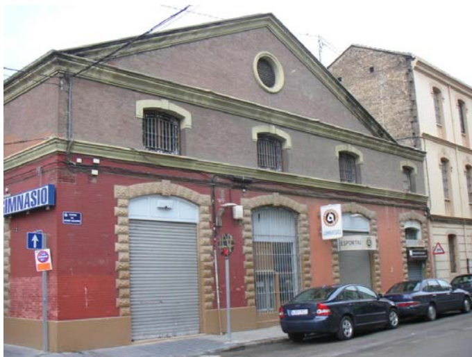
Ilustración 3.4. Antigua nave industrial en C/ Josep Aguirre en Valencia reutilizada como gimnasio (Diana Sánchez, 2008).
