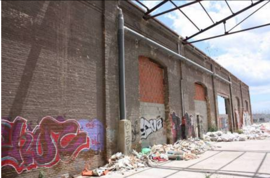
Fachada lateral de naves que conformaban el antiguo patio.
