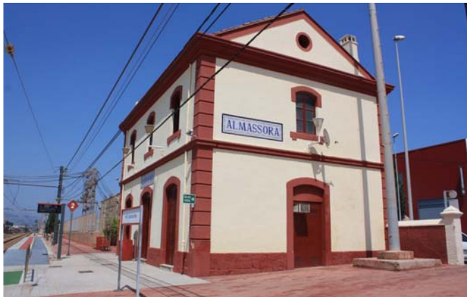
Ilustración 2.33. Estación de tren de Almassora, Castellón (Diana Sánchez, 2011).
