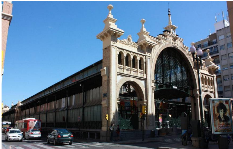
Ilustración 2.14. Mercado Central de Zaragoza, actualmente sigue en funcionamiento (Diana Sánchez, 2008).
