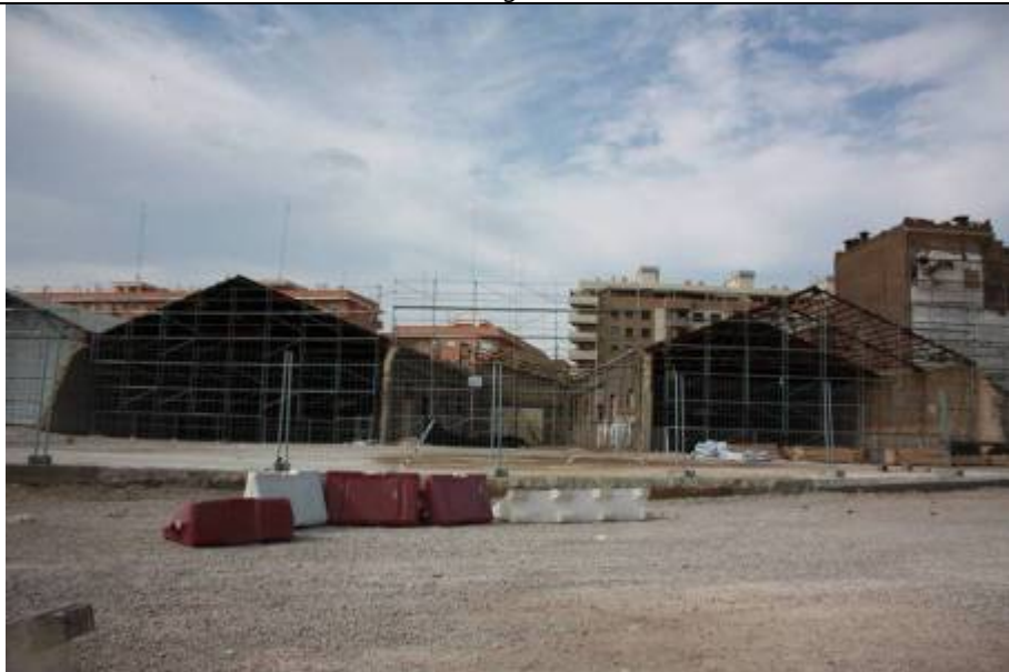
Vista posterior de las naves, ya no existe la fachada trasera.
