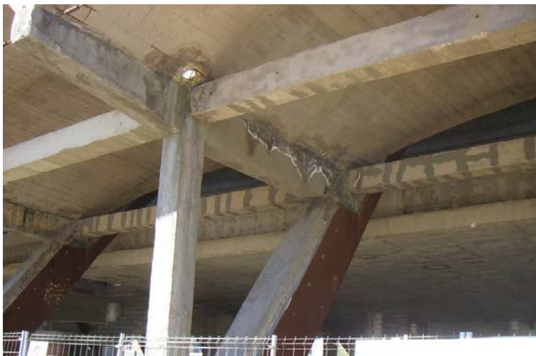
Ilustración 10.89. Regeneración de volúmenes de hormigón (Diana Sánchez, 2008).
