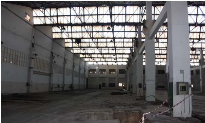
Ilustración 2.25. Interior de nave de talleres de motores de Elcano, Quart de Poblet (Diana Sánchez 2011).
