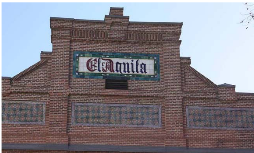
Ilustración 7.1. Imagen de fachada con detalles en cerámica, (Diana Sánchez, 2009).
