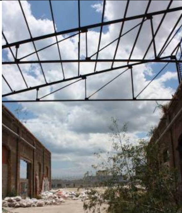
Vista interior de antiguo patio, no existe fachada posterior
