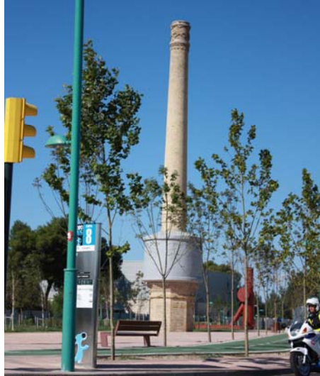
Ilustración 3.6. Chimenea exenta en la ciudad de Zaragoza (Diana Sánchez, 2008).
