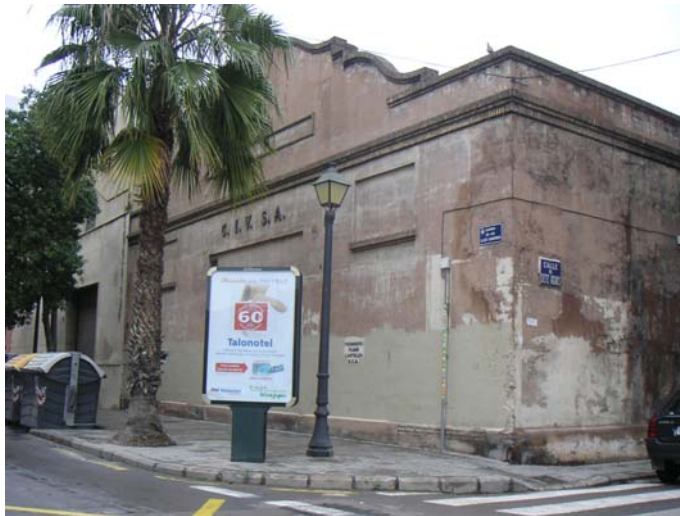
Ilustración 1.2. Nave abandonada de CIV S.A. en C/ Siete Aguas en Valencia, dentro de la trama urbana (Diana Sánchez, 2008).
