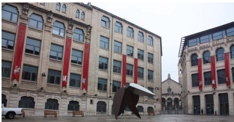
Ilustración 3.19. Vista de Plaza de la Universidad de Alcoy con las antiguas fábricas de Ferrándiz y Carbonell rehabilitadas y transformadas en espacios universitarios (Diana Sánchez, 2011)
