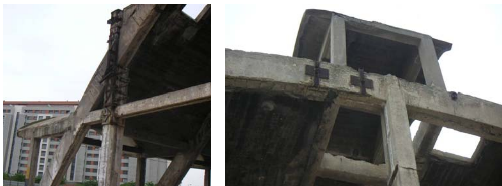
Ilustración 10.88. Imágenes de refuerzos metálicos (Diana Sánchez, 2006).
