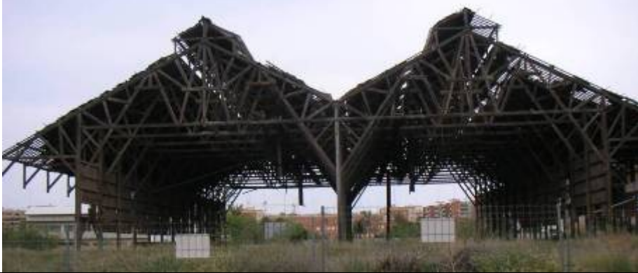
Estado de la nave A, se ve que su estado es "mejor" que la nave B.
